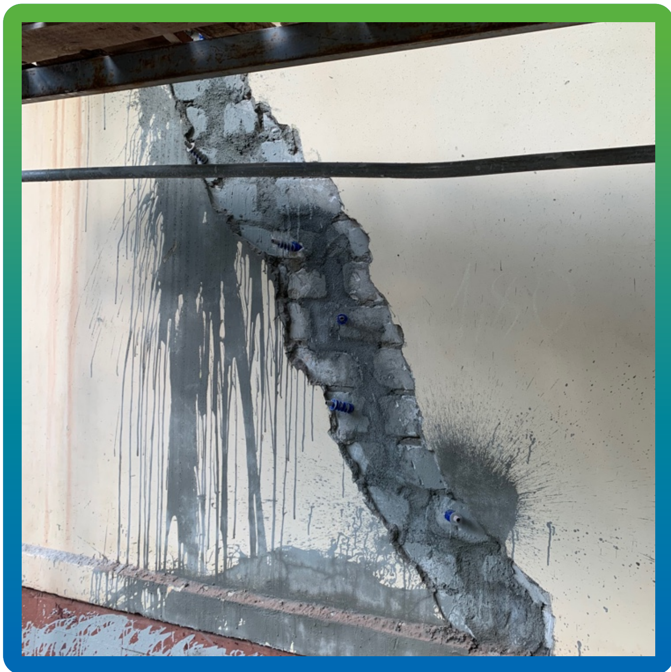
Трещина, проинъектированная составом Маноцем Гроут
