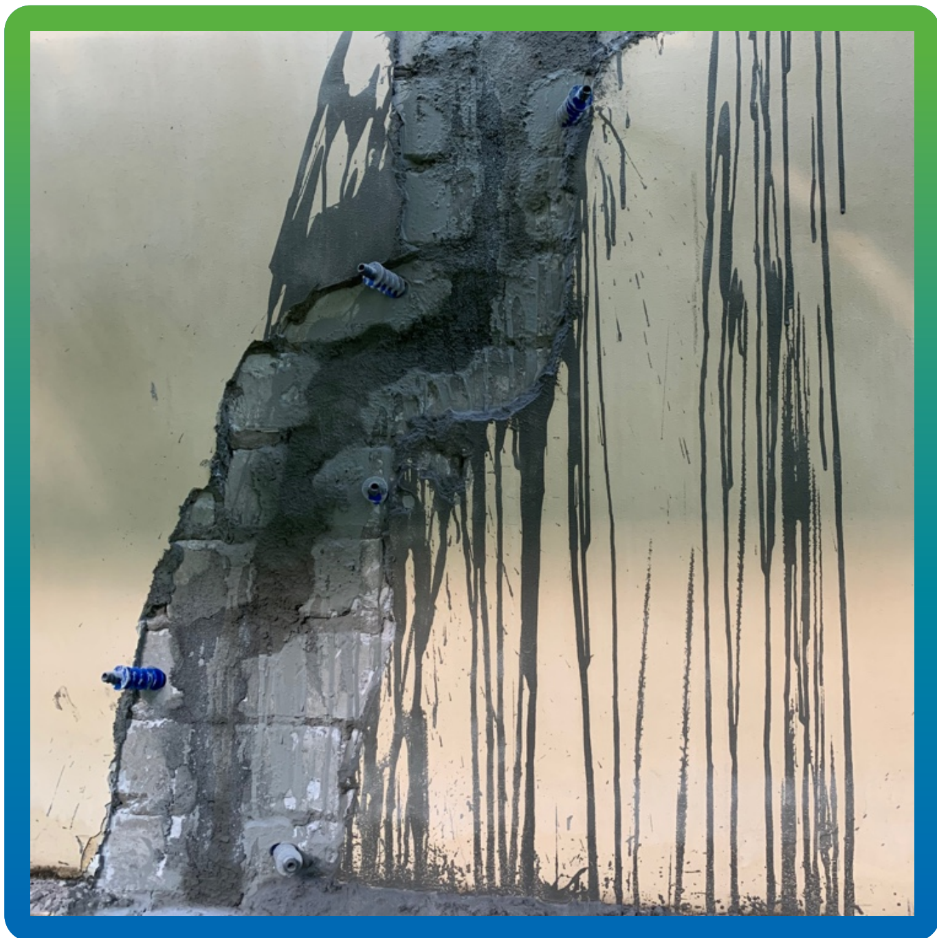
Трещина, проинъецированная составом Маноцем Грут
