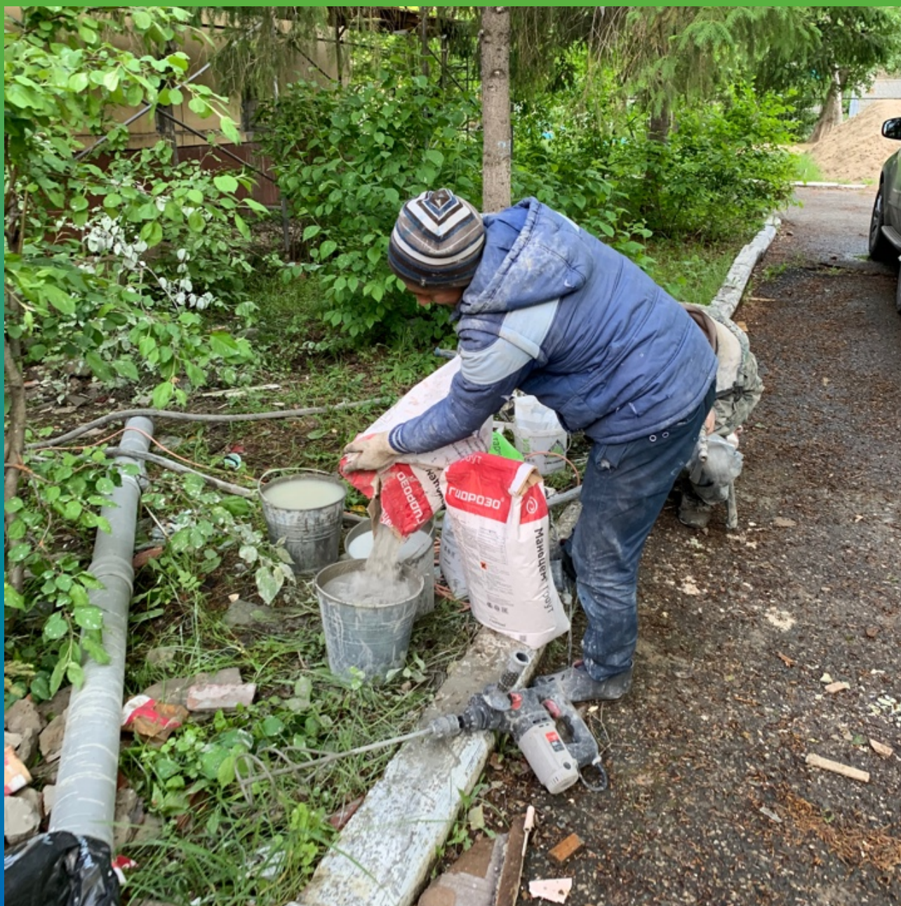
Замешивание инъекционного состава Маноцем Гроут
