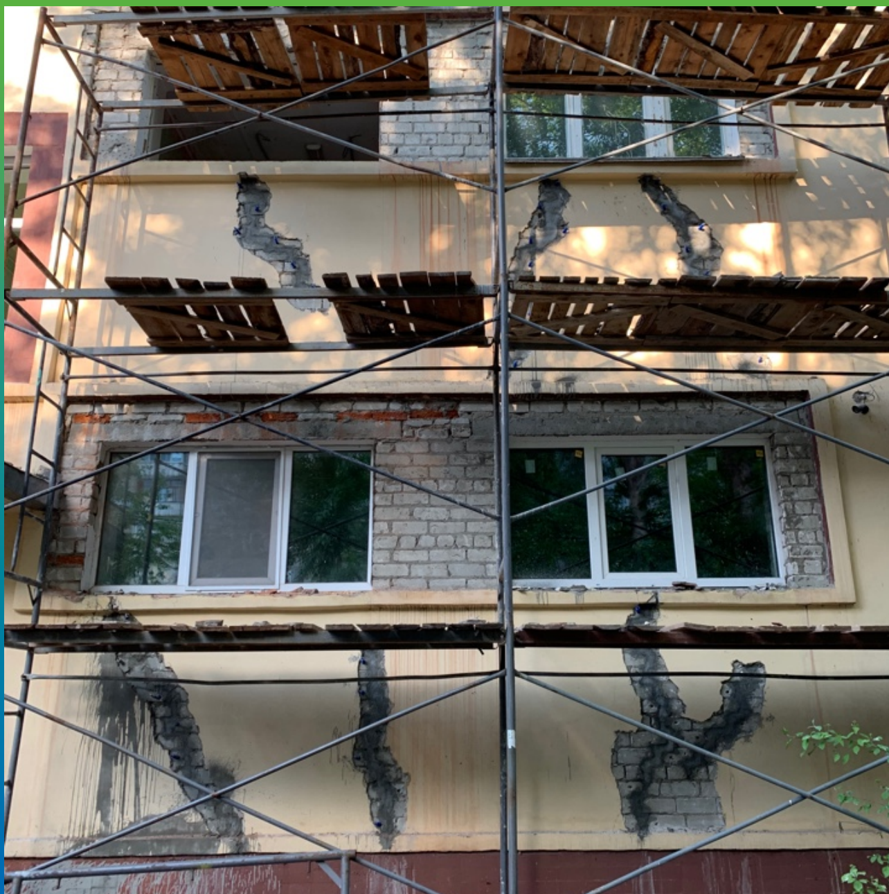
Общий вид проинъектированного участка
