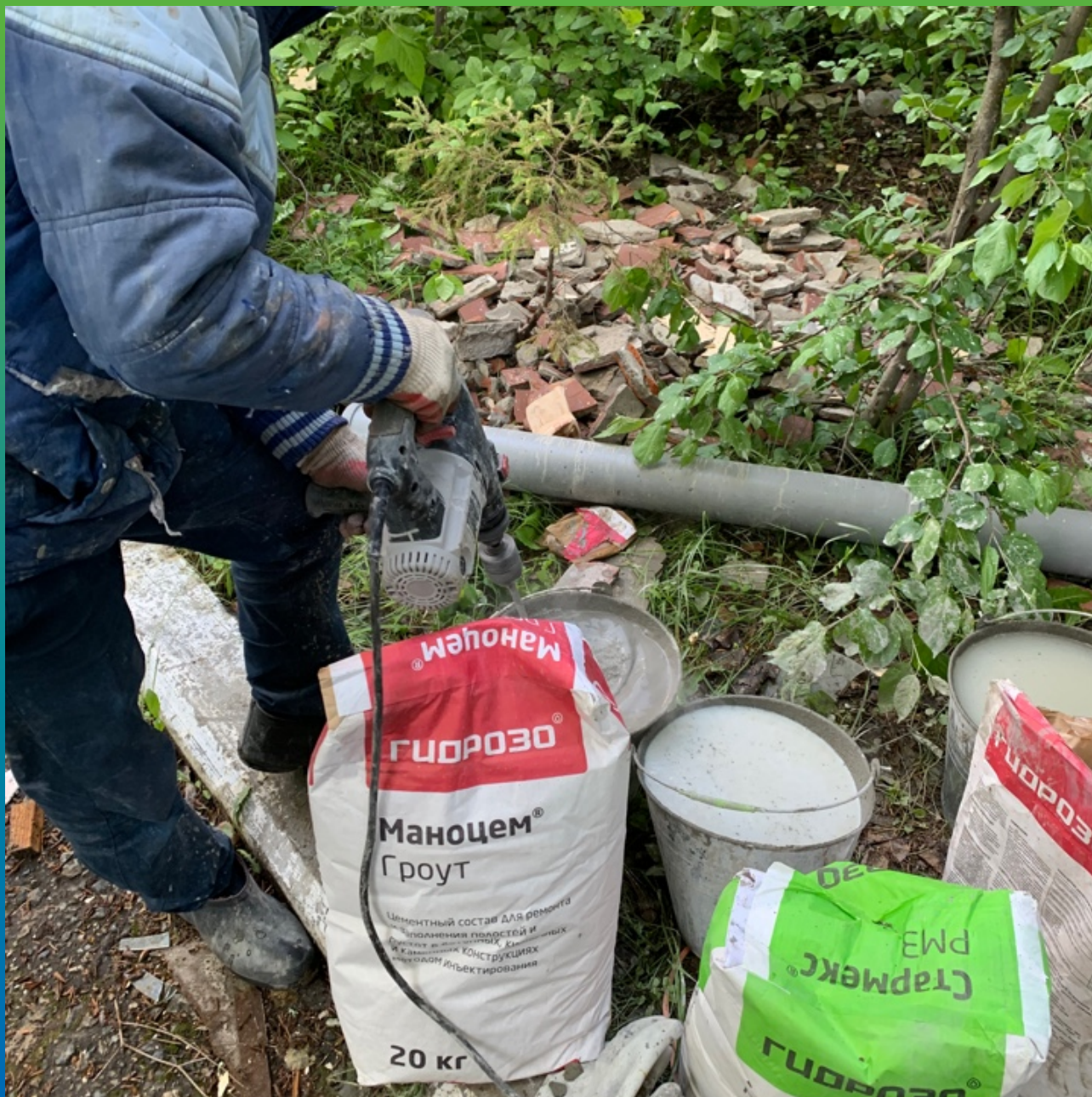
Замешивание инъекционного состава Маноцем Гроут
