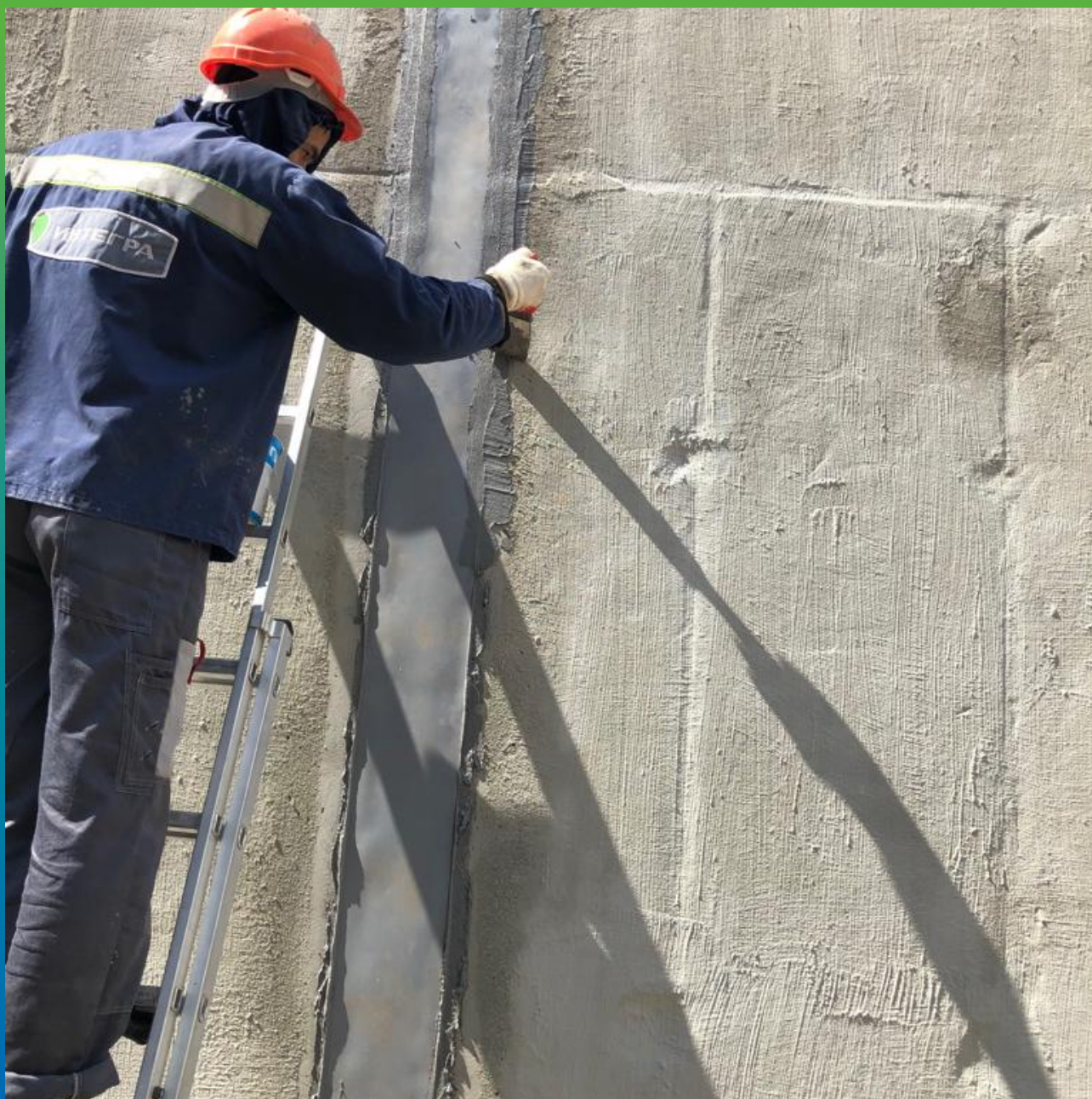
Монтаж ленты Манодил Про
