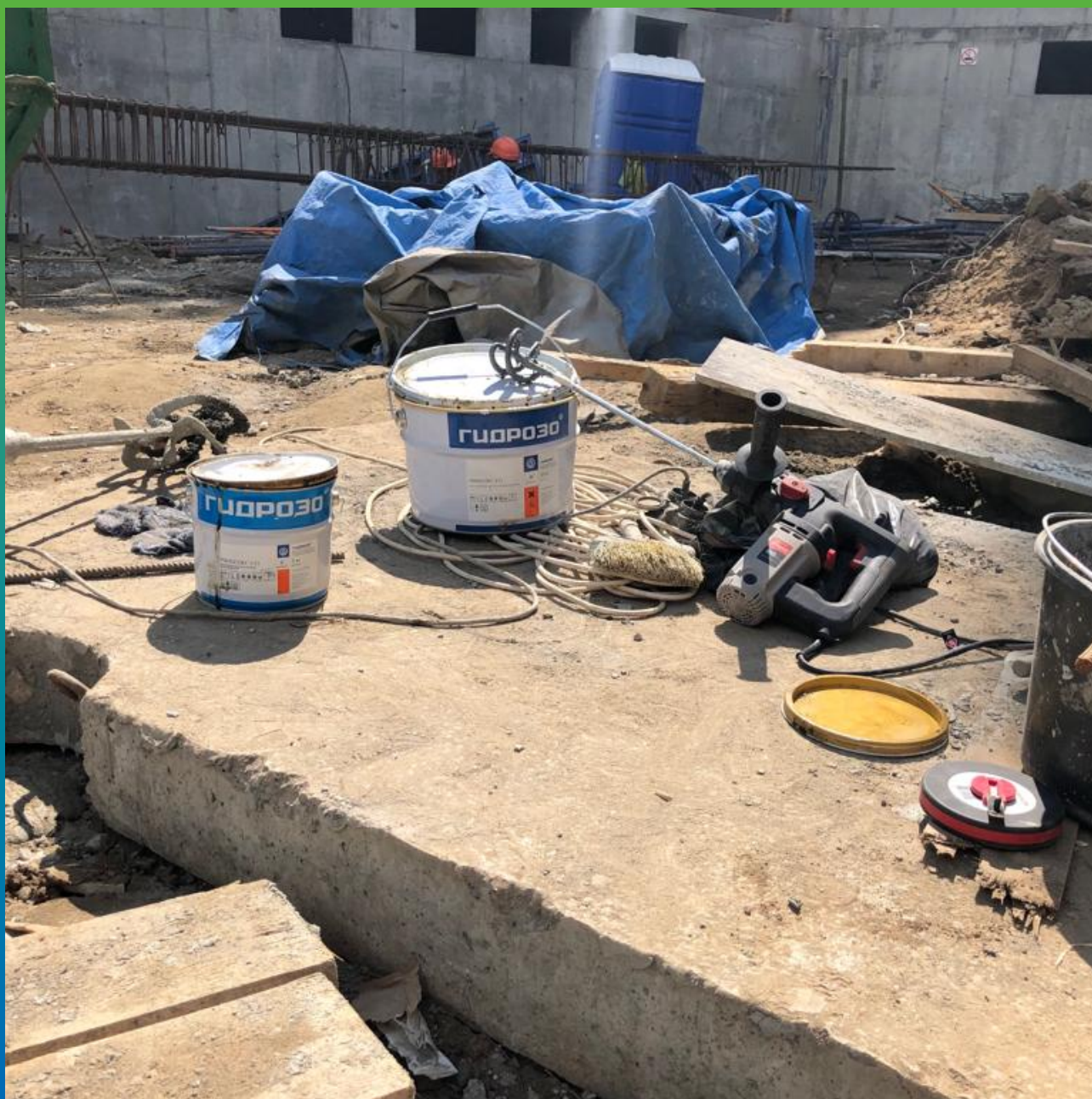
Подготовка материала к монтажу
