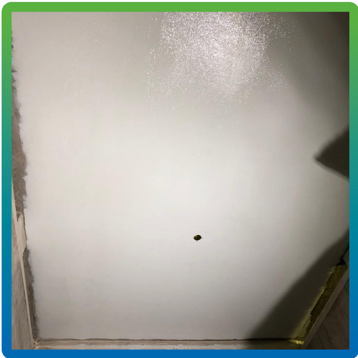
Нанесенный на потолок материал Денстоп ЭП 205
