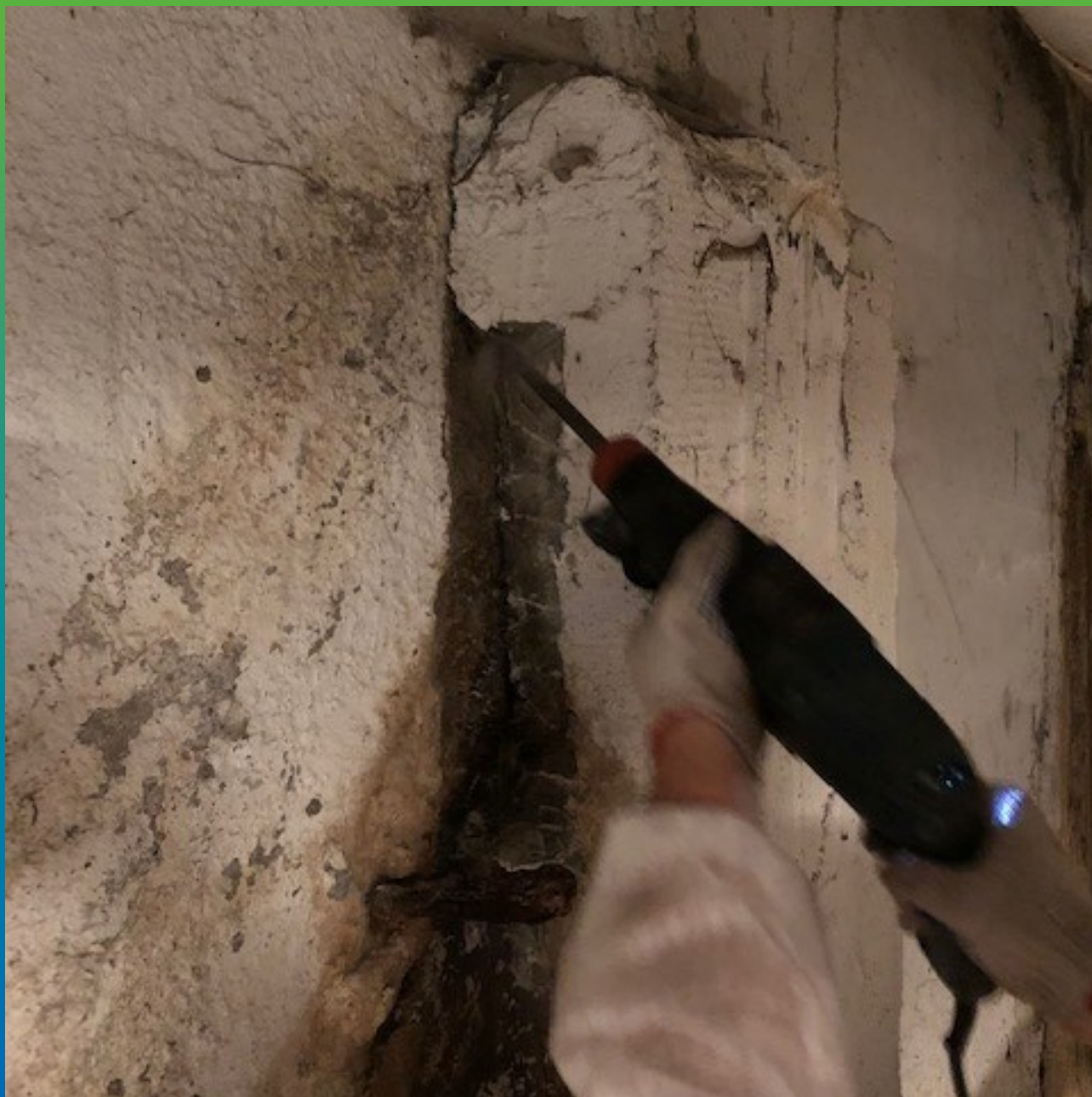
Подготовка участка. Удаление заделки шва.
