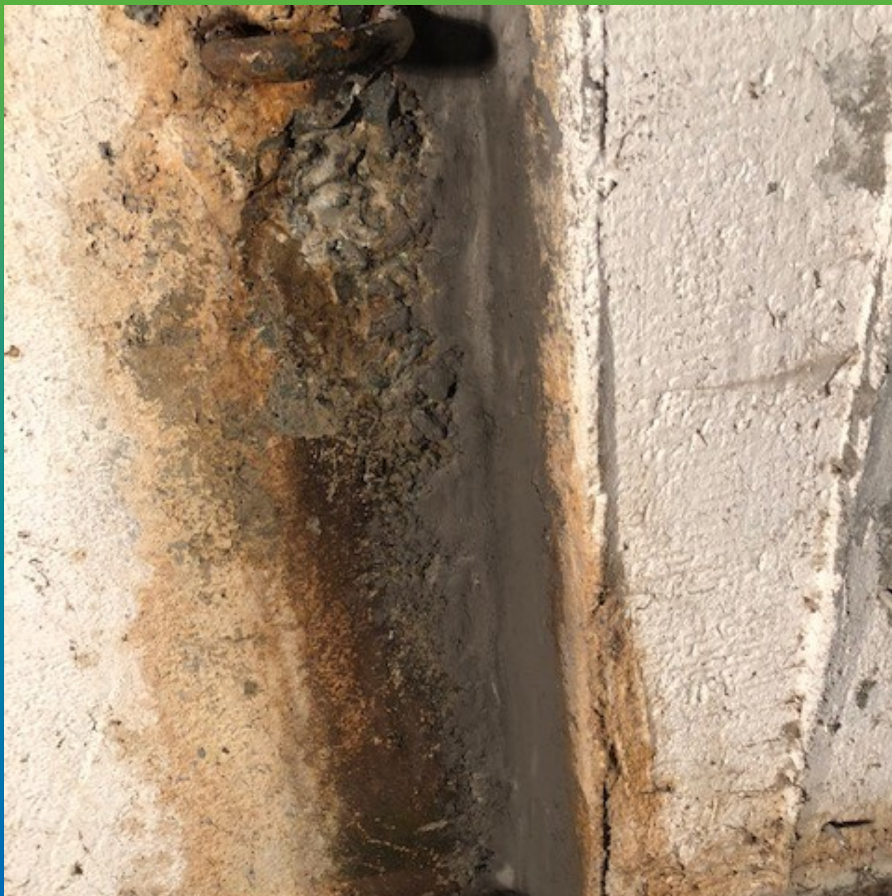
Заделка шва гидропломбой "Стармекс Плаг"
