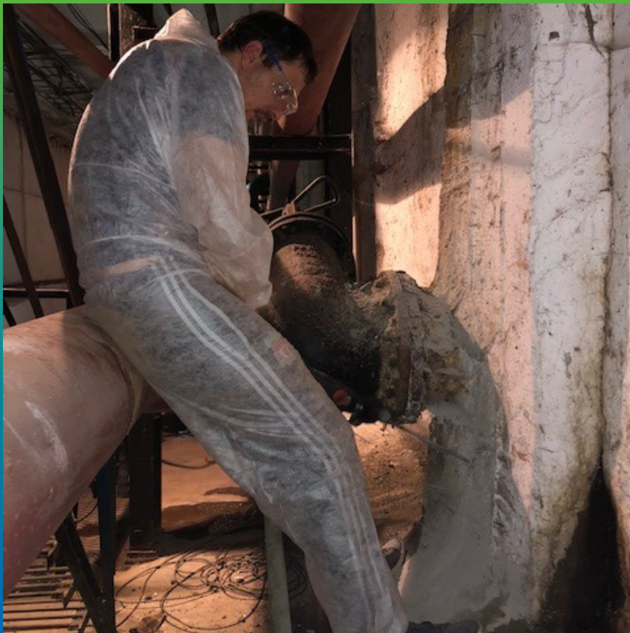
Бурение каналов для монтажа инъекторов
