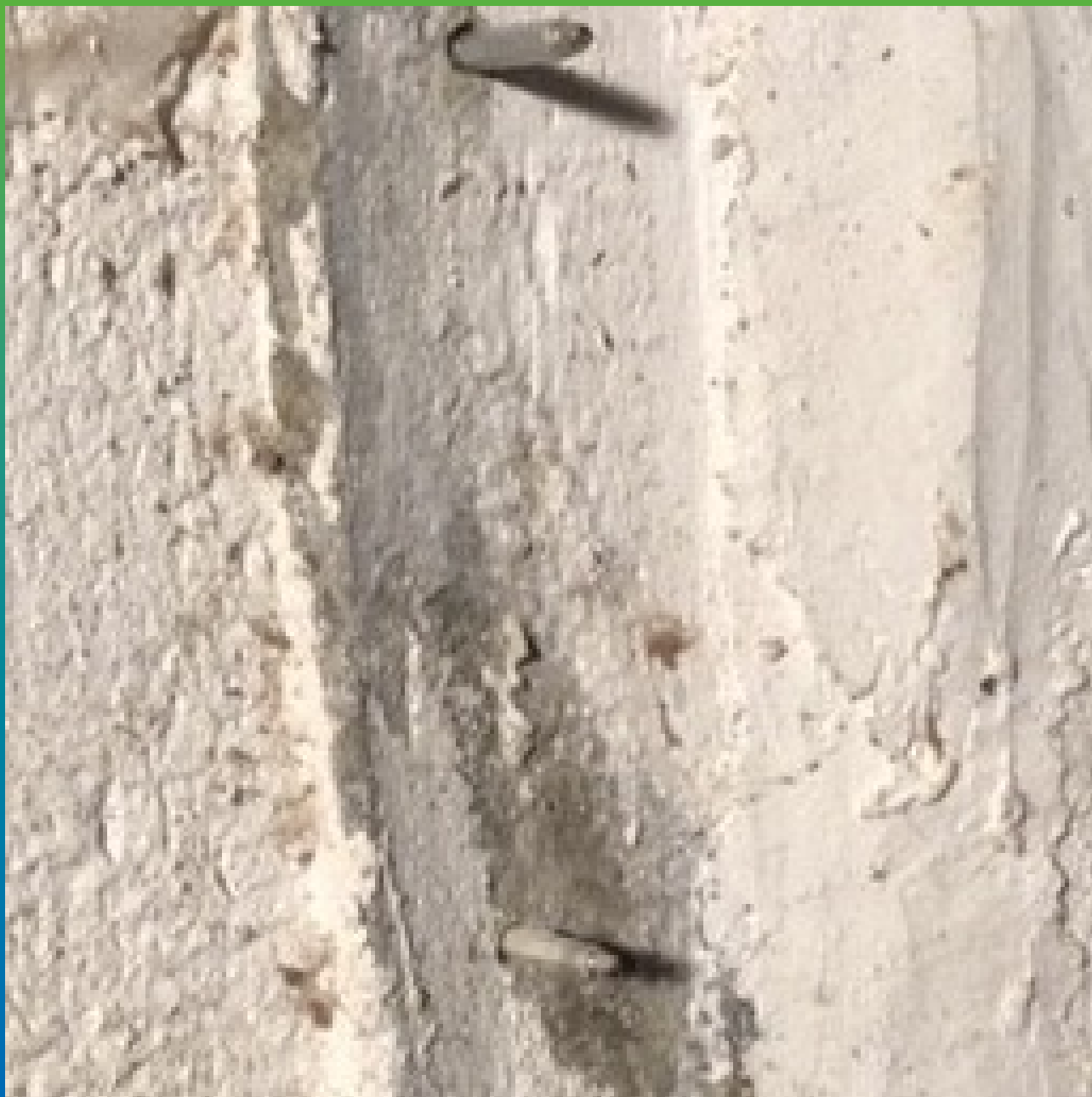
Установка инъекционных пакеров БМ 1100
