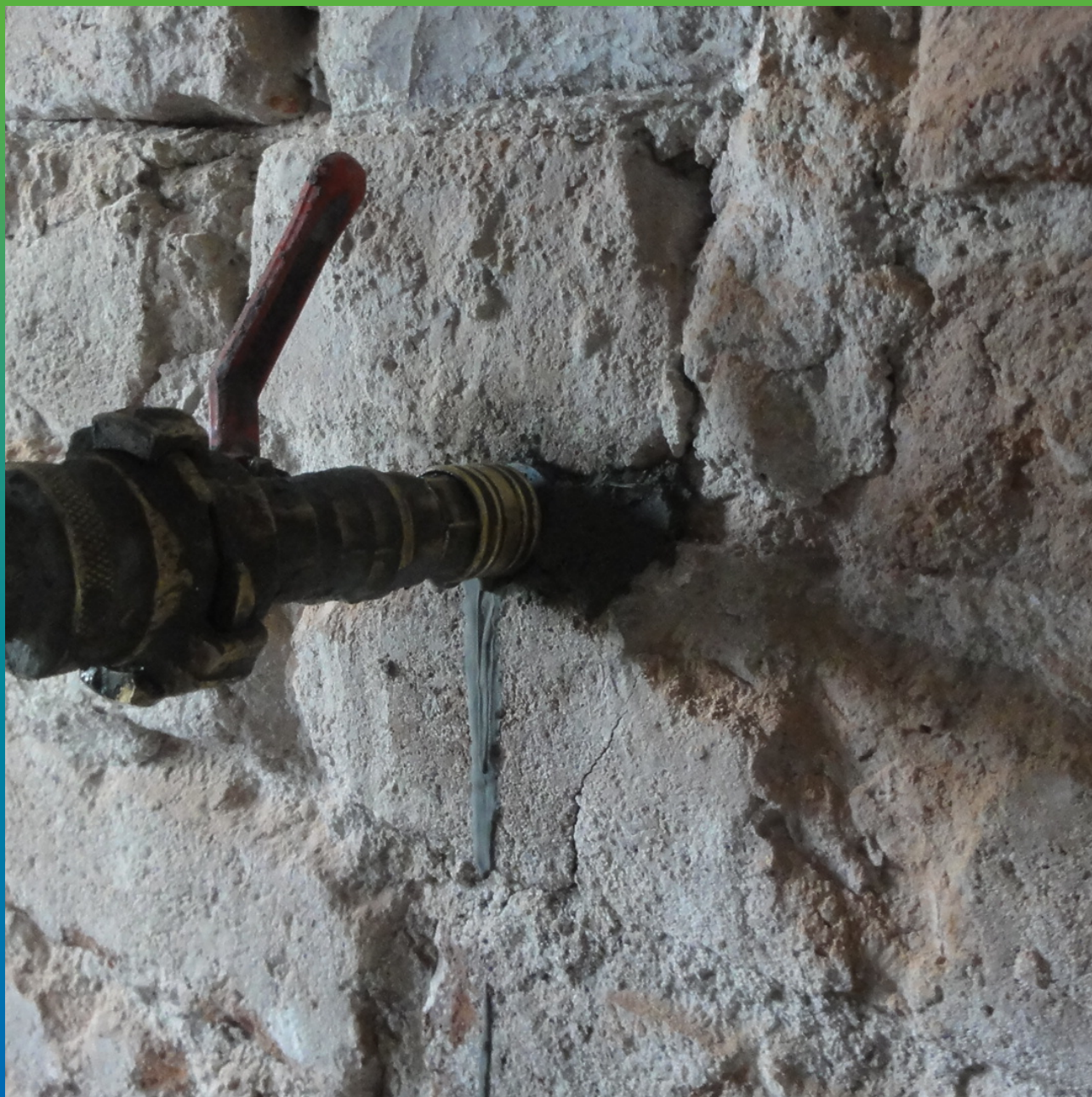
Инъектирование минеральным составом Маноцем Гроут
