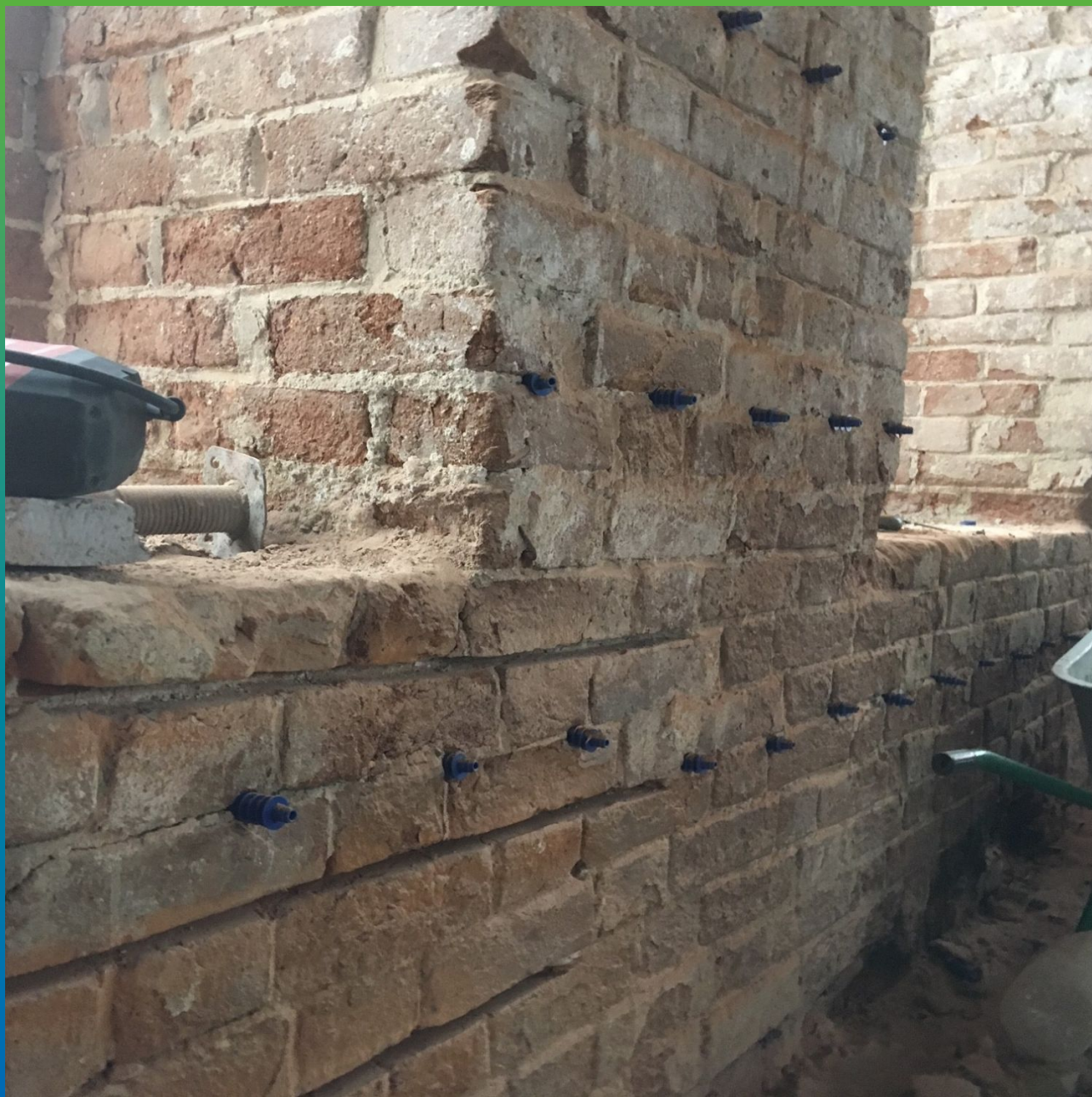
Вид установленных пакеров БМ 2830
