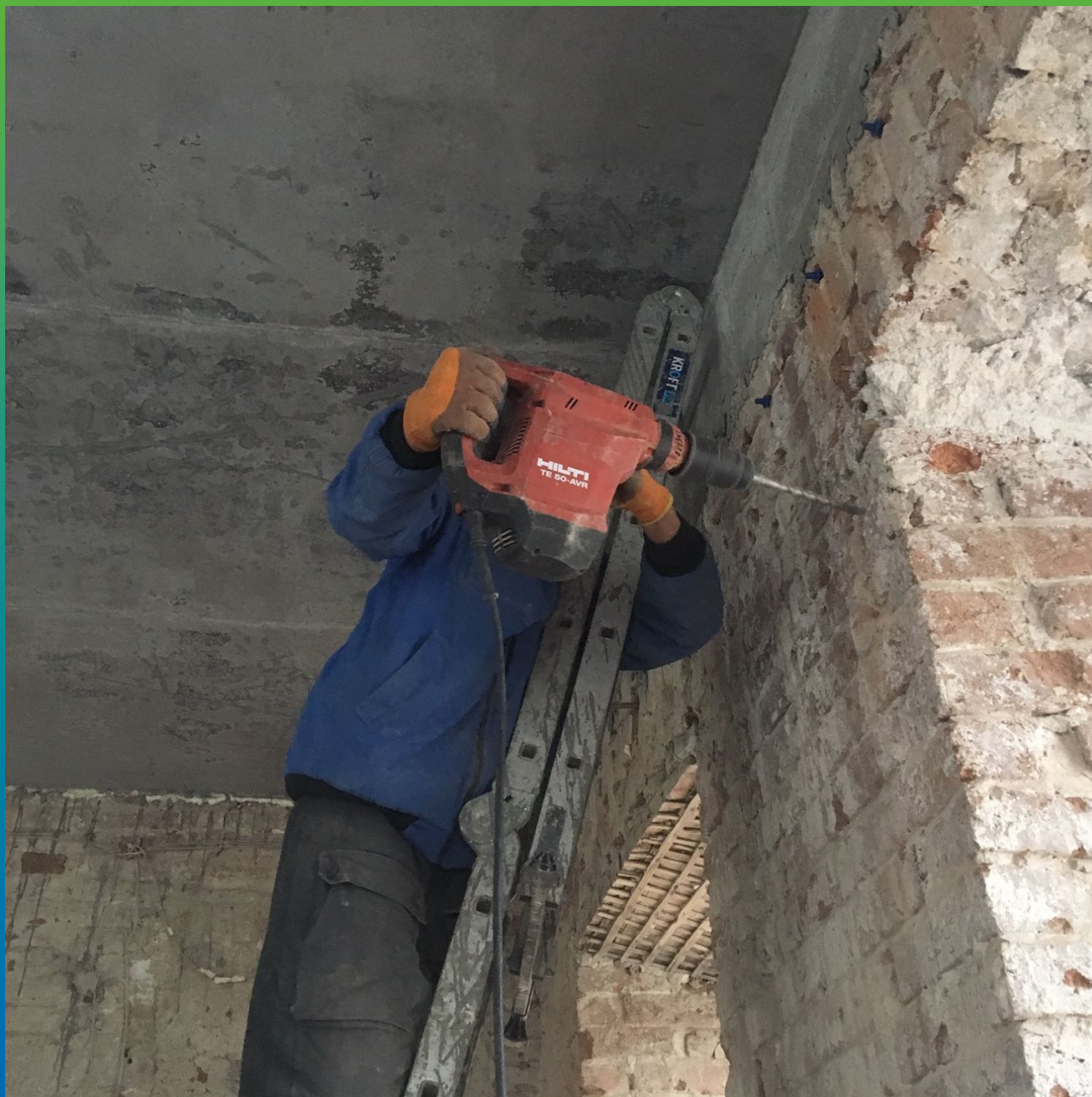
Устройство шпуров под инъекционные пакера
