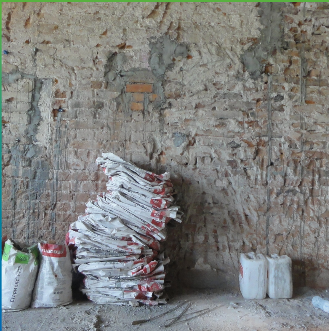
Финальный вид, окончание работ
