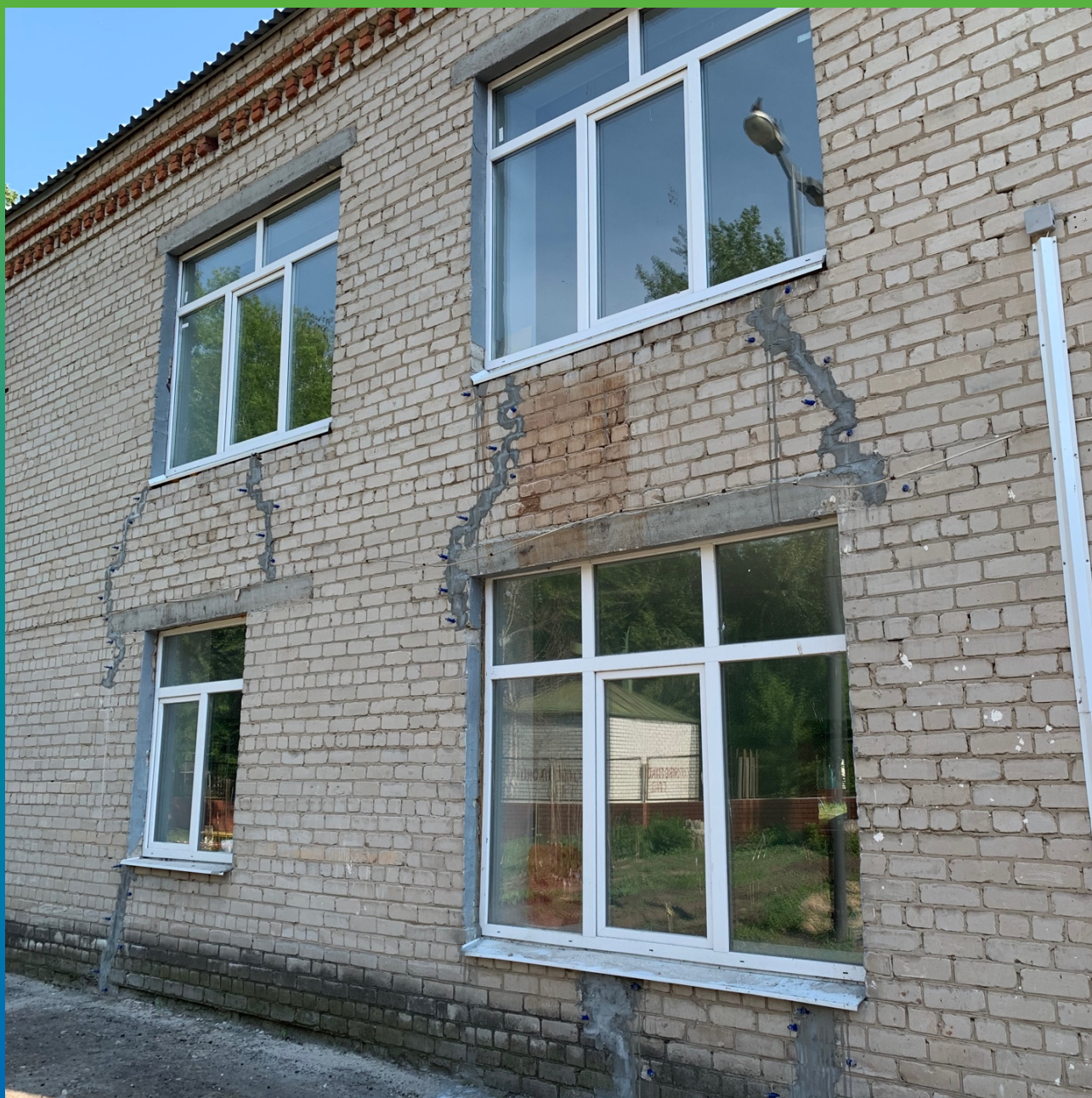
Трещины, проинъектированные составом Маноцем Грут
