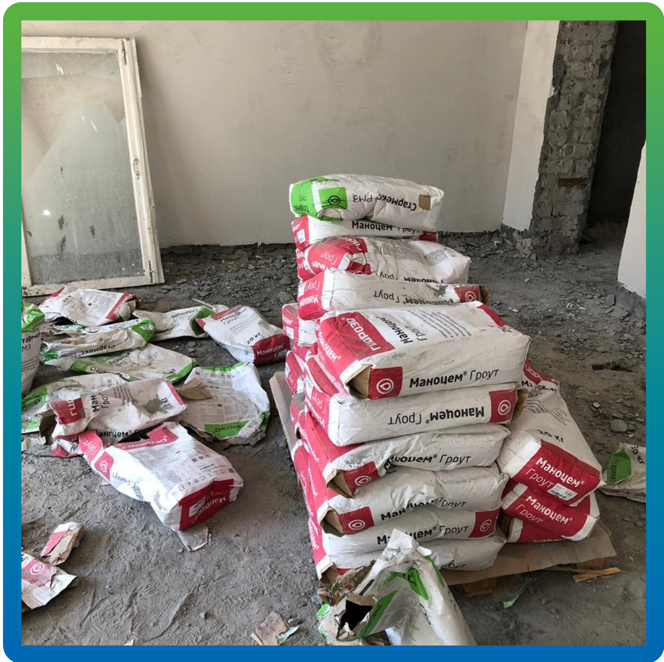
Инъекционный материал Маноцем Грут на объекте
