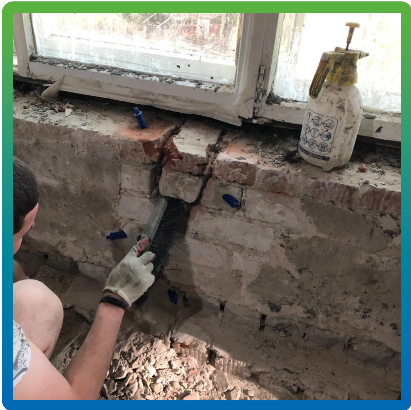
Зачеканка трещины составом Стармекс РМЗ
