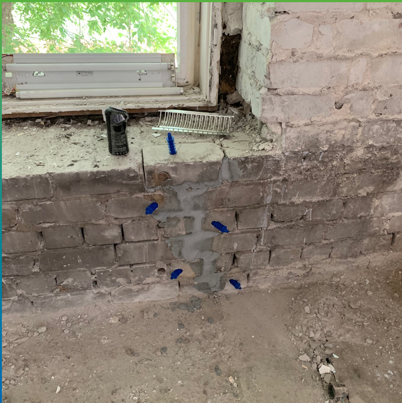
Подготовленная к инъектированию трещина
