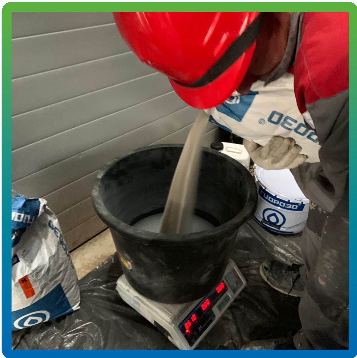
Добавление наполнителя ДенТоп Филлер в грунтовку ДенТоп ЭП 100
