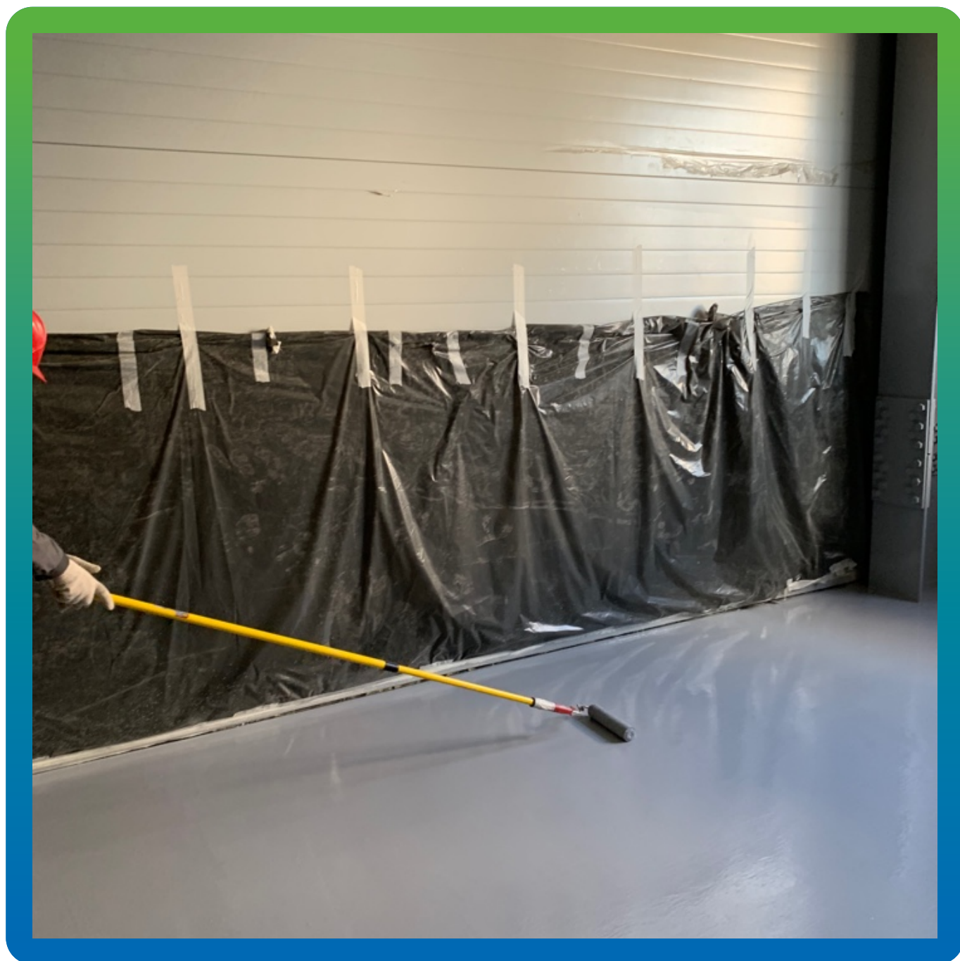
Нанесение третьего слоя ДенсТоп ЭП 201
