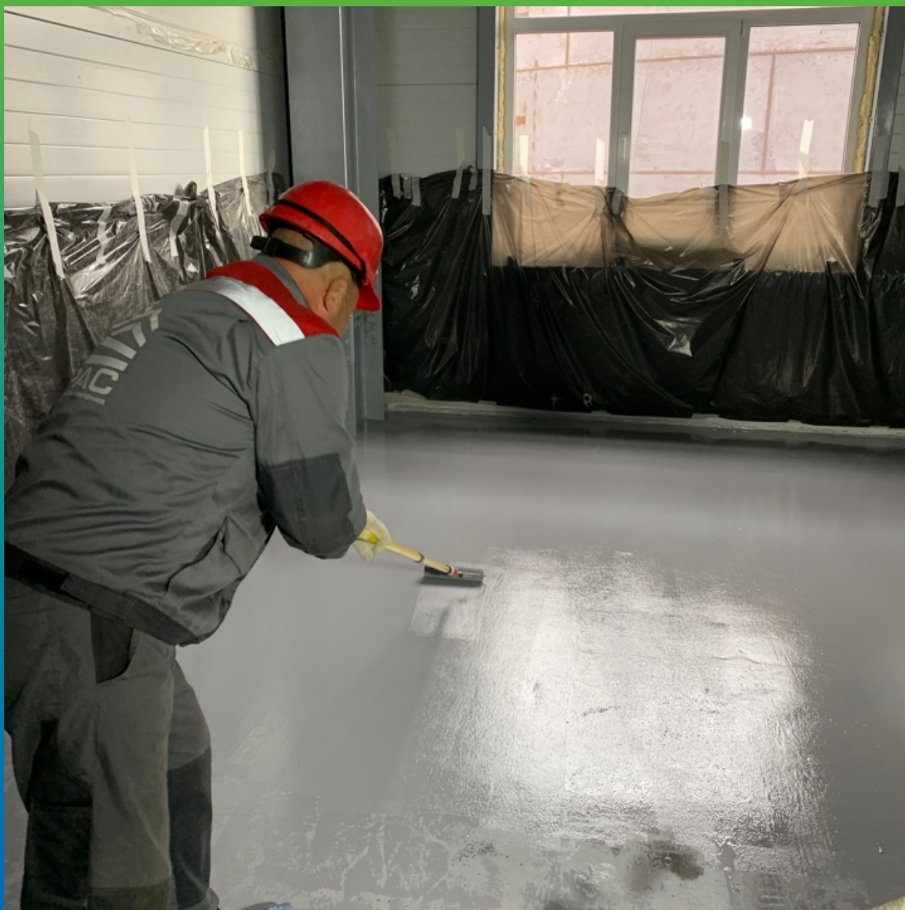
Нанесение второго слоя состава ДенТоп ЭП 201
