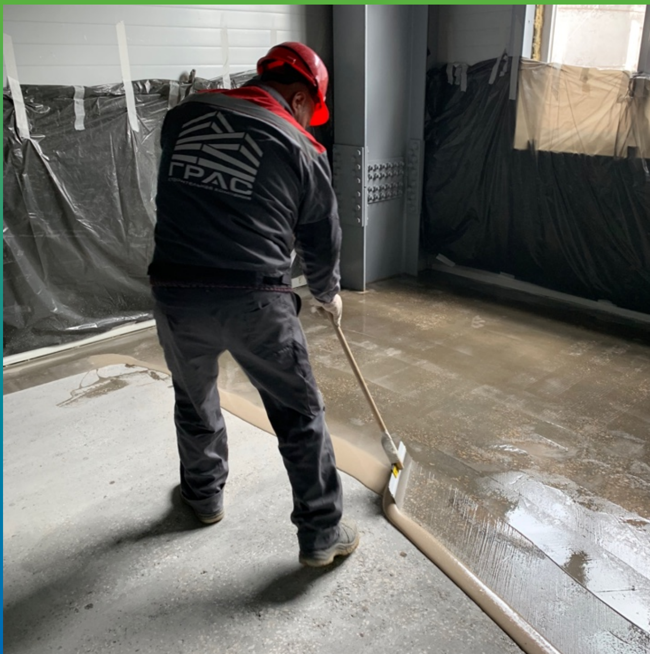
Нанесение грунтовочного состава ДенсТоп ЭП 100+ Денстоп Филлер
