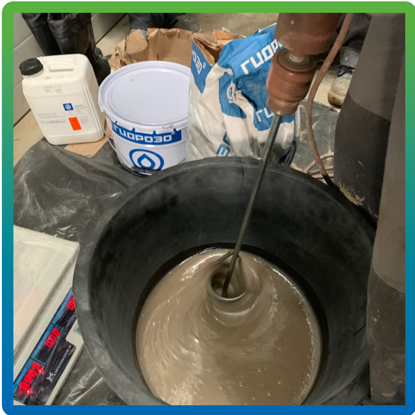
Приготовление грунтовки ДенсТоп ЭП 100 с Денстоп Филлер для последующего нанесения
