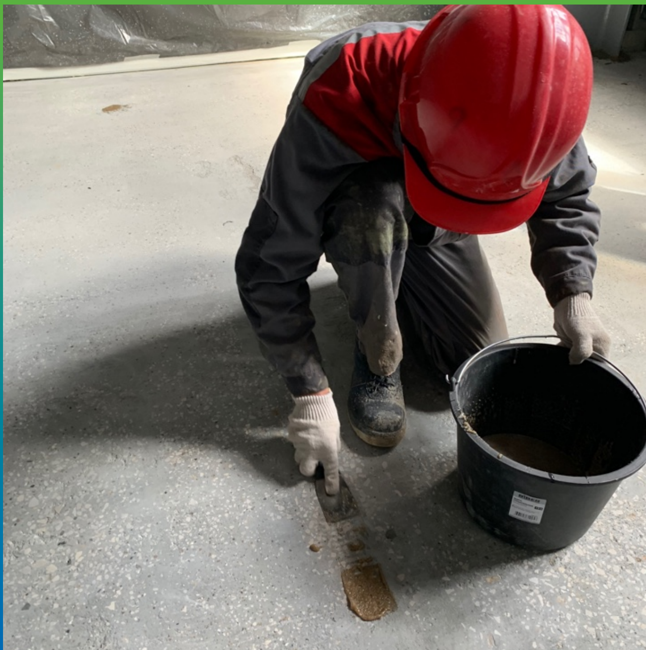
Заделка борозд и прочих дефектов пола
