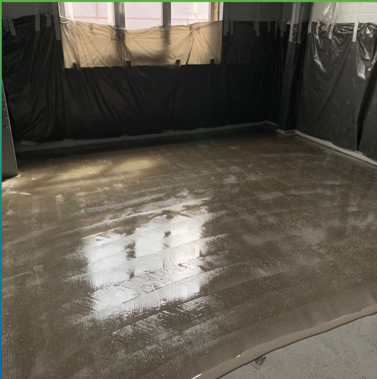
Нанесение грунтовочного состава ДенсТоп ЭП 100+ Денстоп Филлер
