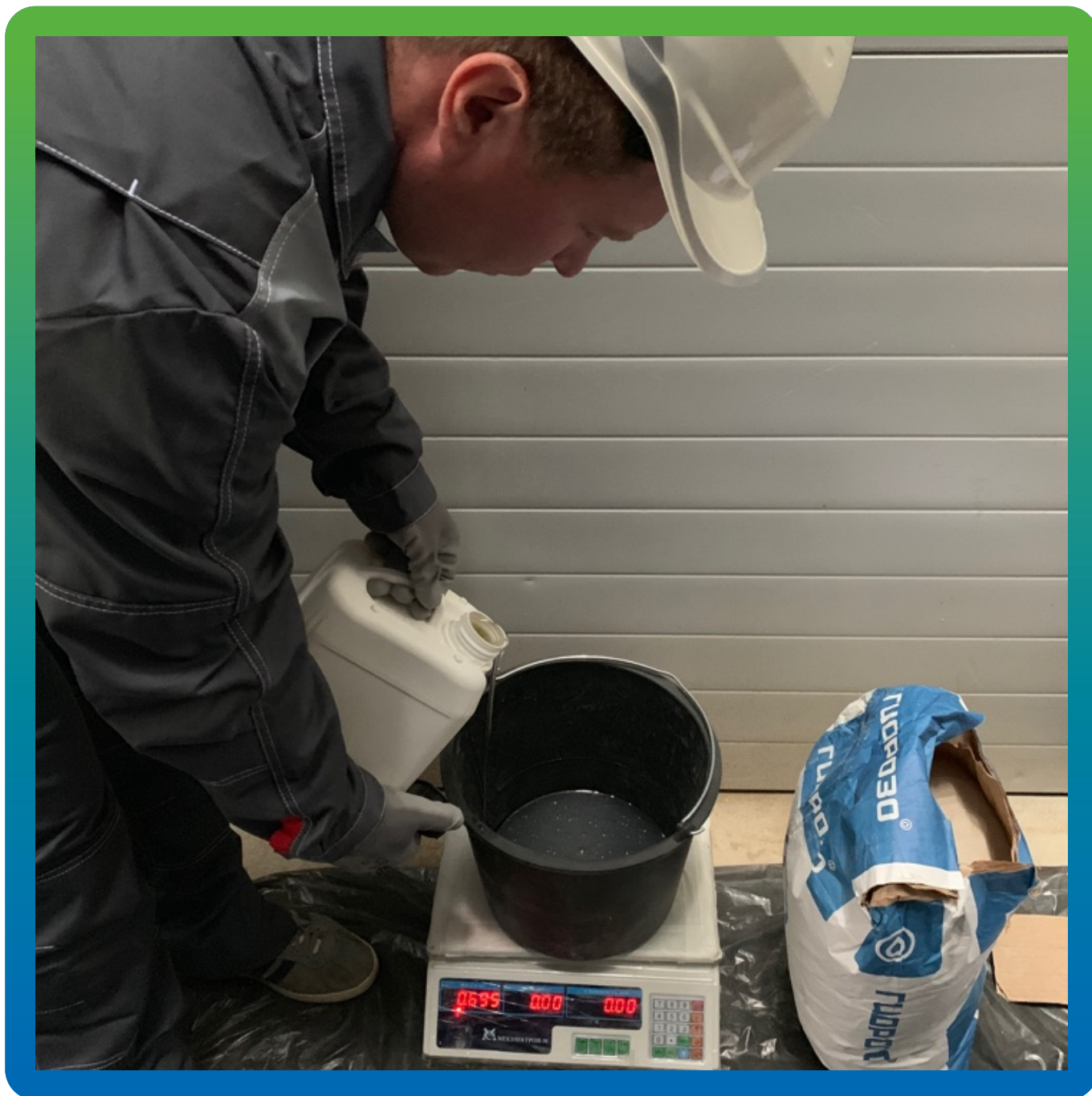
Приготовление ремонтной массы для заделки борозд и прочих дефектов пола
