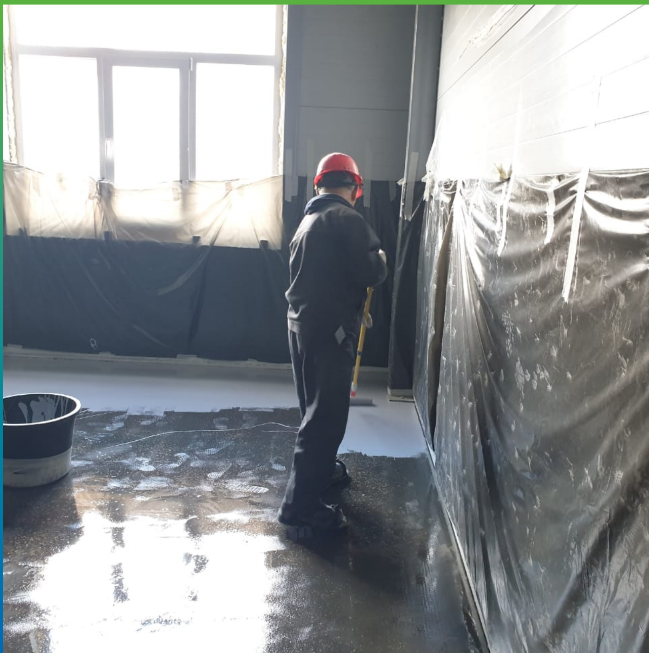
Нанесение первого слоя ДенТоп ЭП 201
