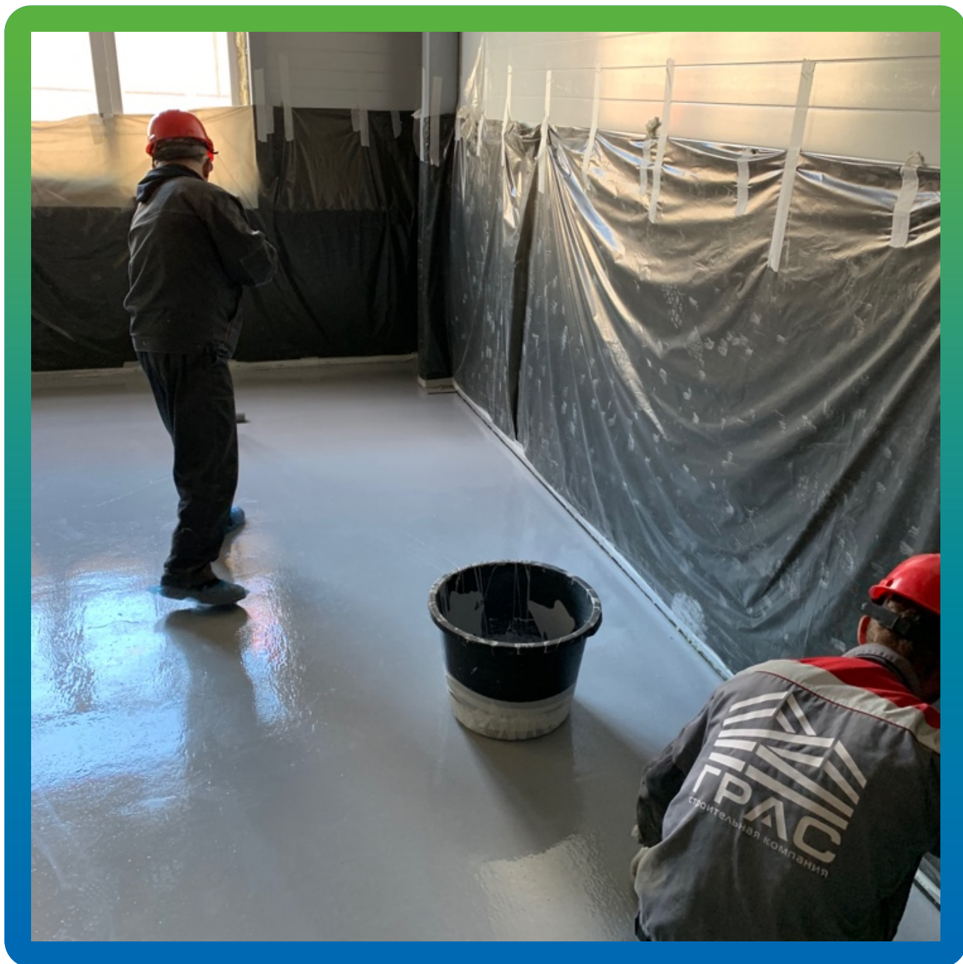
Нанесение третьего слоя ДенТоп ЭП 201
