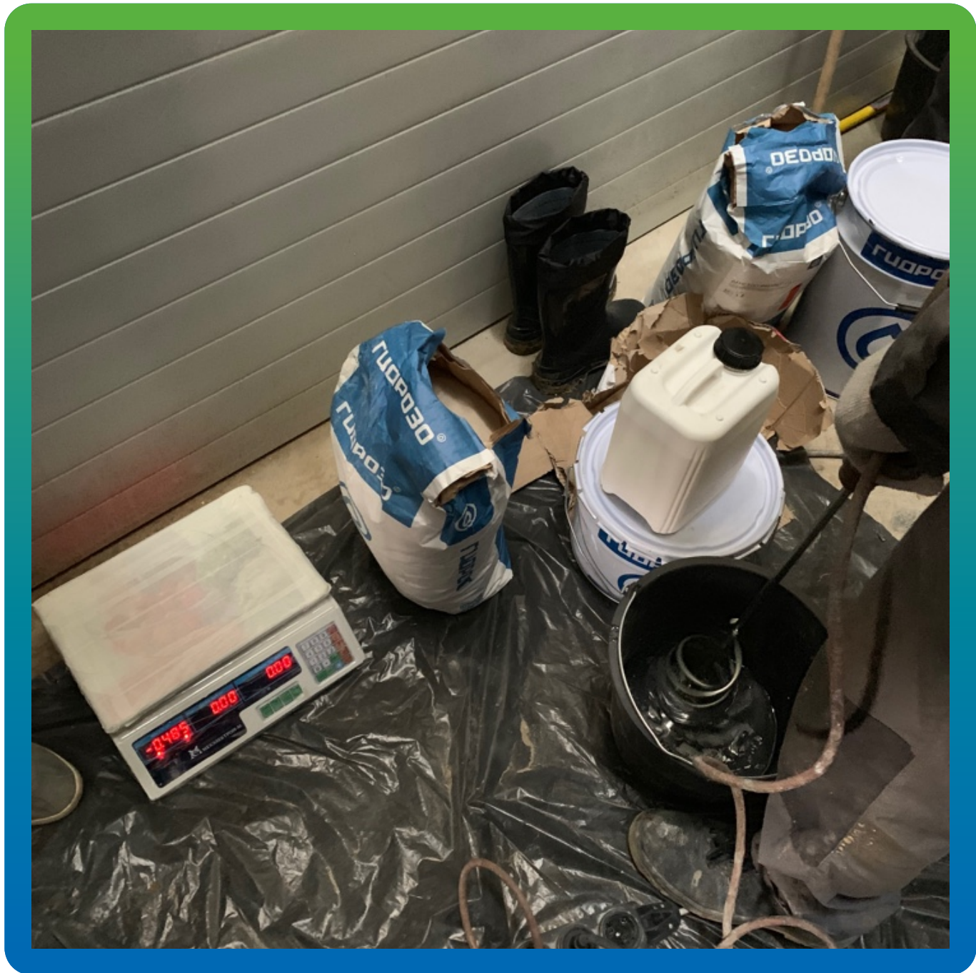
Замешивание ремонтного состава для устранения дефектов пола
