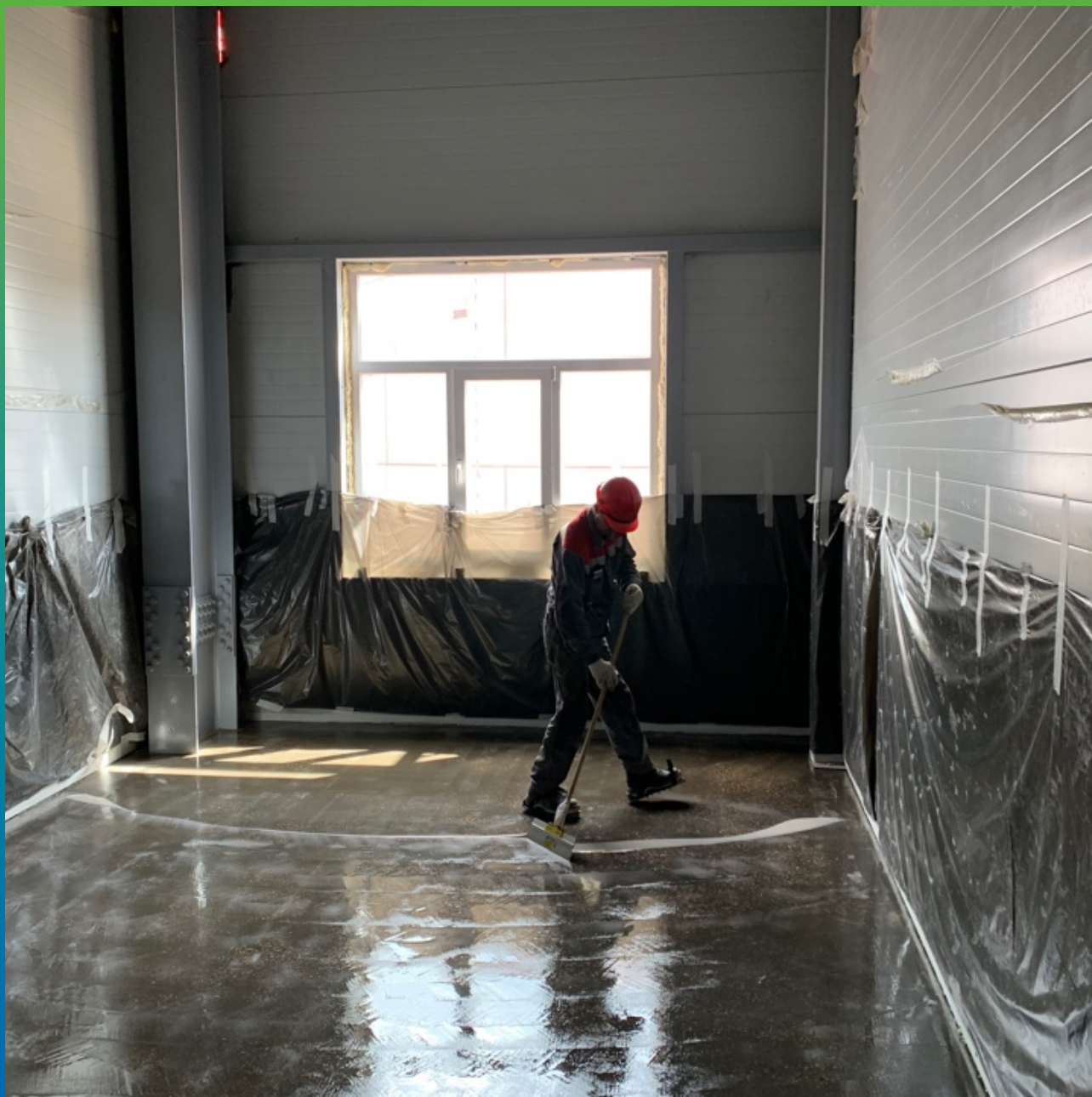
Нанесение грунтовочного состава ДенТоп ЭП 100+ ДенТоп Филлер
