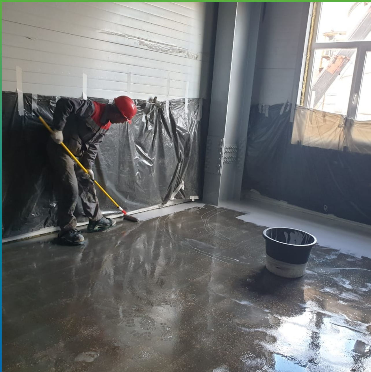
Нанесение первого слоя ДенТоп ЭП 201
