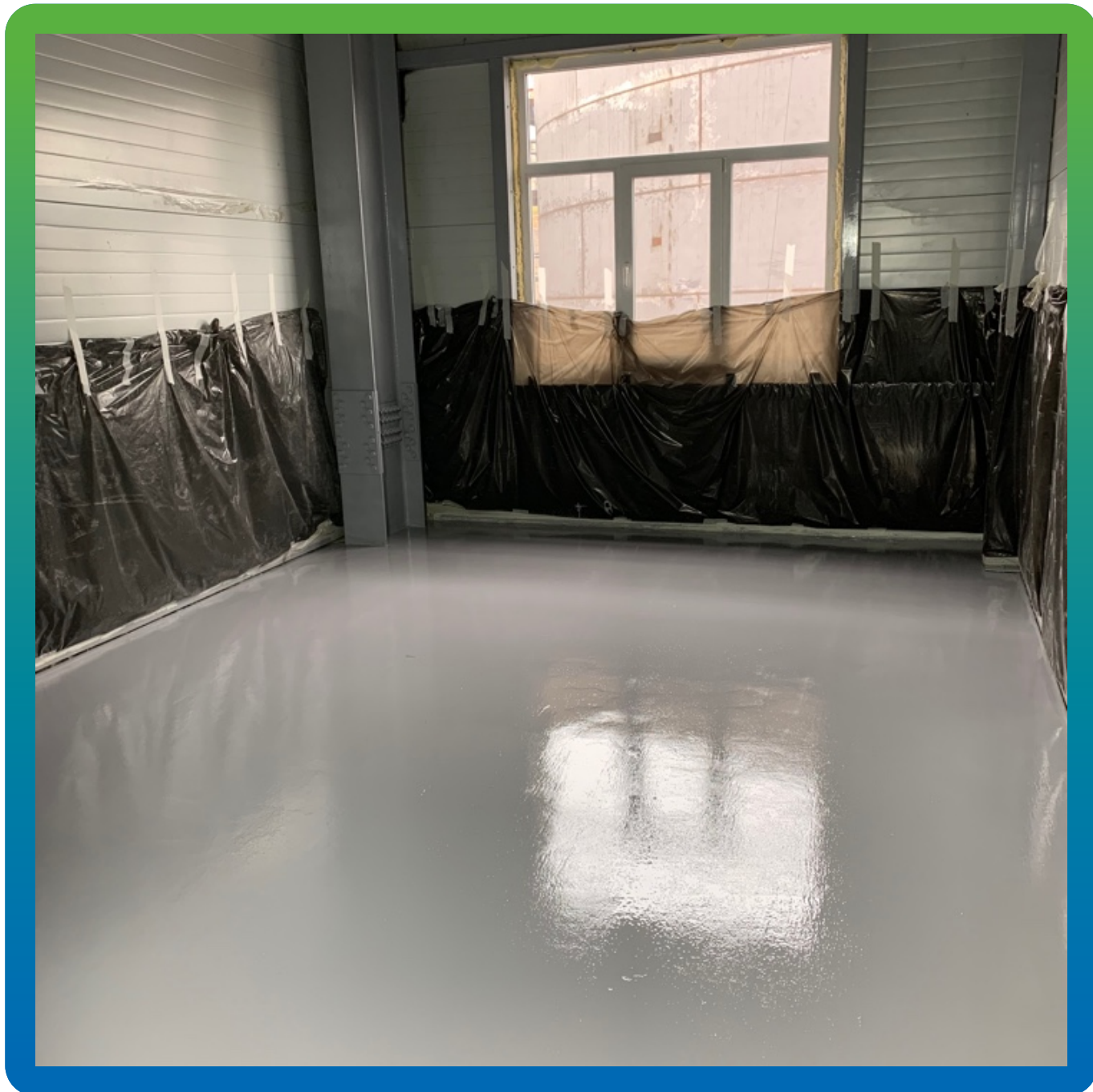
Вид поверхности после нанесения второго слоя ДенТоп ЭП 201
