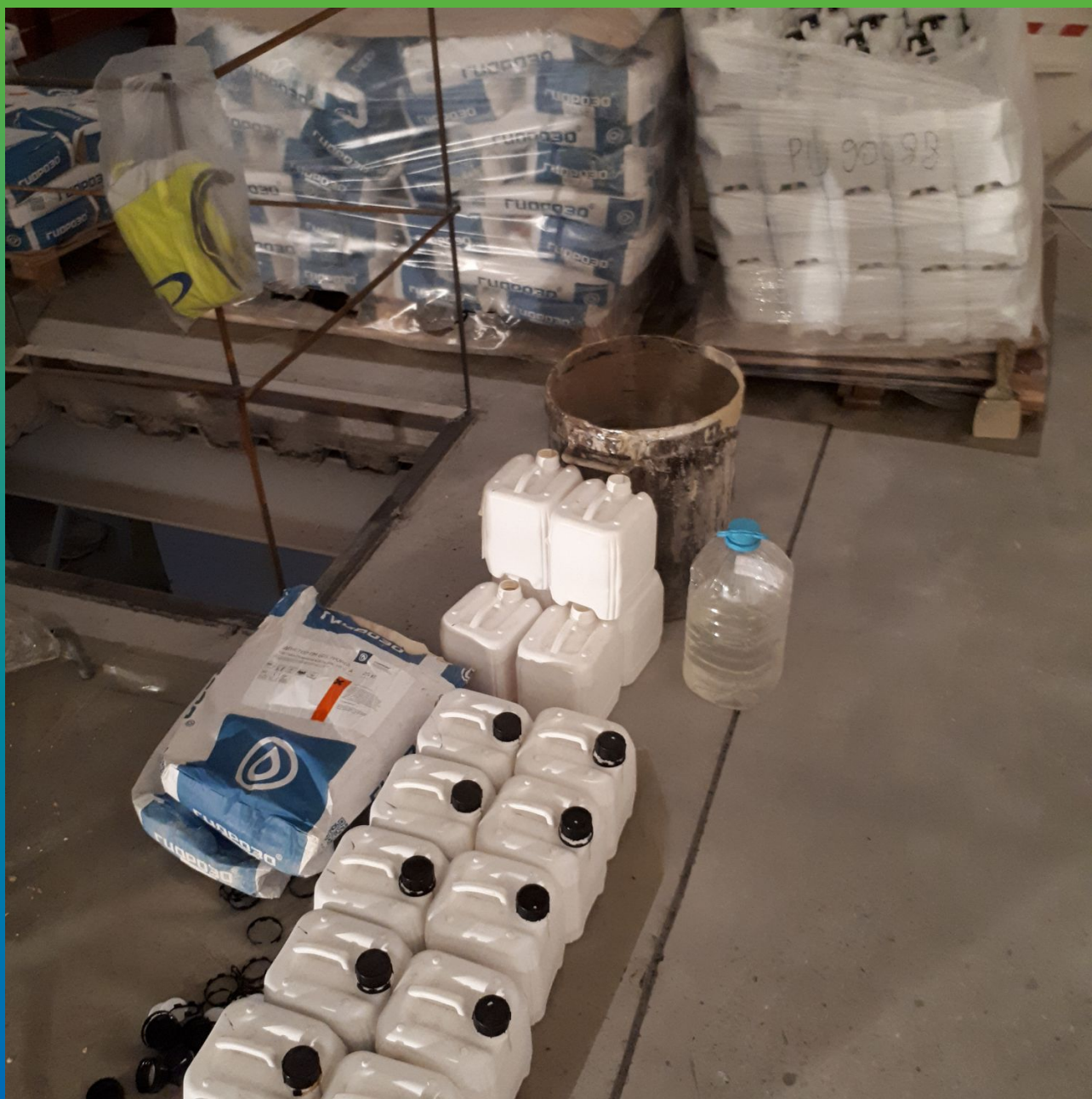
Материалы Гидрозо на объекте
