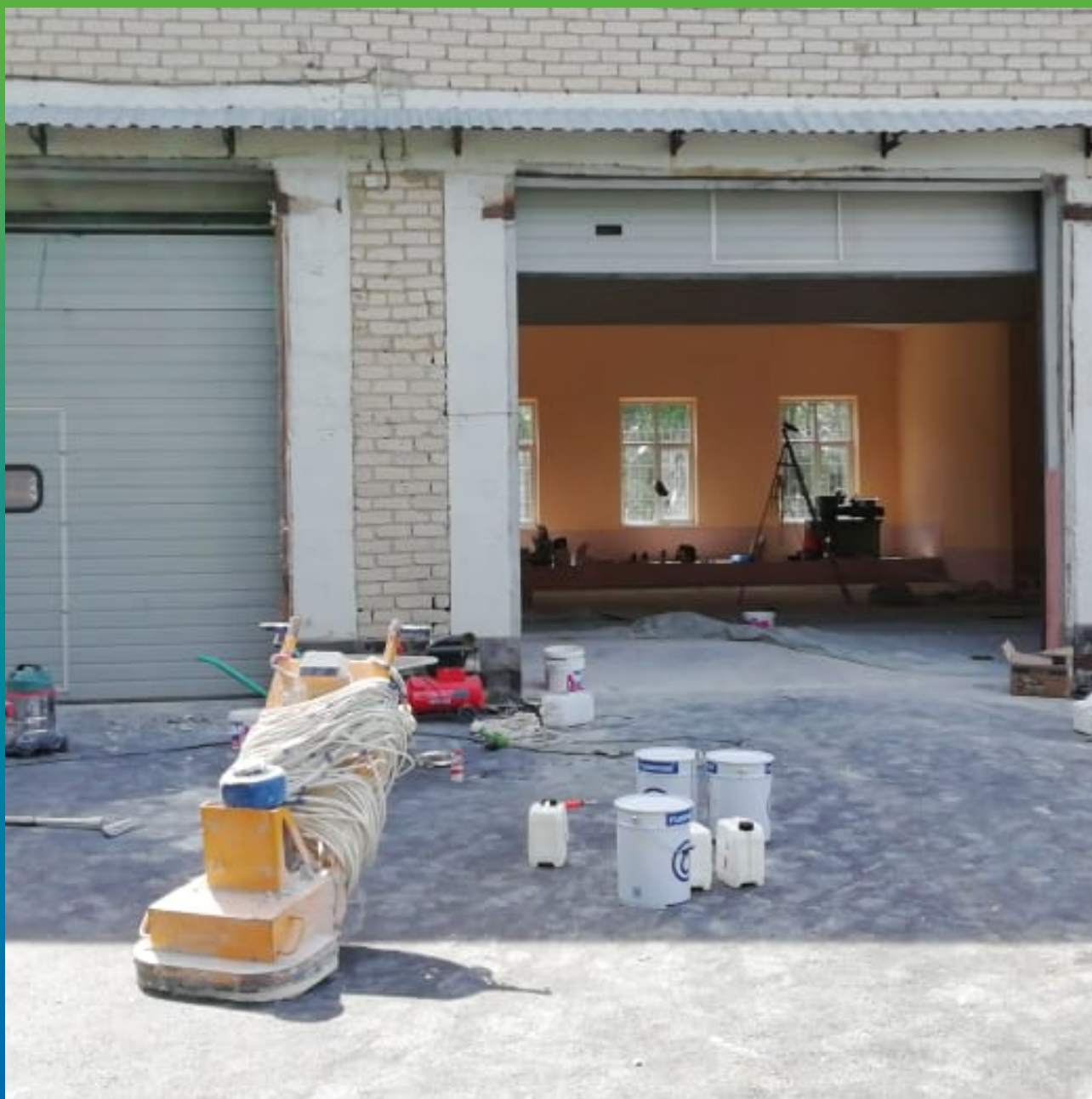
Материалы Гидрозо на объекте
