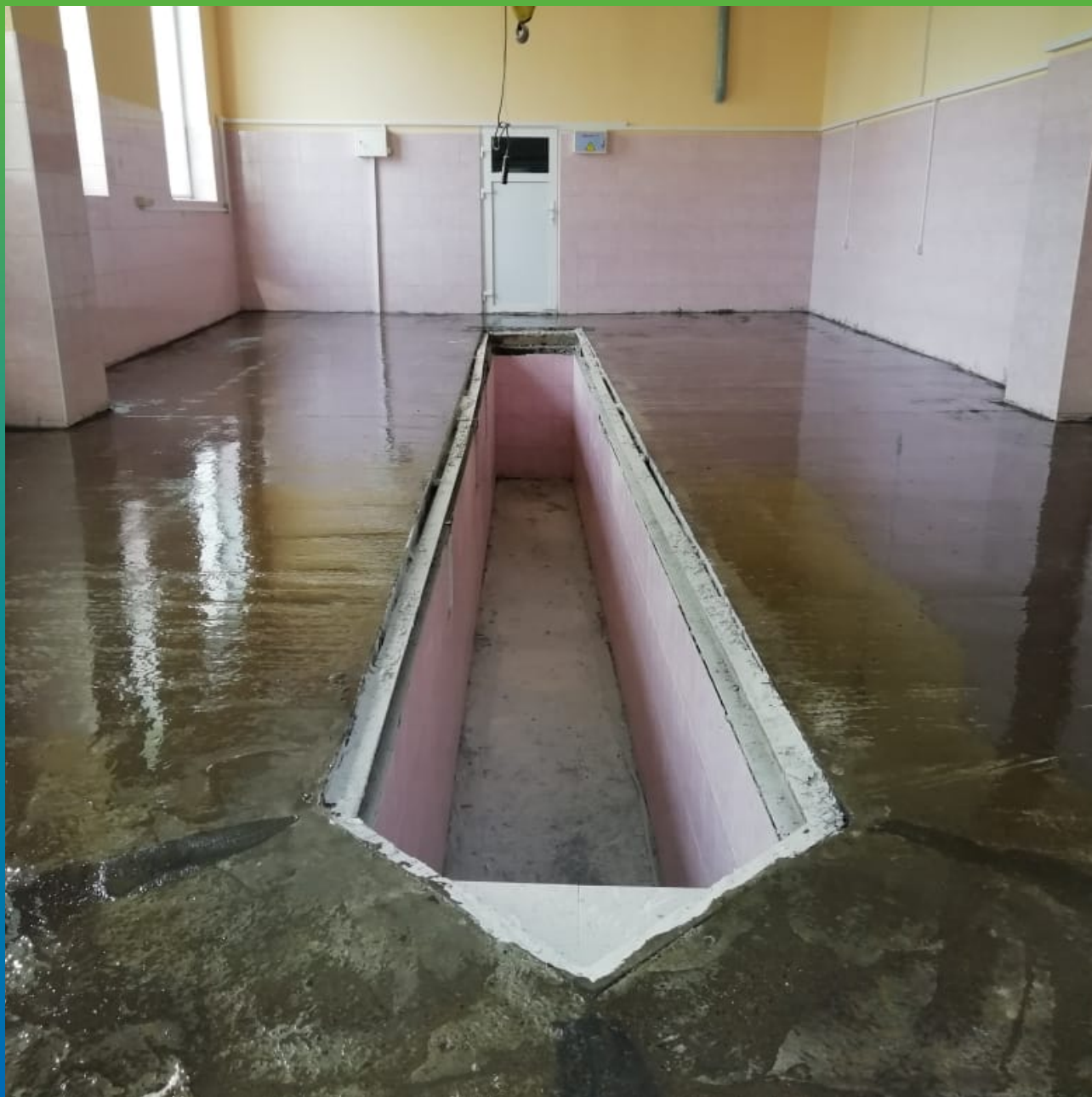
Поверхность, загрунтованная ДенсТоп ЭП 100
