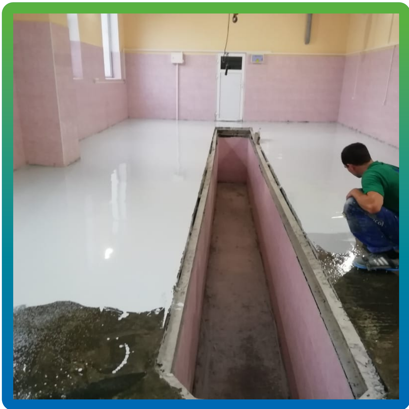
Нанесение базового эпоксидного покрытия ДенсТоп ЭП 501
