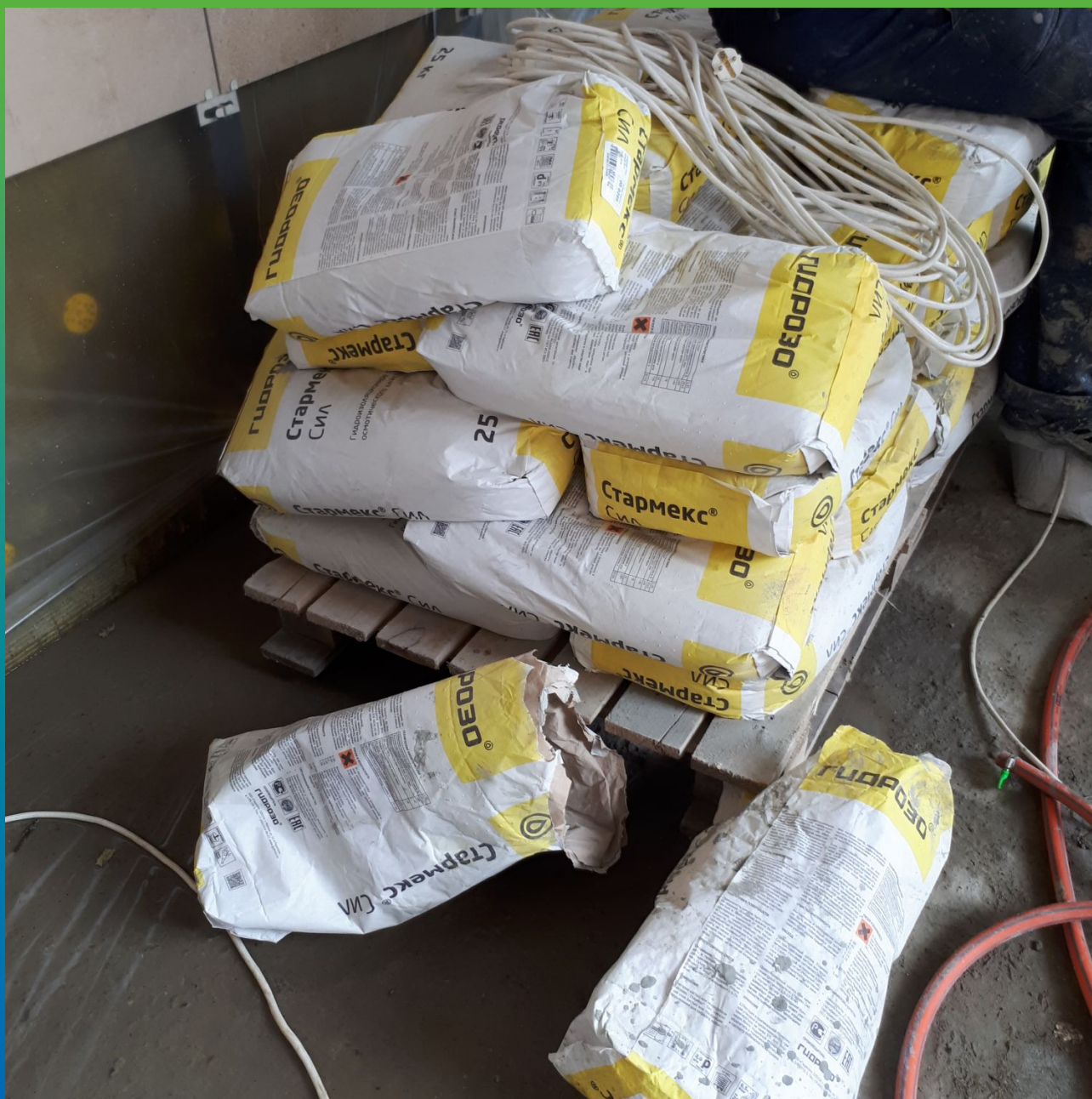
Материалы Гидрозо на объекте
