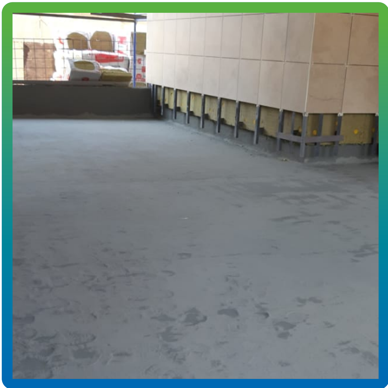
Выполненная гидроизоляция по плите с заходом на стену
