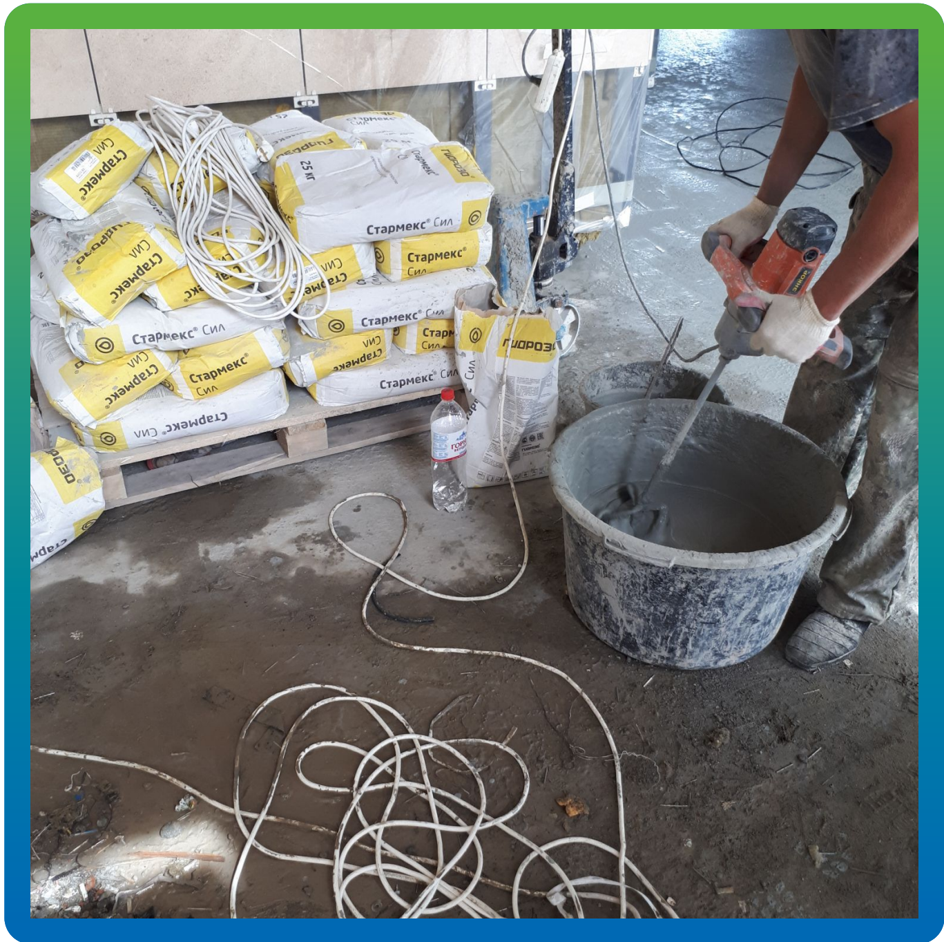
Приготовление гидроизоляции осмотического действия Стармекс Сил
