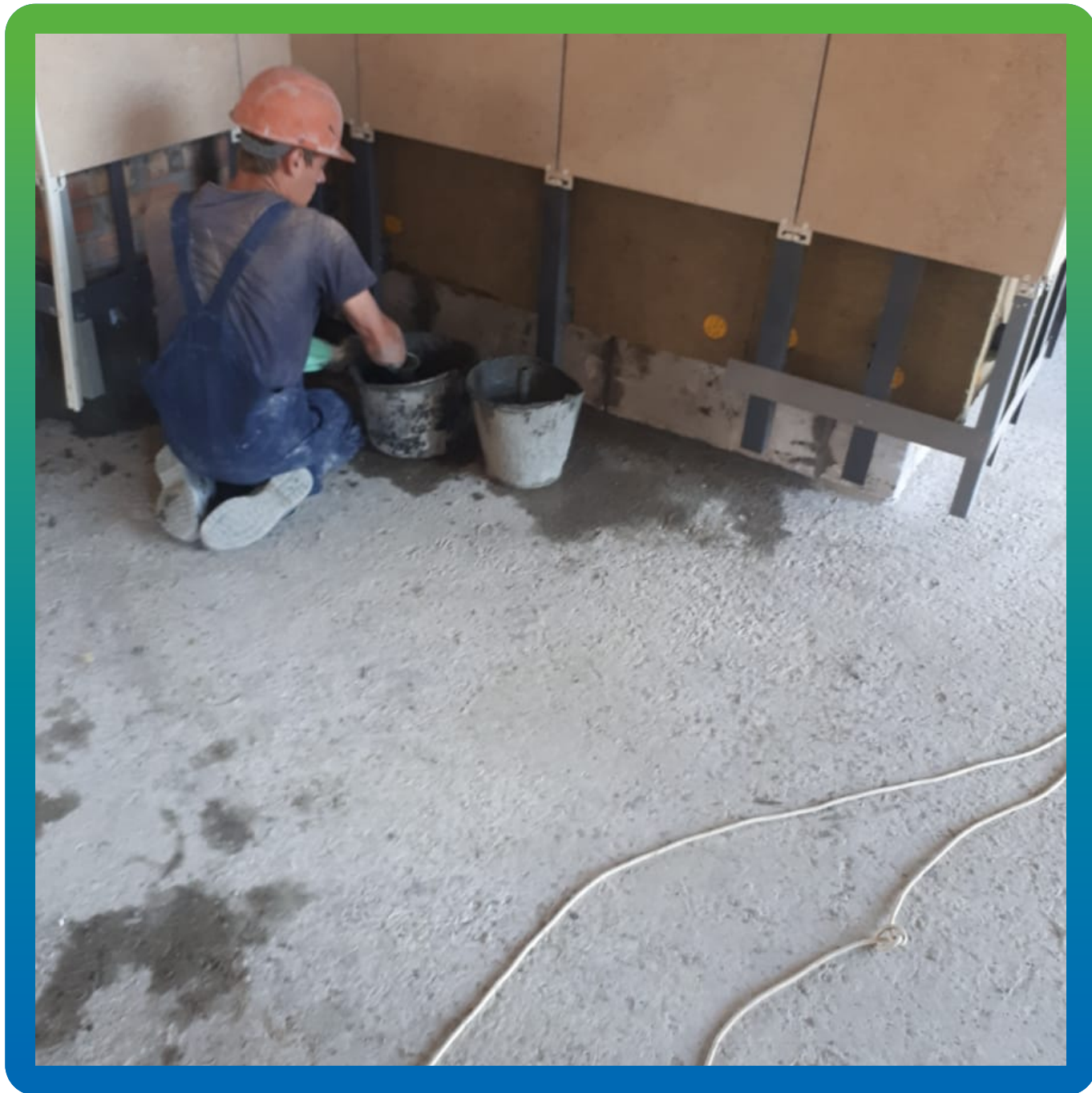
Устройство галтели на примыкании плита-стена ремсоставом Стармекс РМЗ
