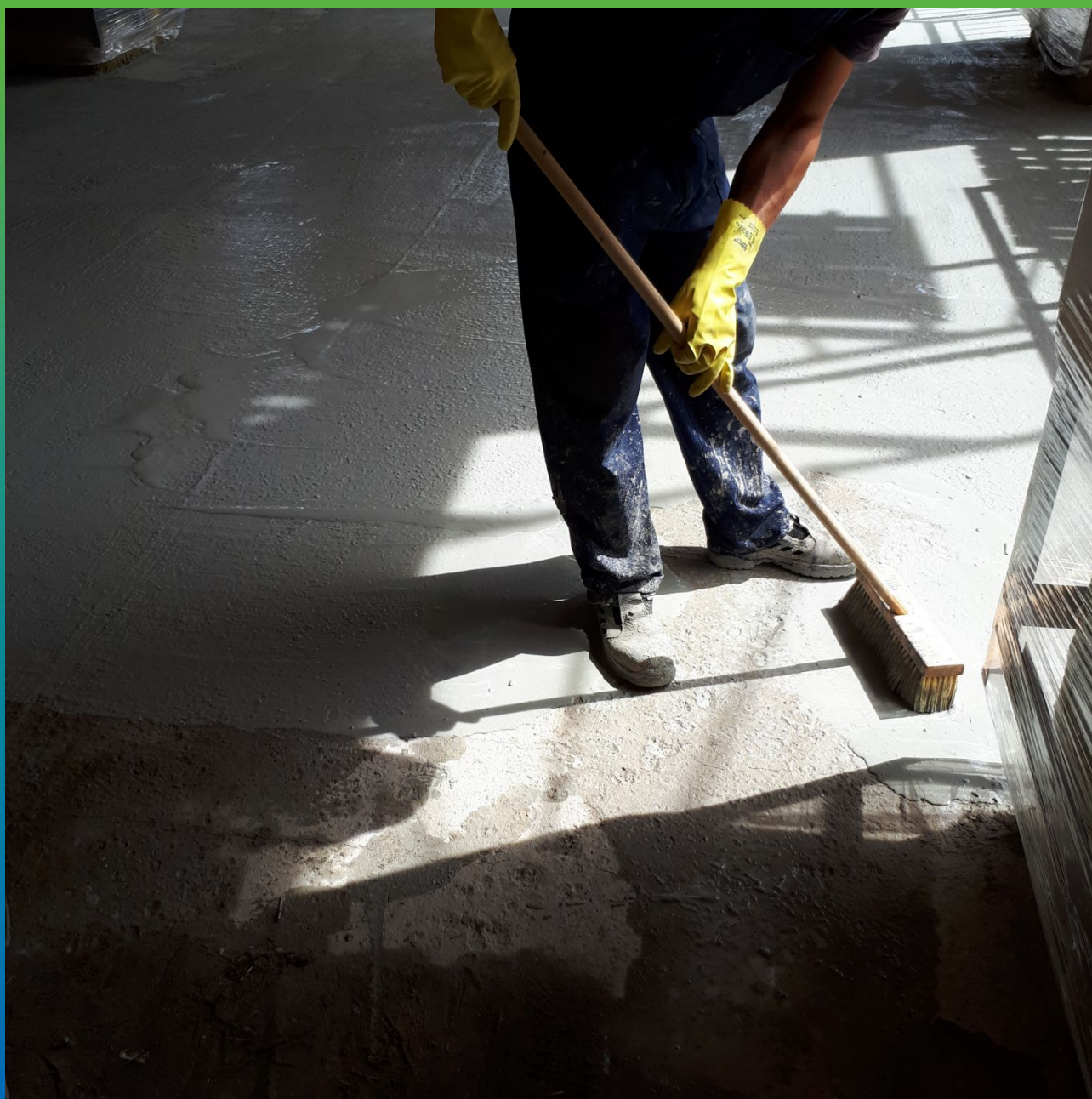
Нанесение Стармекс Сил с помощью щетки Стармекс Брум по плите
