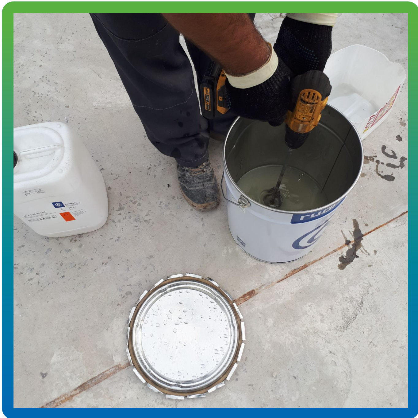
Перемешивание эпоксидной грунтовки ДенсТоп ЭП 100
