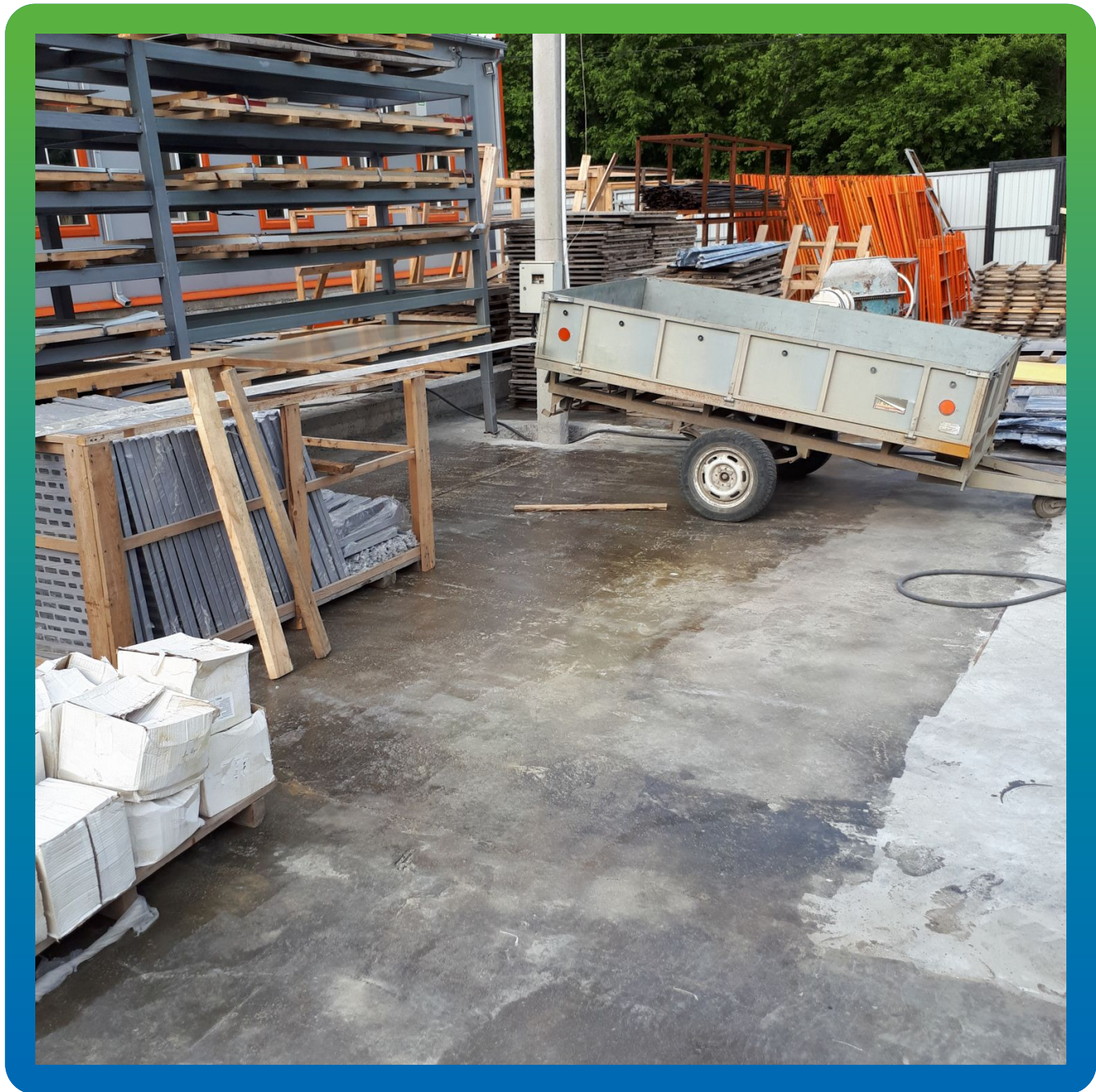
Итоговый вид покрытия
