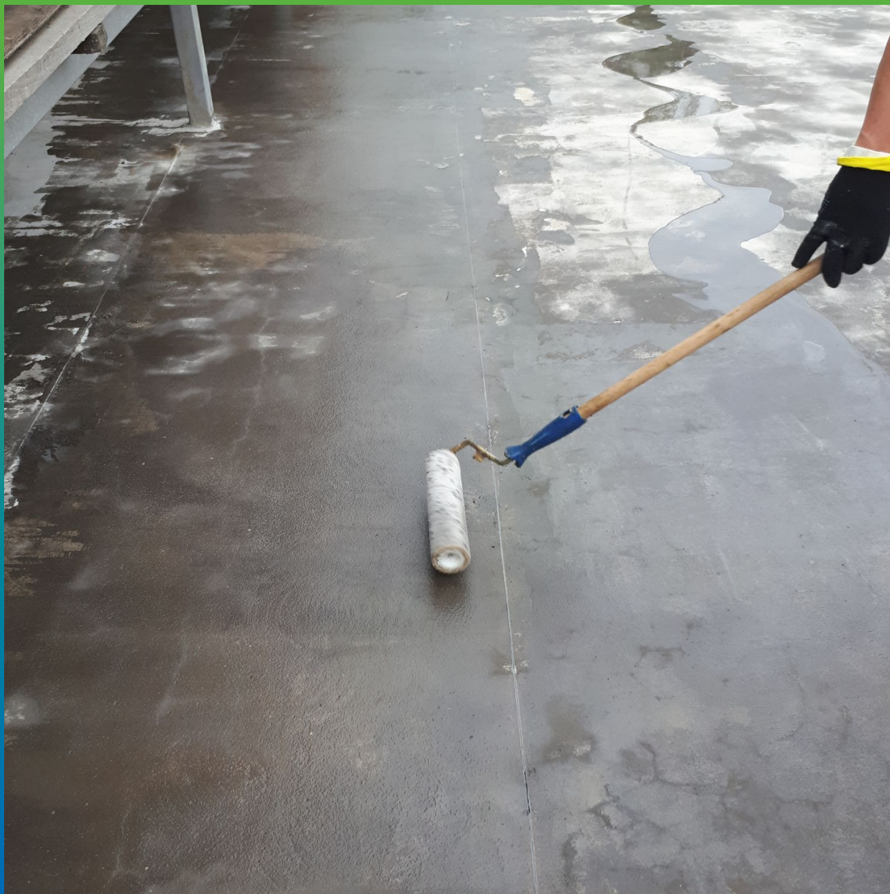
Накатка слоёв грунтовки ДенсТоп ЭП 100
