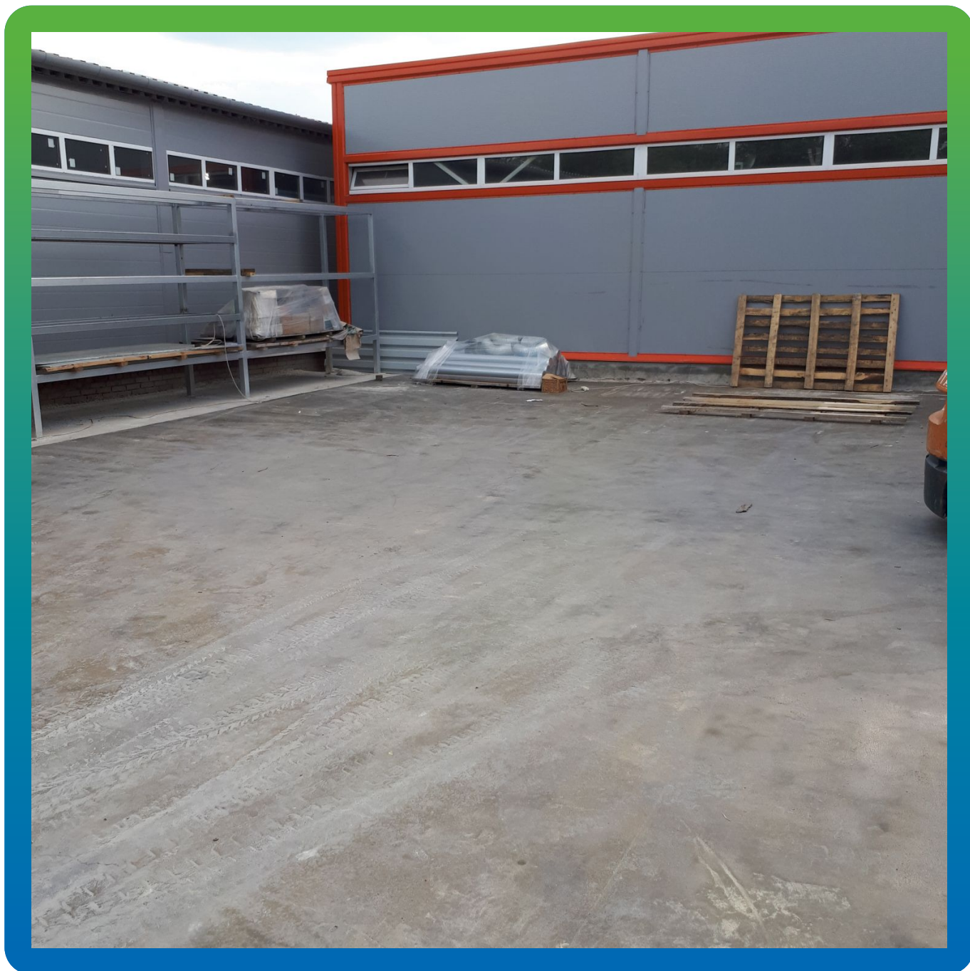
Финишный вид обработанного бетона
