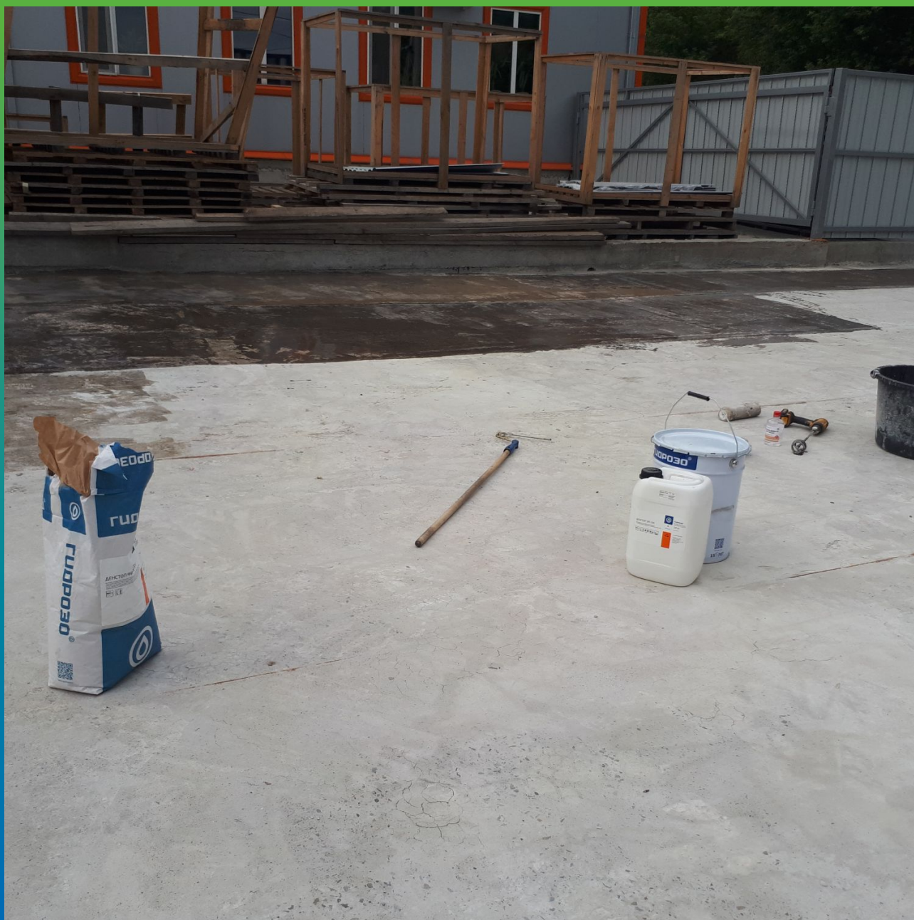
Материалы Гидрозо на объекте
