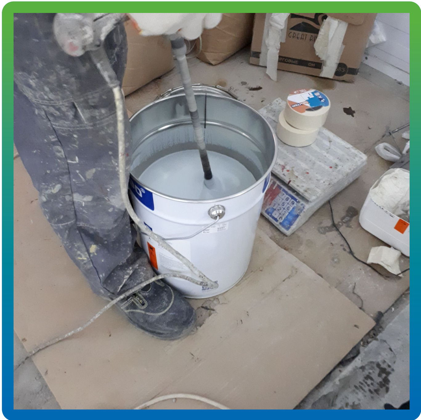
Перемешивание базового эпоксидного состава ДенТоп ЭП 501
