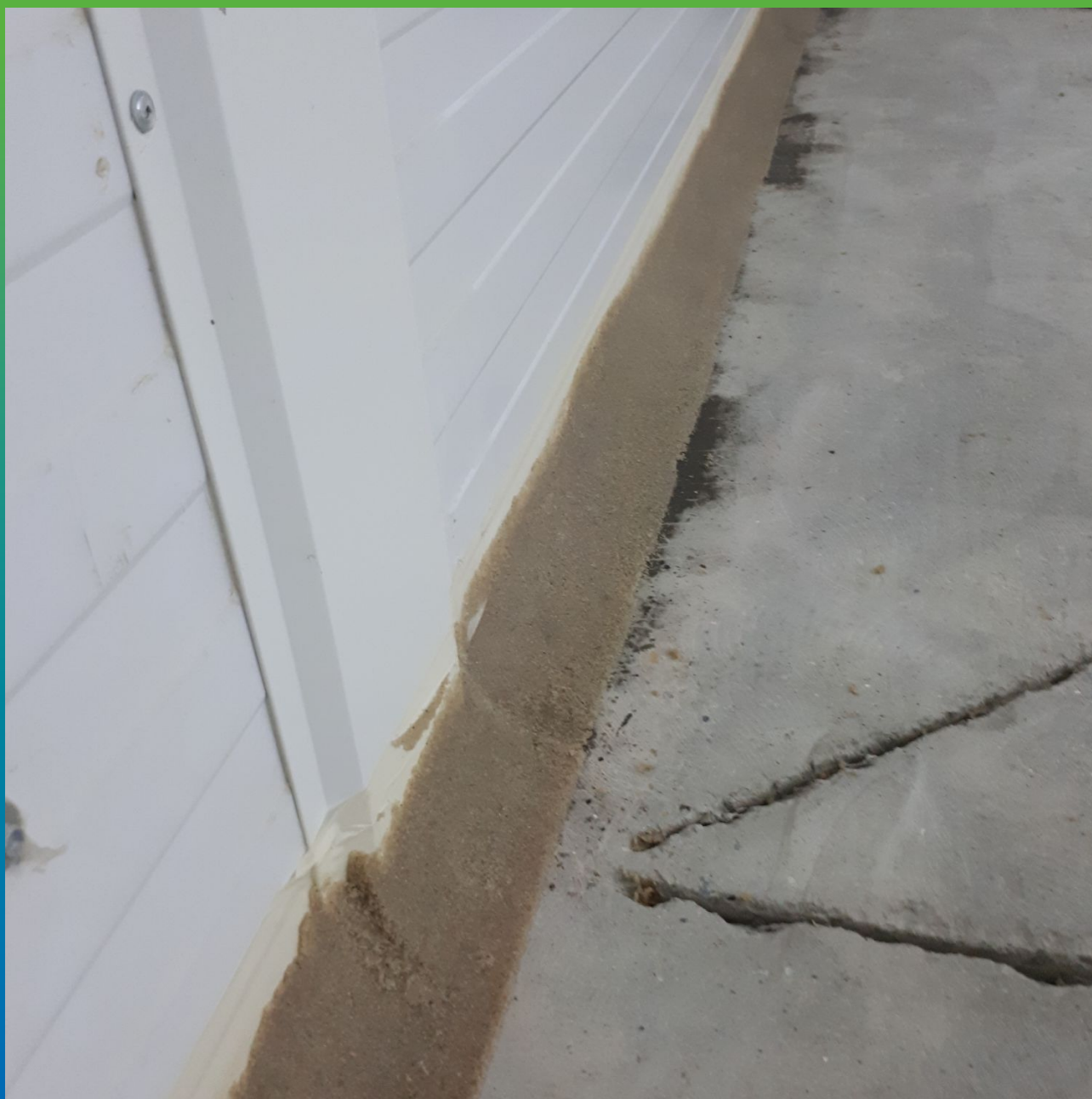
Выполненный плинтус до покраски
