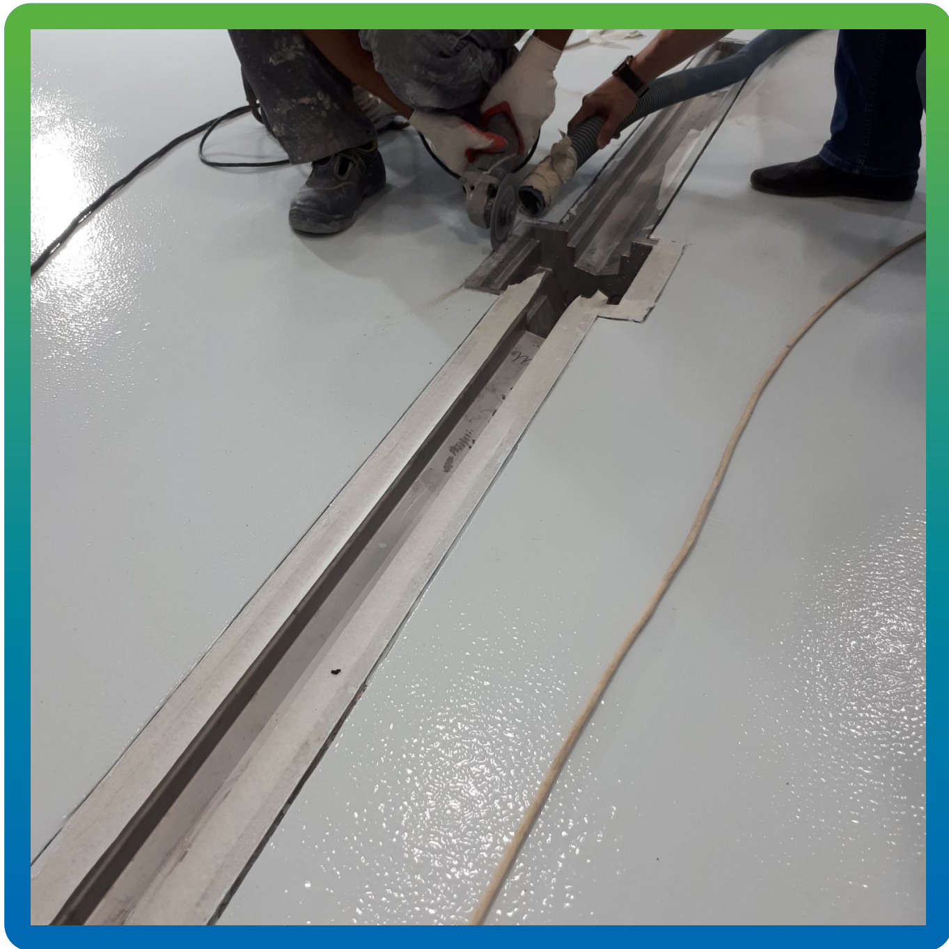
Нарезка швов по периметру лотков
