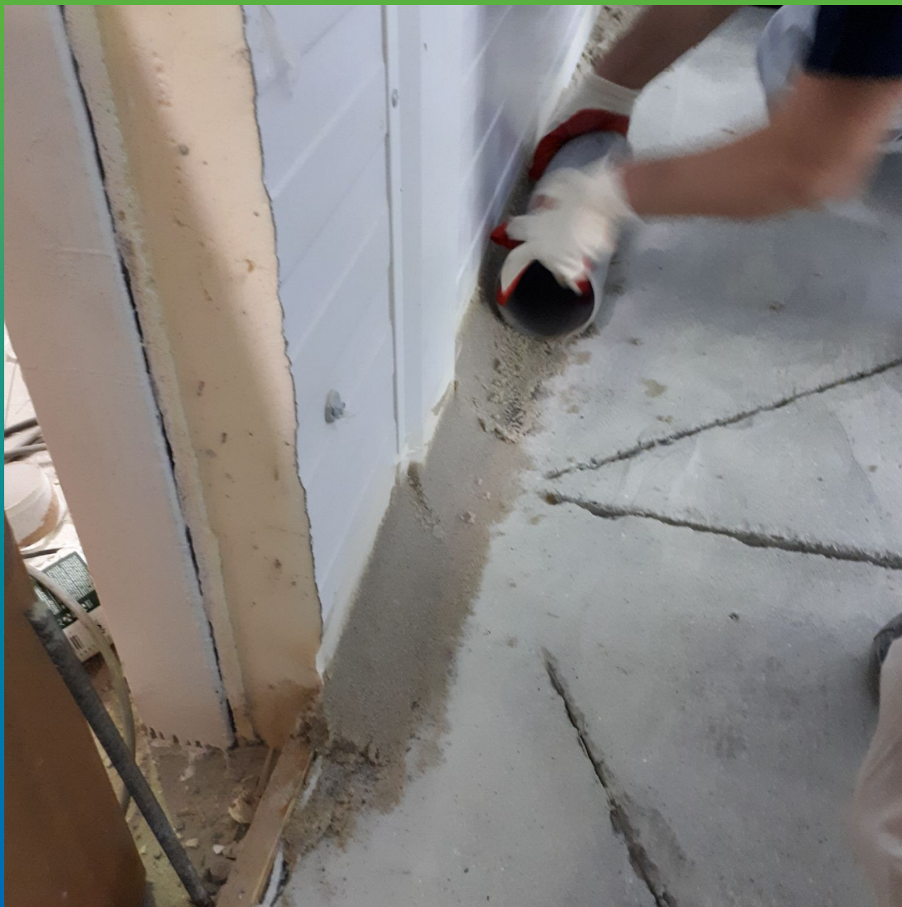
Процесс формирования плинтуса из эпоксидно-песчаной массы
