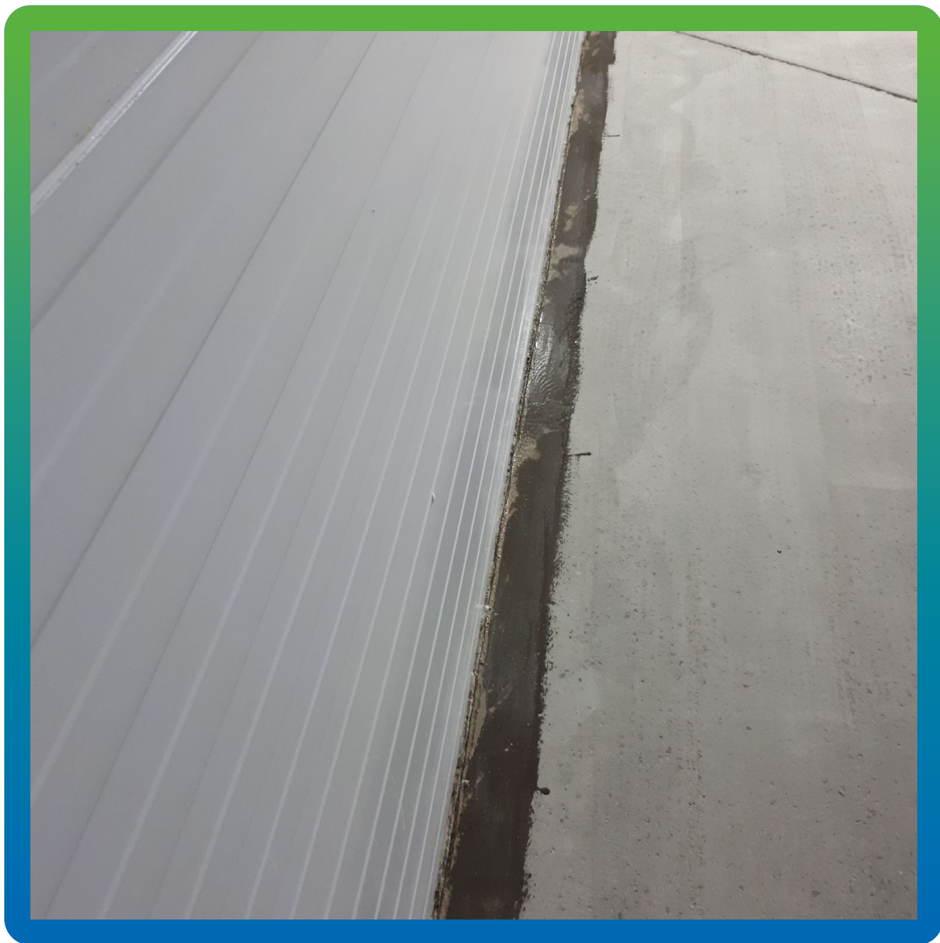
Грунтование пола перед устройством эпоксидного плитуса
