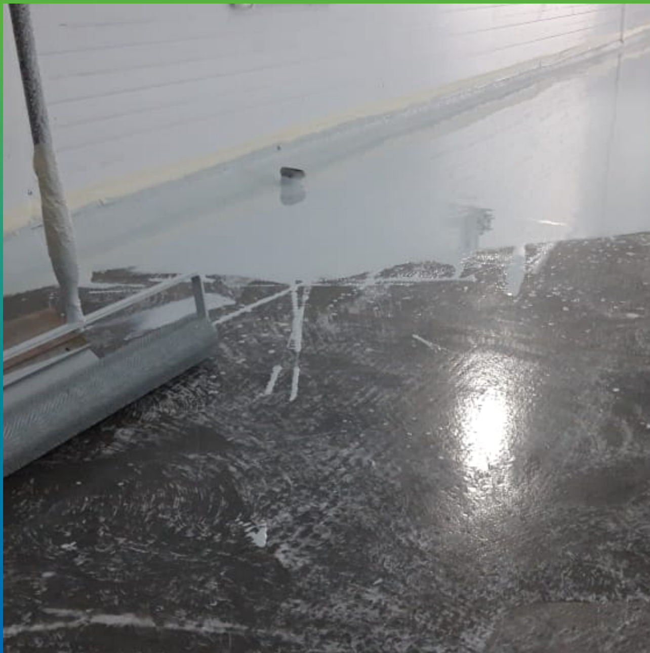
В процессе покрытия базового слоя ДенТоп ЭП 501
