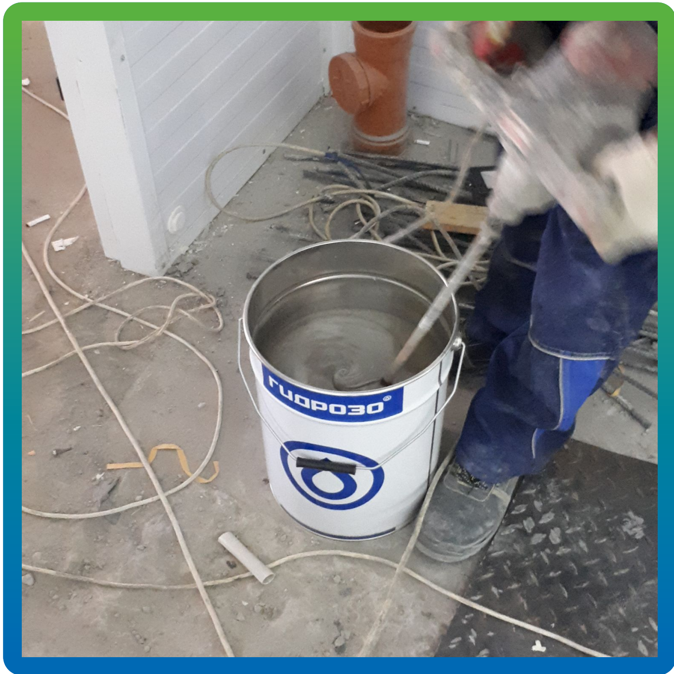
Подготовка двухкомпонентной эпоксидной грунтовки ДенТоп ЭП 104
