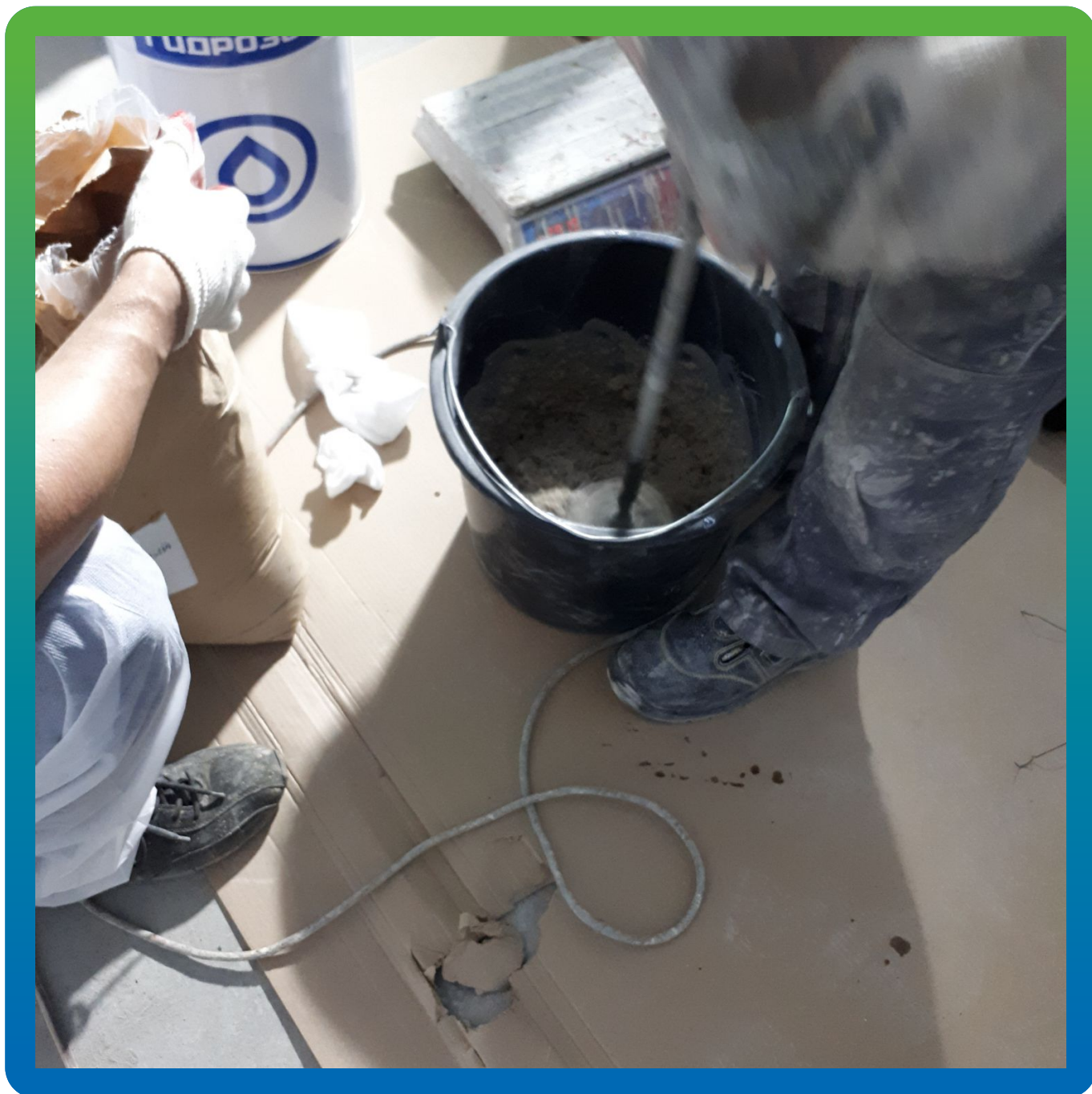
Добавление кварцевого песка для тиксотропного состава под плинтуса
