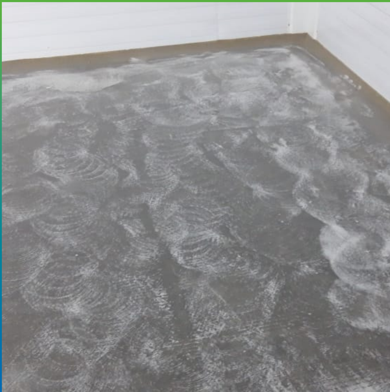
Загрунтованная поверхность пола эпоксидной грунтовкой ДенсТоп ЭП 104
