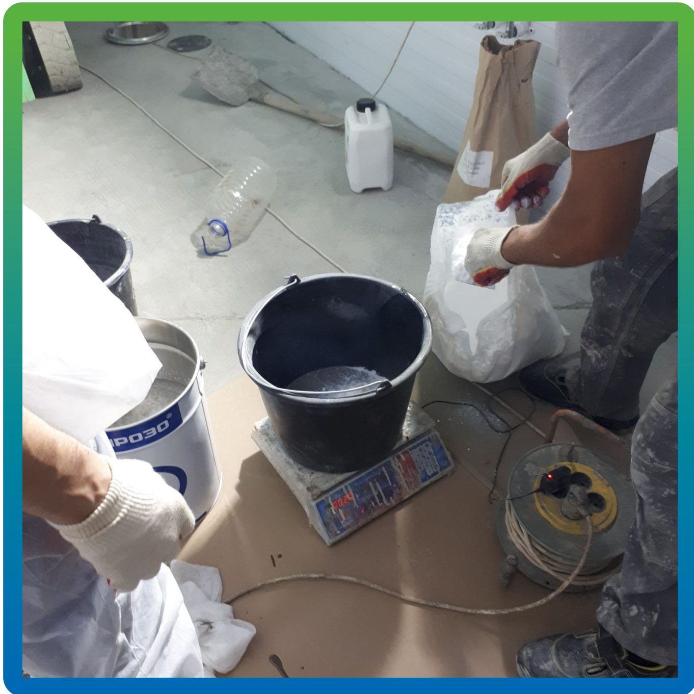
Добавление загустителя в грунтовку для формирования плитусов
