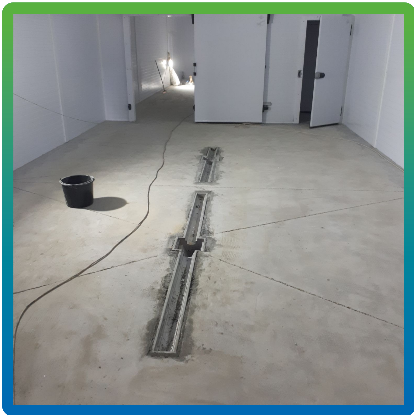
Поверхность до нанесения полимерных составов
