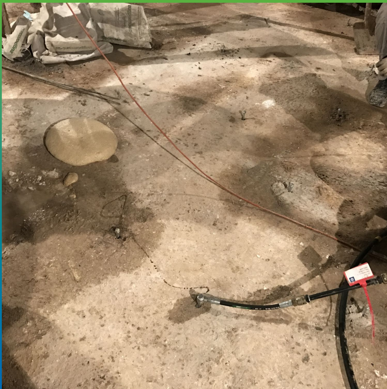
Процесс вспенивания смолы в свободном пространстве при контакте с водой
