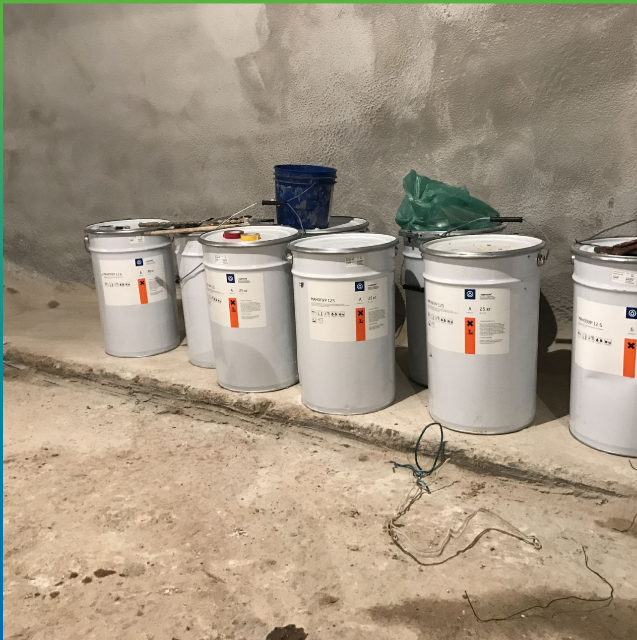
Материал на объекте в ожидании работы
