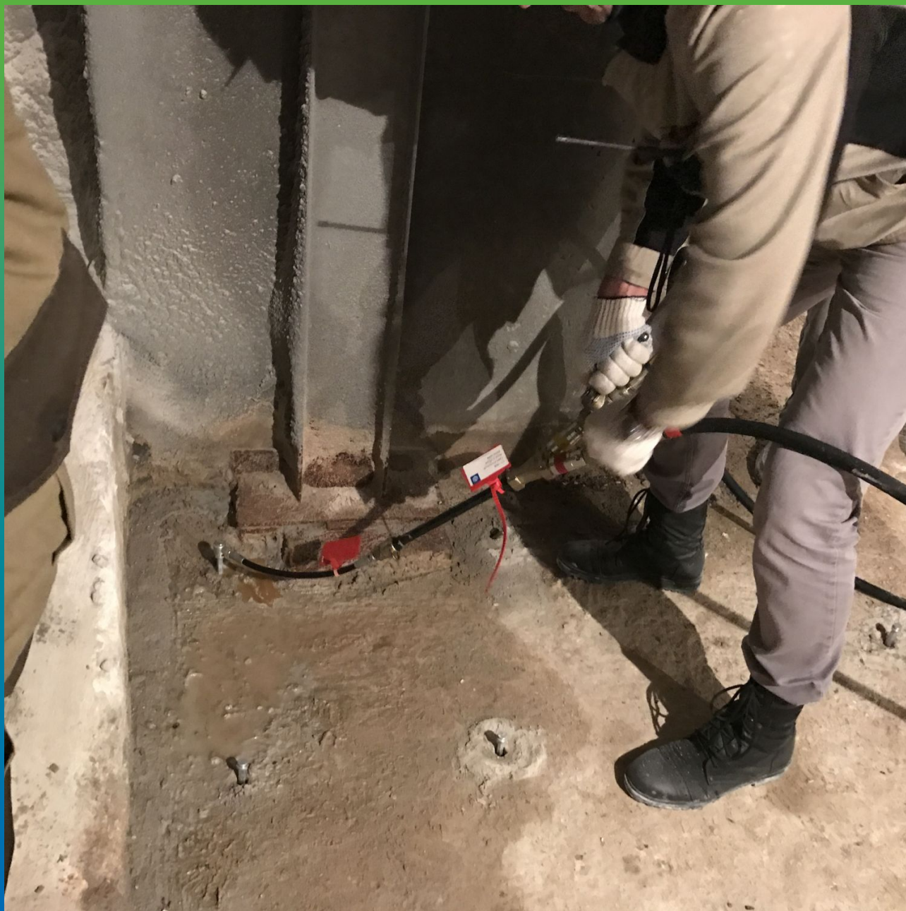
Нагнетание смолы Манопур 125 в зоне примыкания
