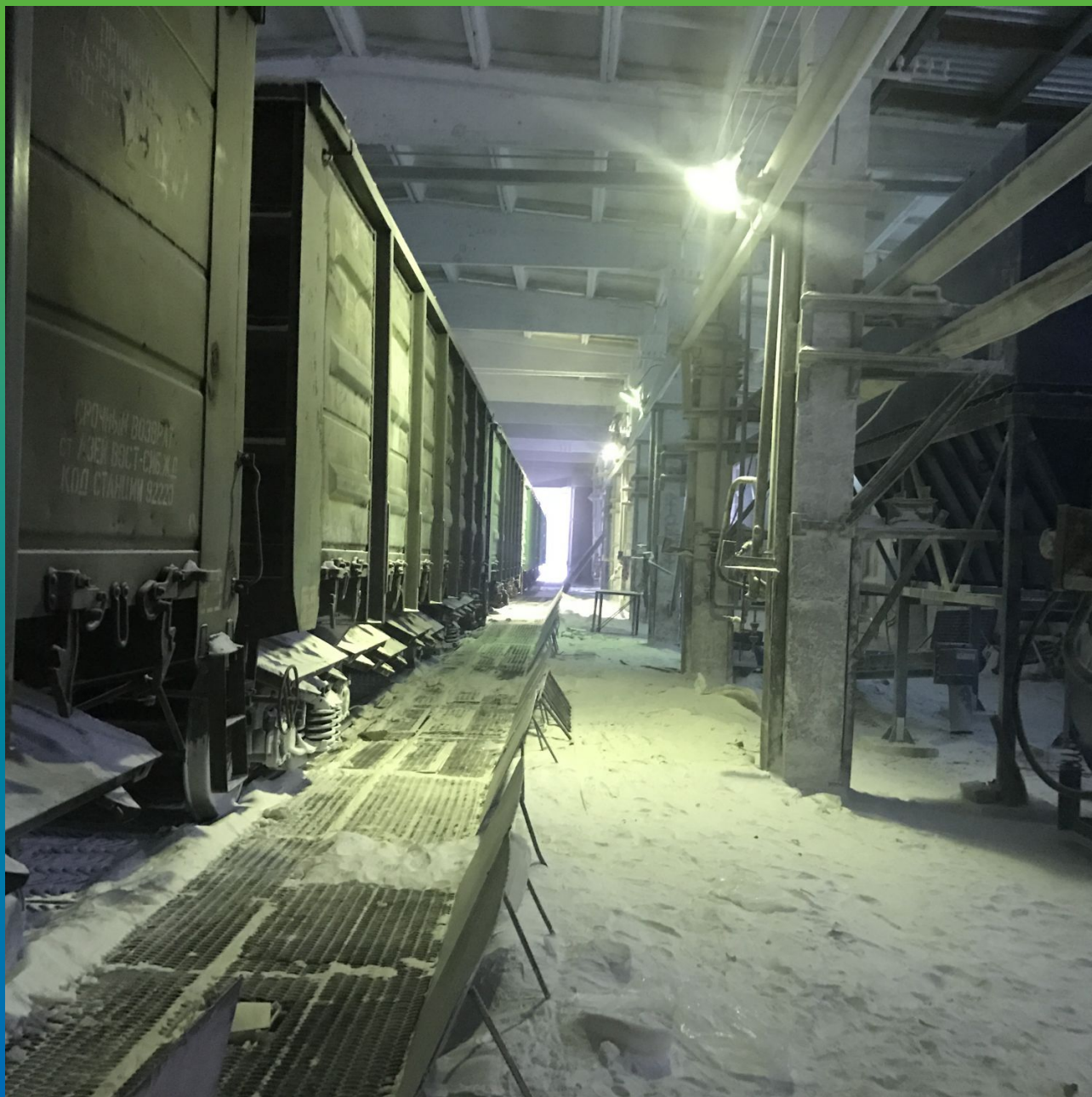
Выгрузная галерея на отметке -0.00 м.
