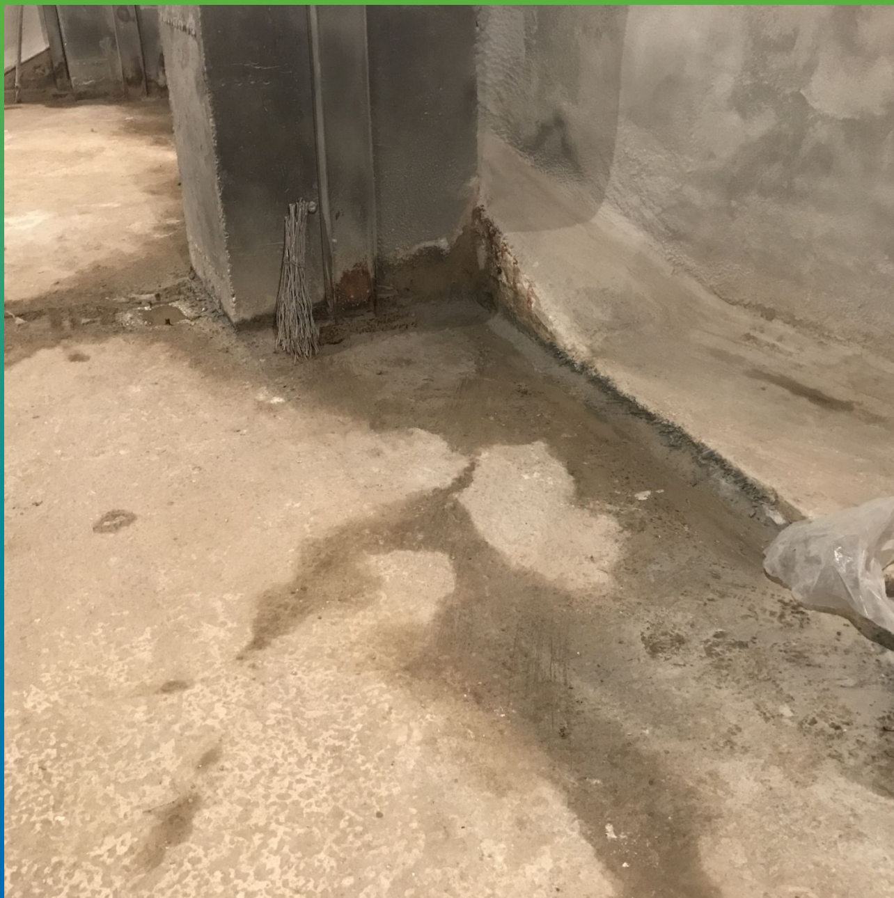
Места видимых протечек и замоканий
