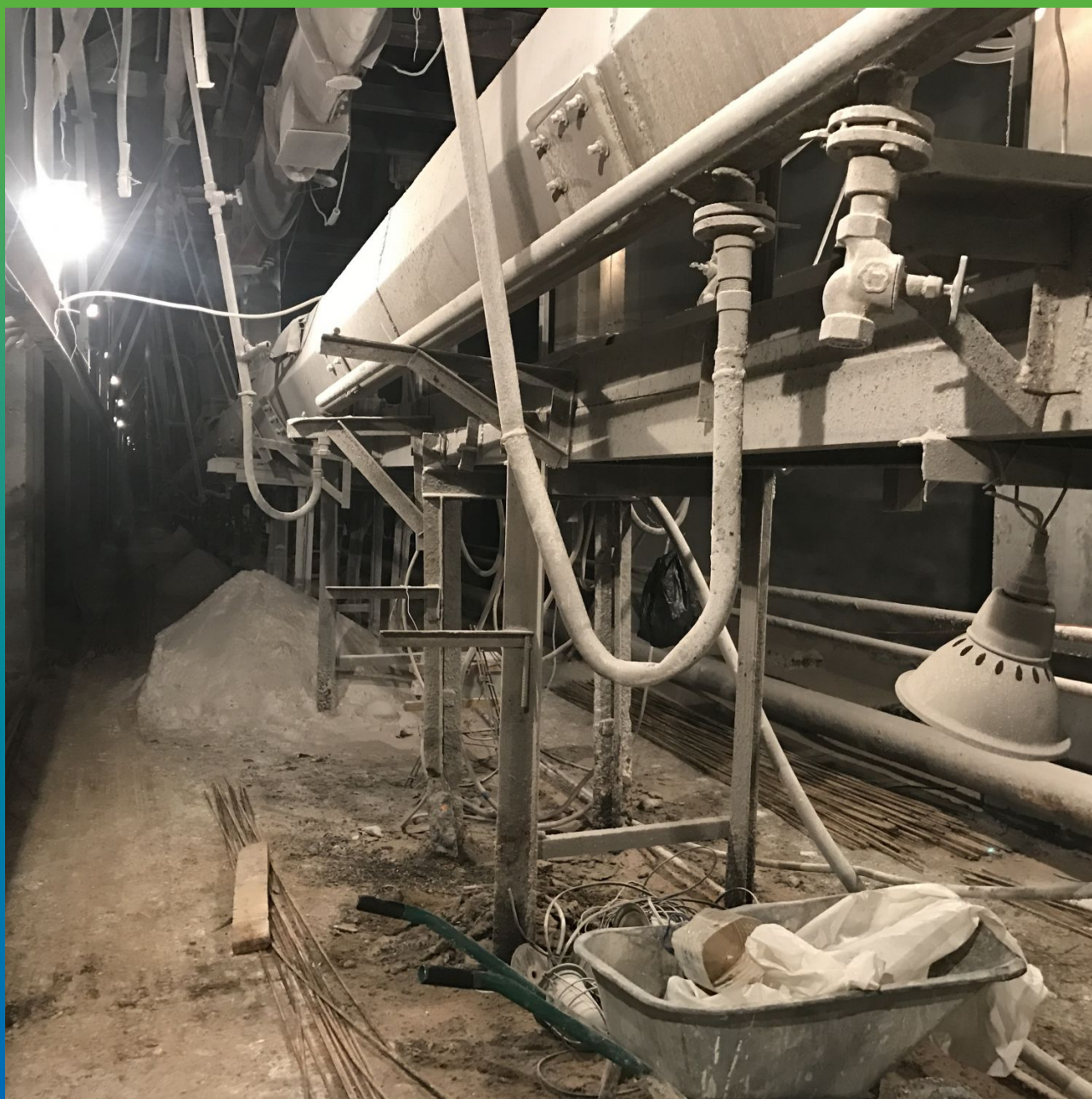
Подземная галерея на отметке -9,5 м.
