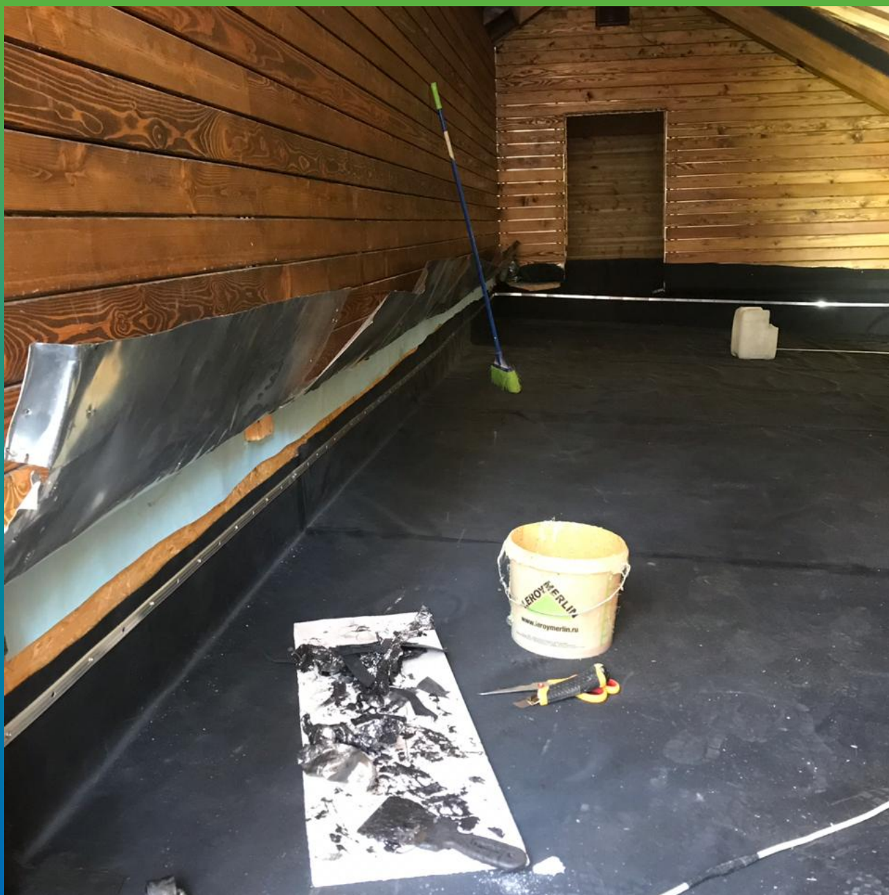
Мембрана, закрепленная на планки и обмазка планок составом Витрафин Бонд Ф
