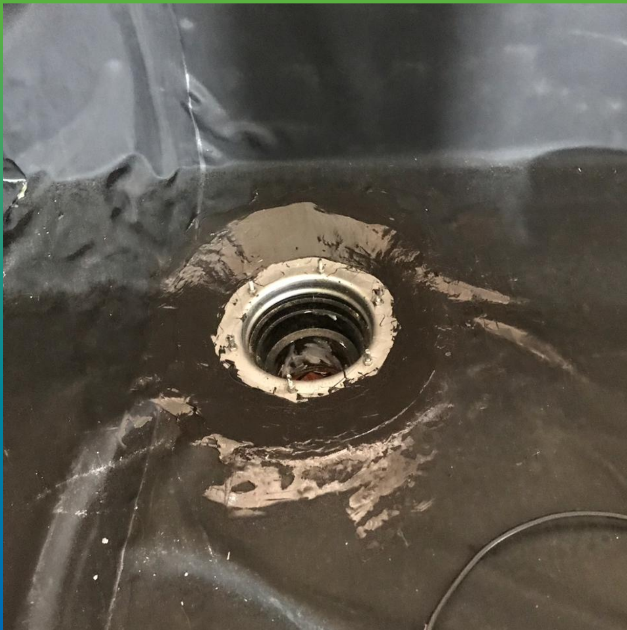
Обмазка сливной варонки составом Витрафин Бонд Ф
