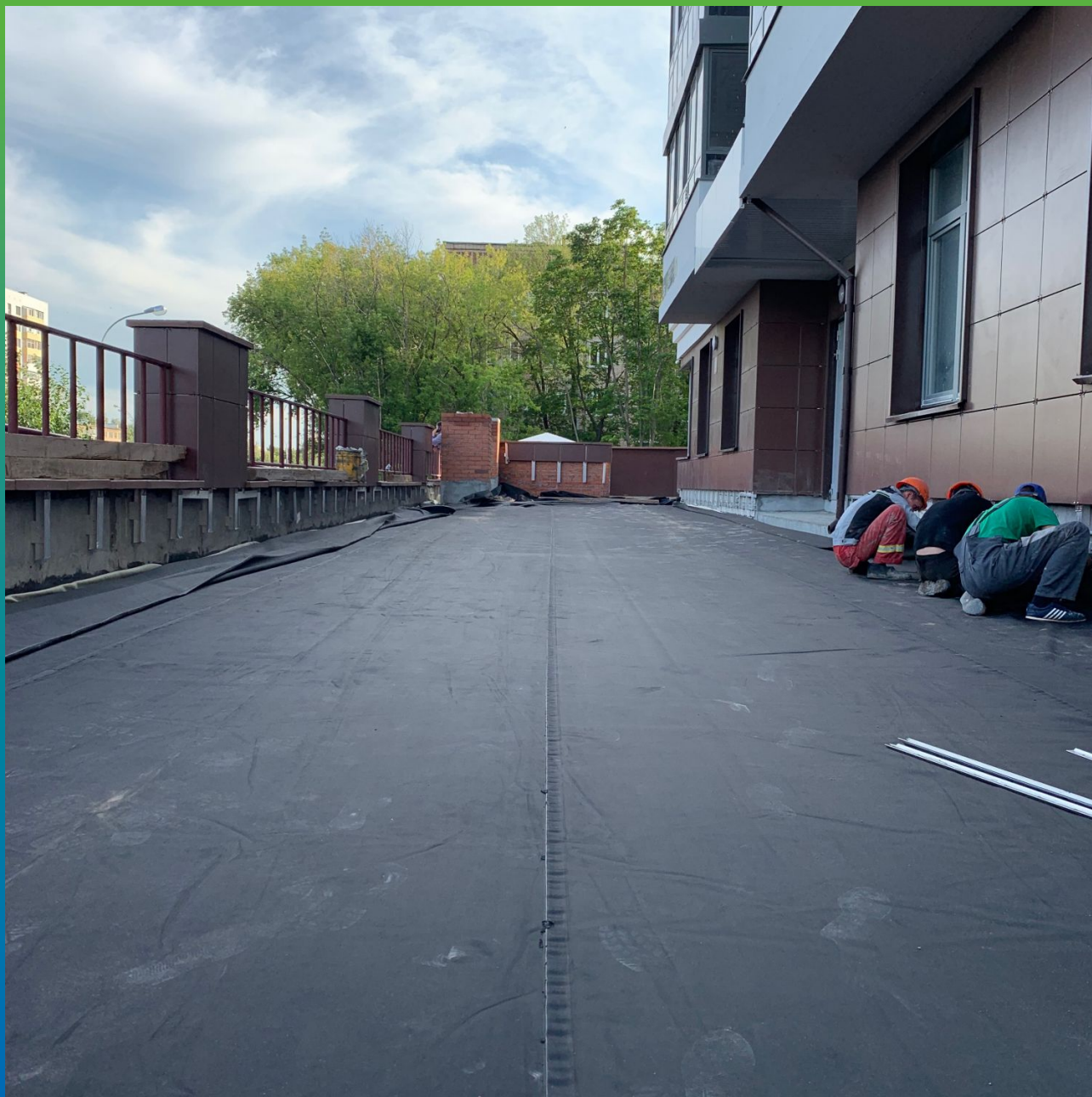
Внешний вид уложенной ЭПДМ мембраны
