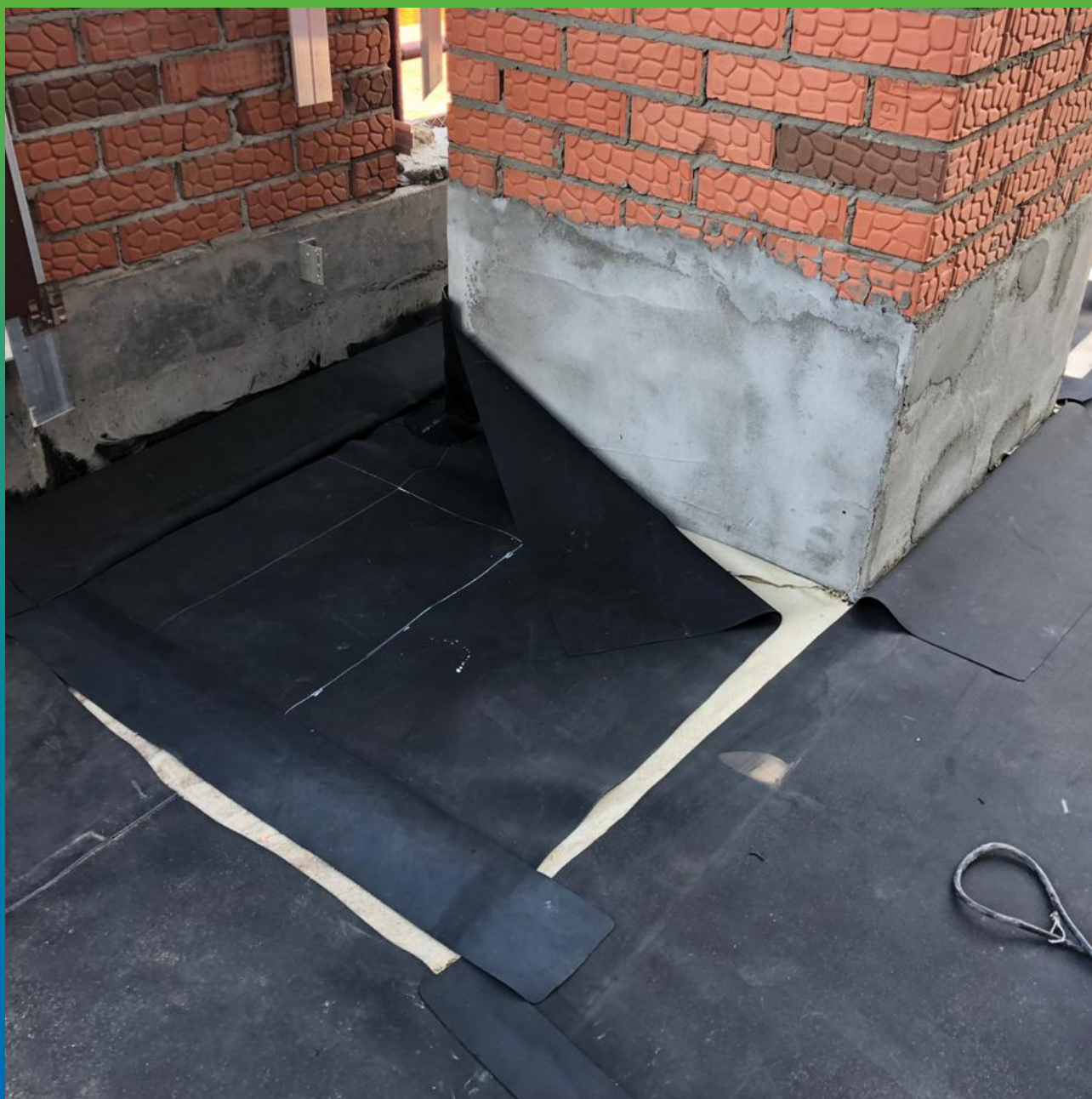
Обвод углов вентиляционных шахт на поверхности кровли
