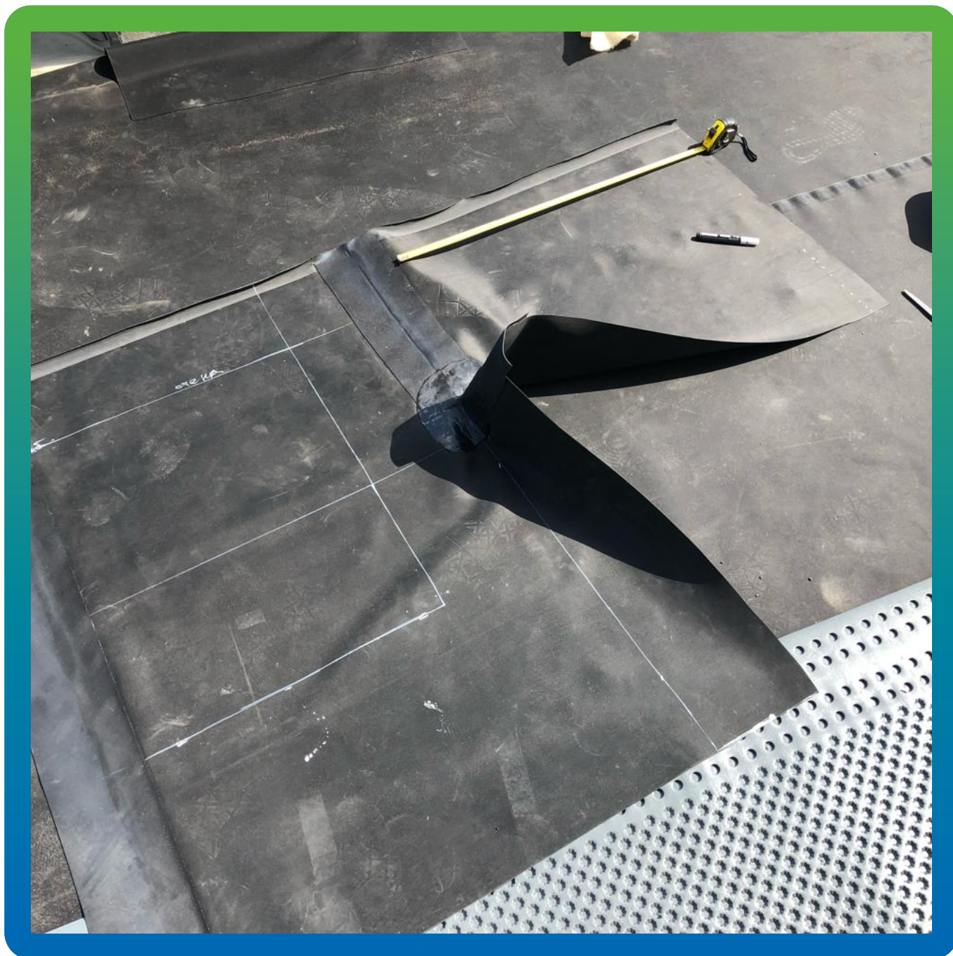
Обвод углов вентиляционных шахт на поверхности кровли
