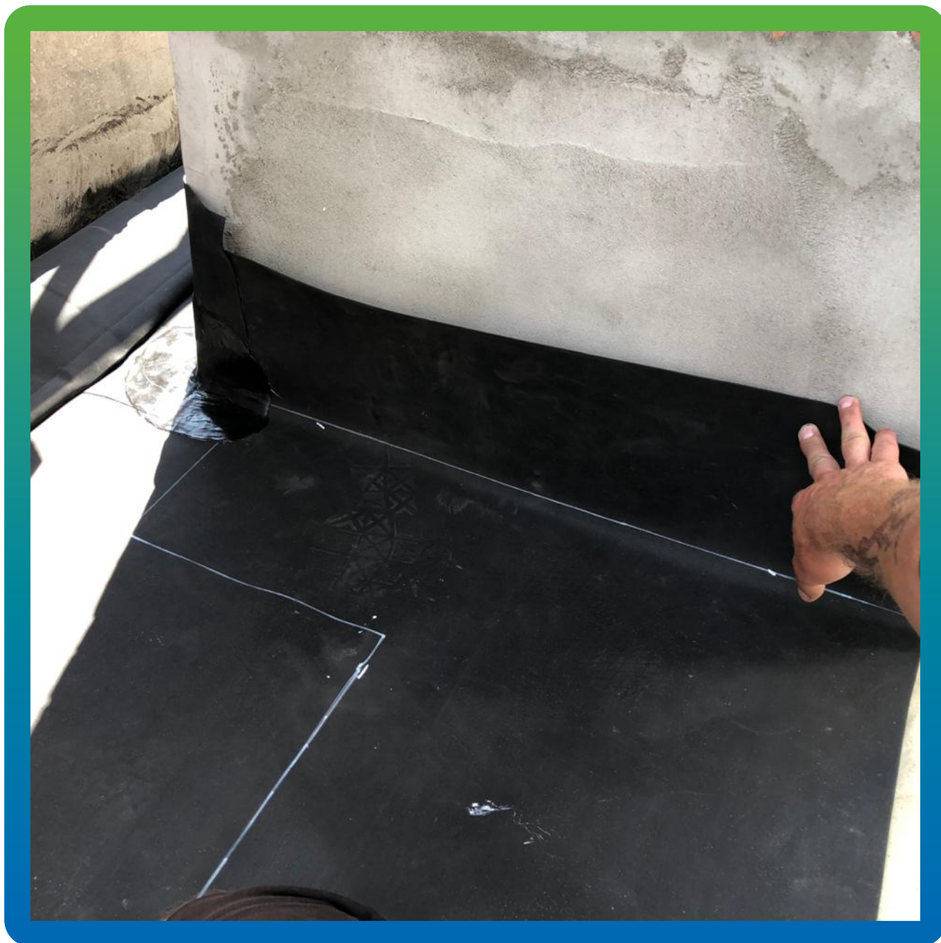
Обвод углов вентиляционных шахт на поверхности кровли
