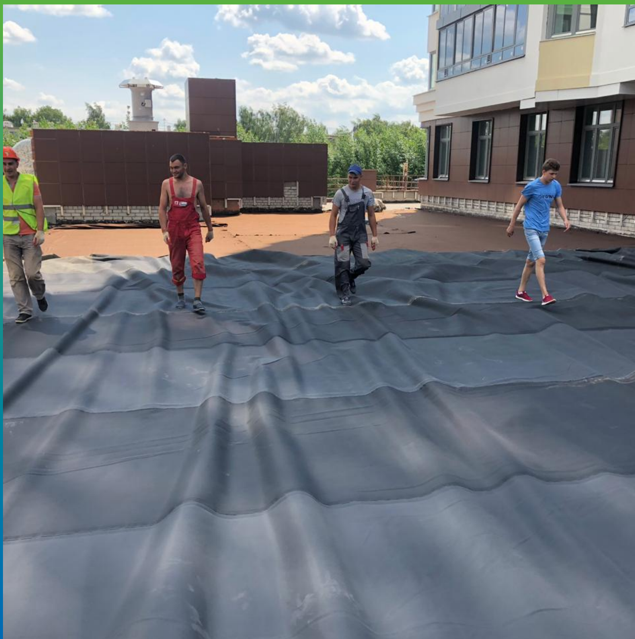
Раскладка мембраны сваренной в заводских условиях в готовые карты
