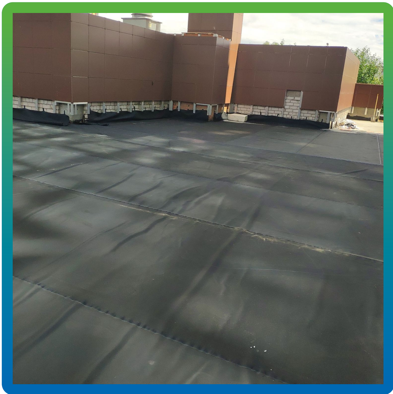
Внешний вид уложенной ЭПДМ мембраны
