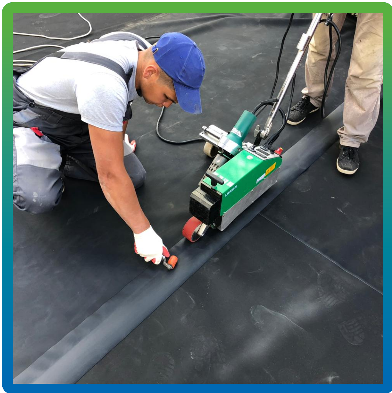
Сварка готовых карт мембраны между собой на объекте лентой Термобонд
