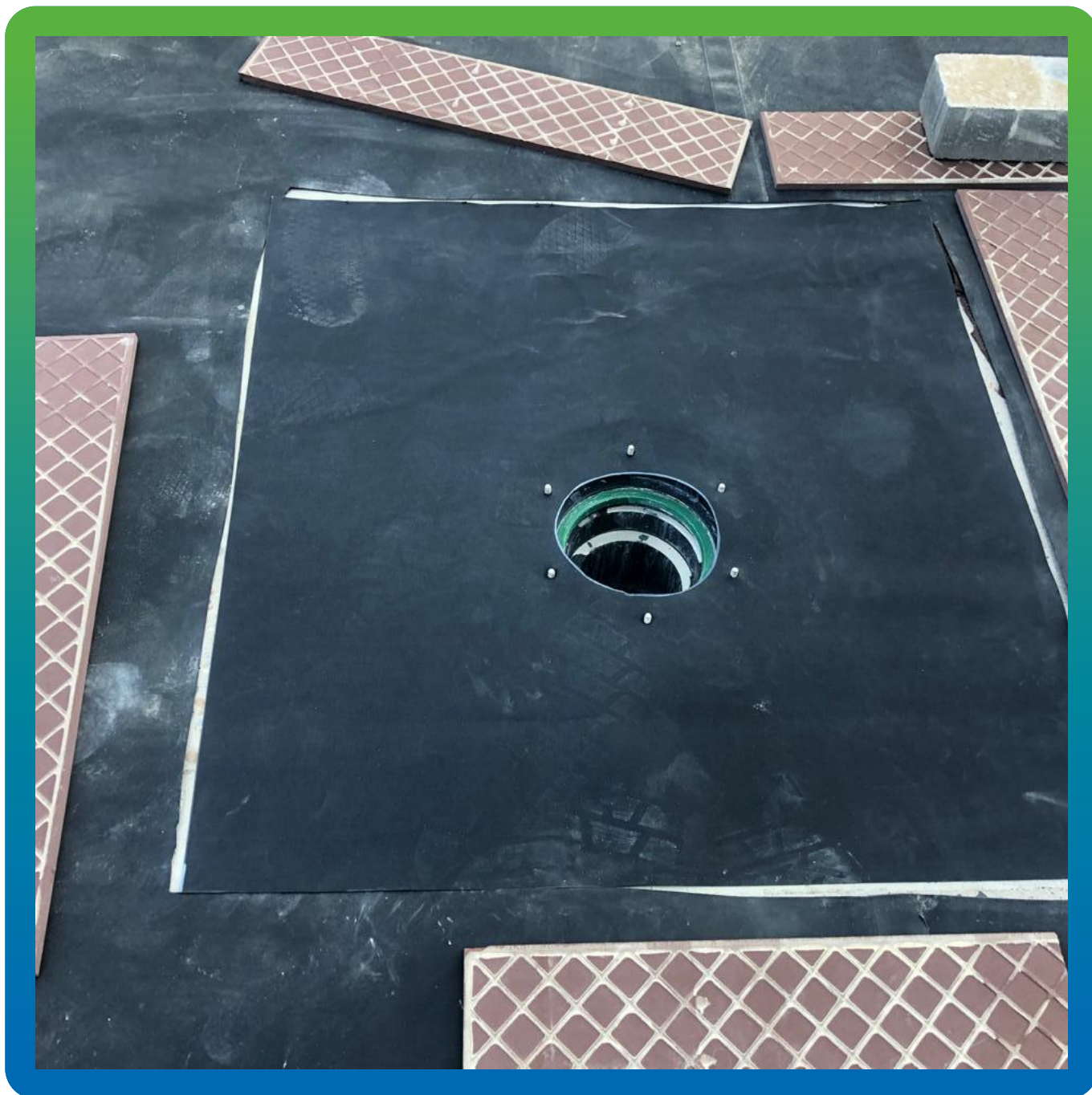
Герметизация сливной воронки
