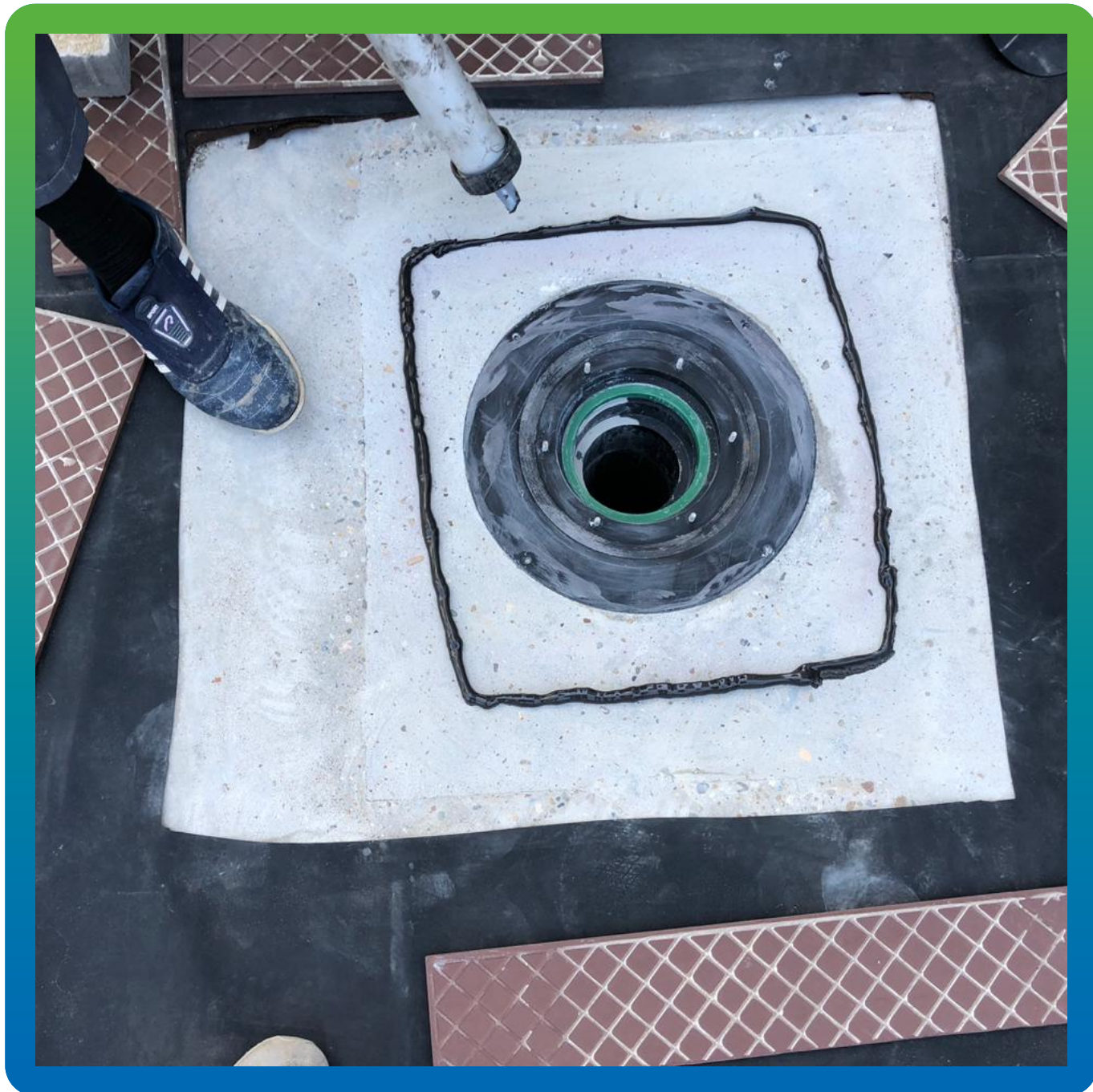
Герметизация сливной воронки
