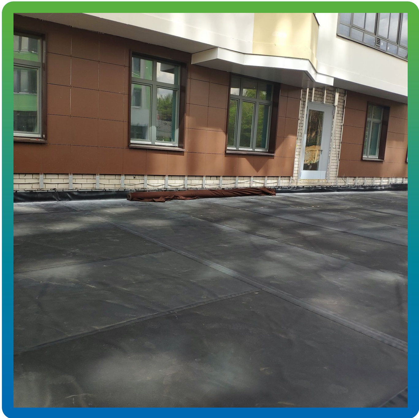
Внешний вид уложенной ЭПДМ мембраны
