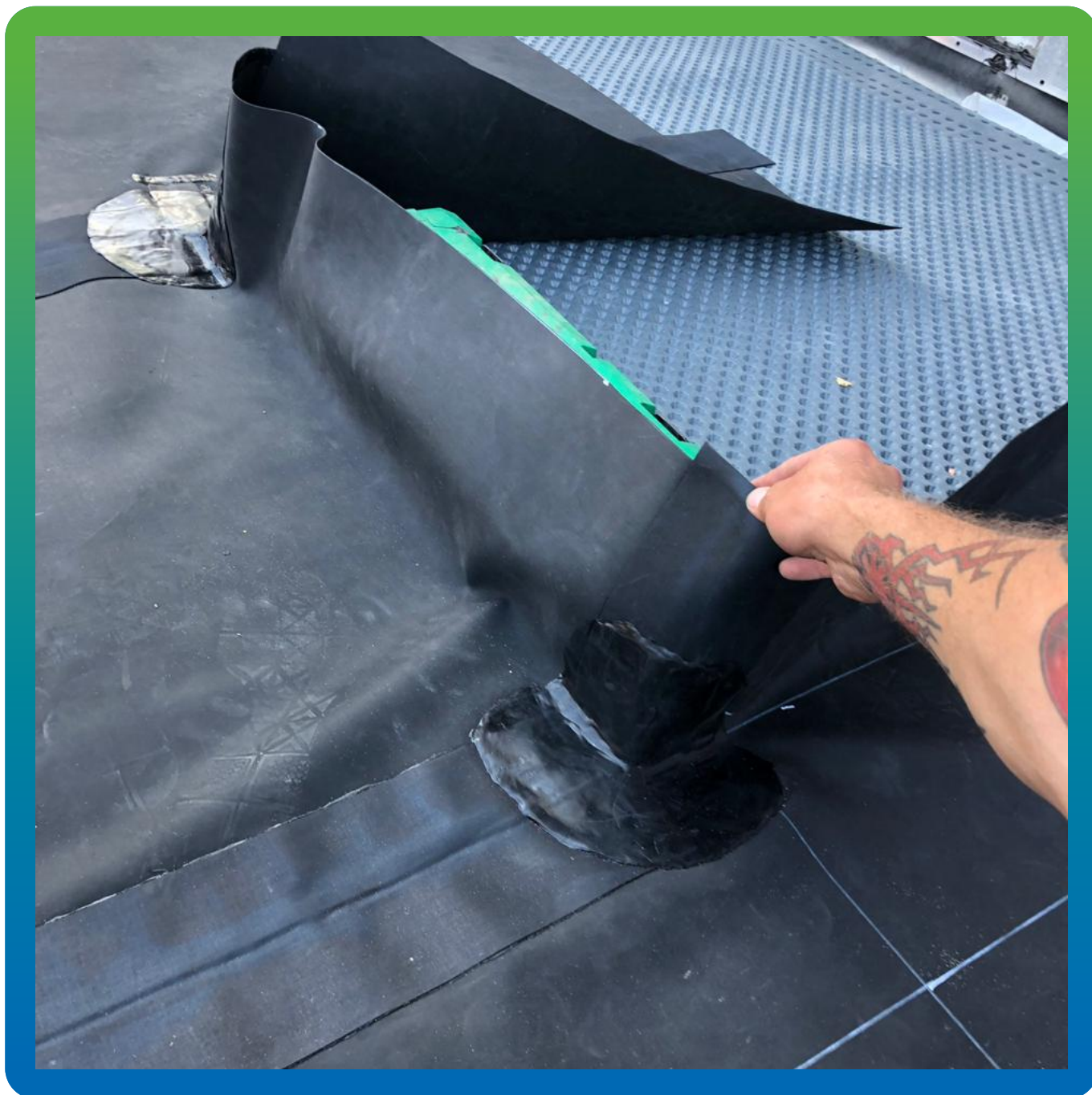
Обвод углов вентиляционных шахт на поверхности кровли
