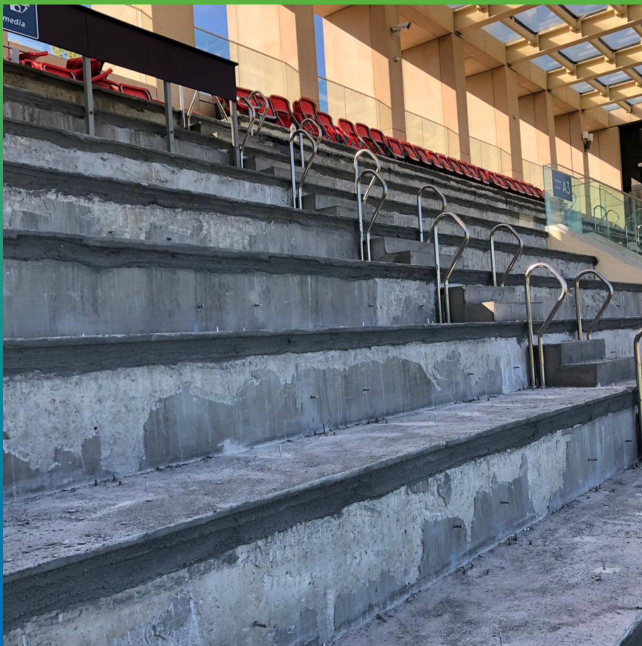
Подготовка к инъектированию Манопокс 352
