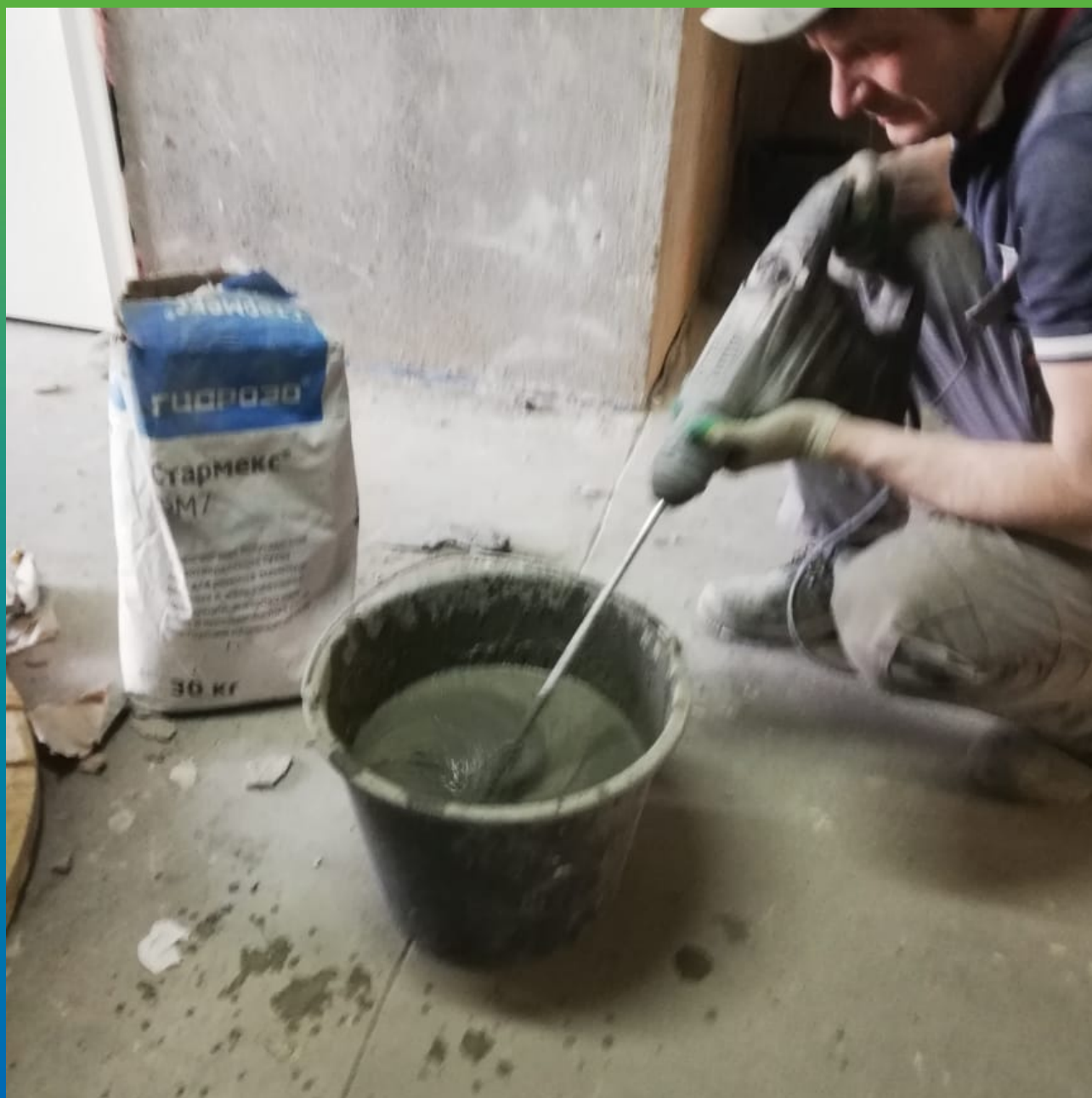
Замешивание Стармекс ФМ7
