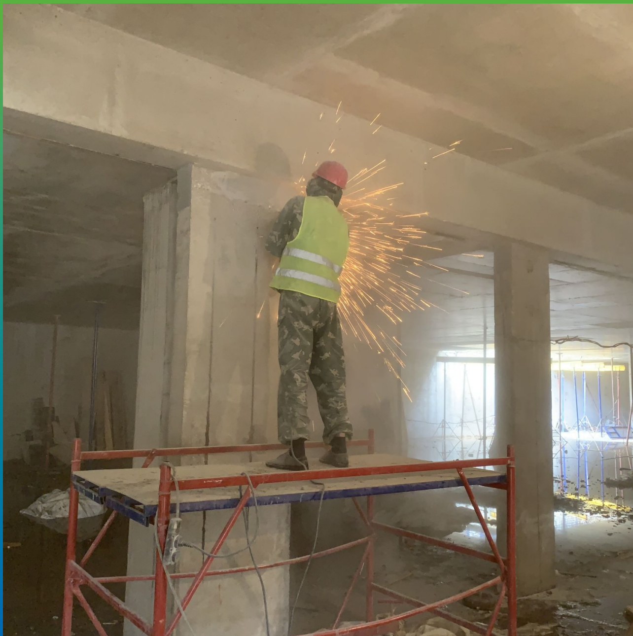
Удаление пакеров и шлифование Манопокс 331 до чистого основания
