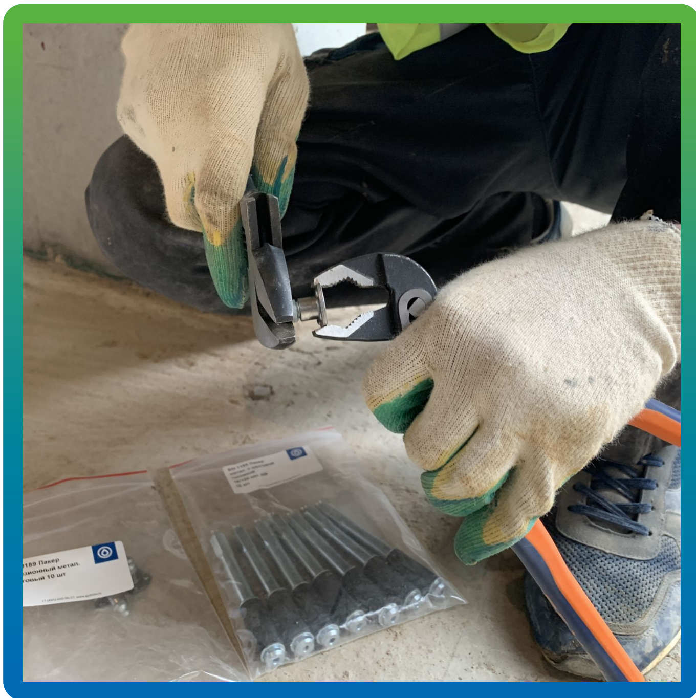
Откручивание головки пакера.
