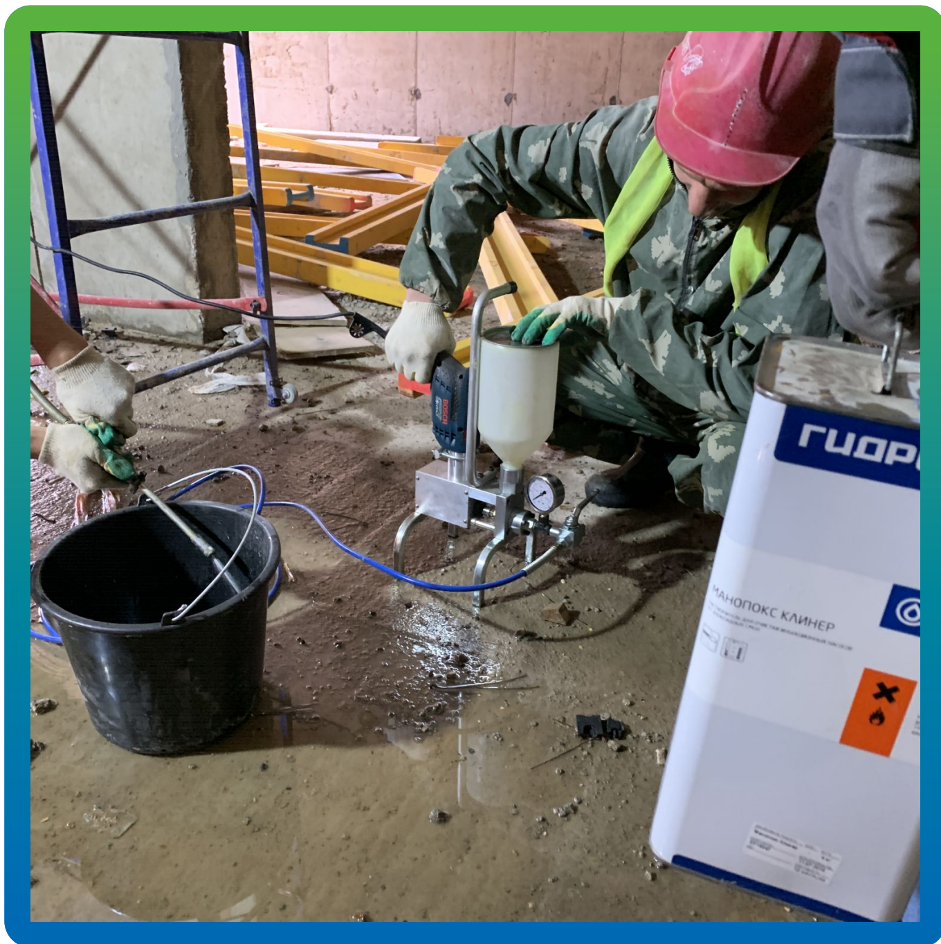
Промывка оборудования очистителем эпоксидных составов Манопокс Клинер.
