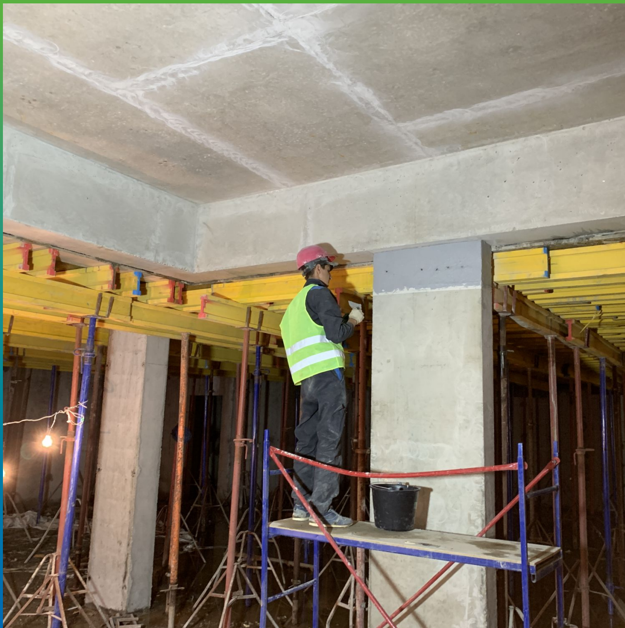
Монтаж адгезионных пакеров.
