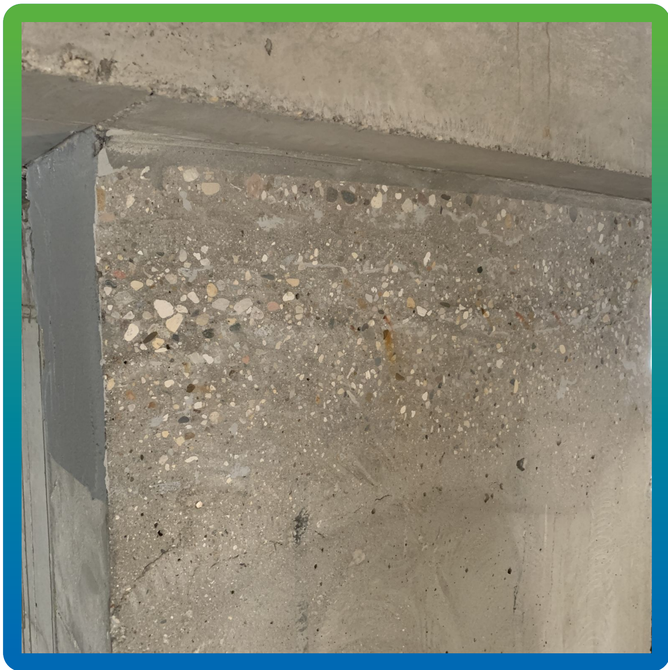
Результат инъекционных работ
