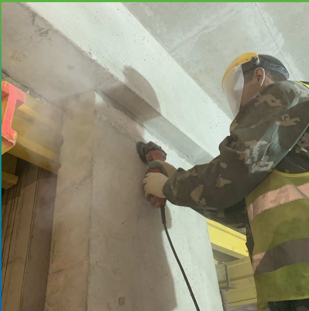
Шлифование проблемного участка.
