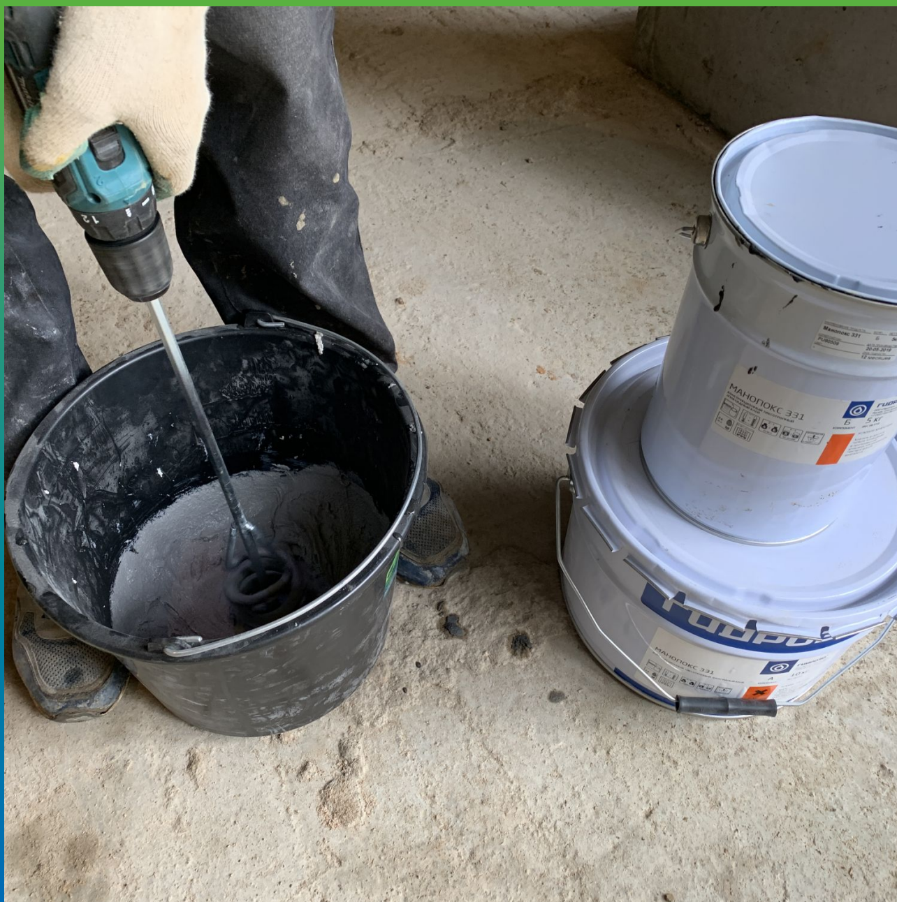
Смешивание компонентов эпоксидного состава Манопокс 331.
