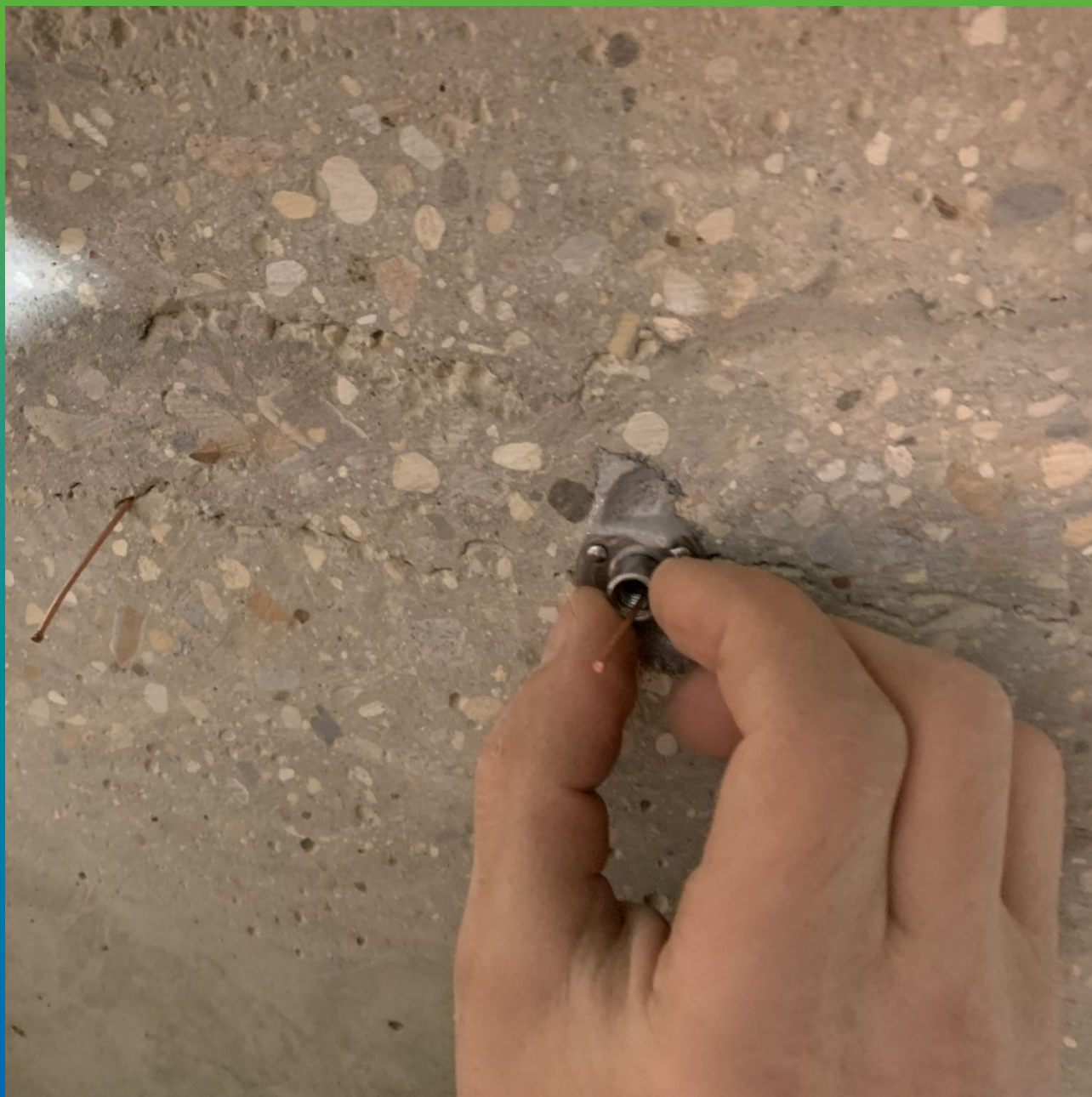
Монтаж адгезионного пакера БМ 0189 с применением Манопокс 331.
