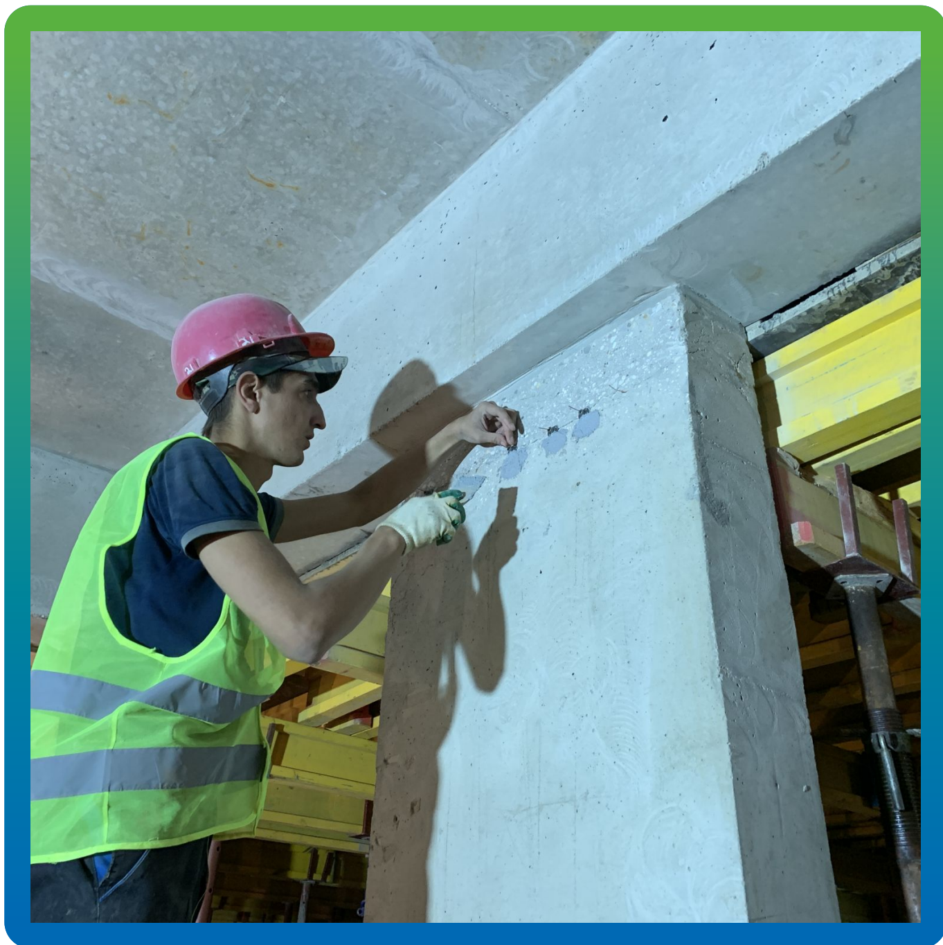
Монтаж адгезионных пакеров.
