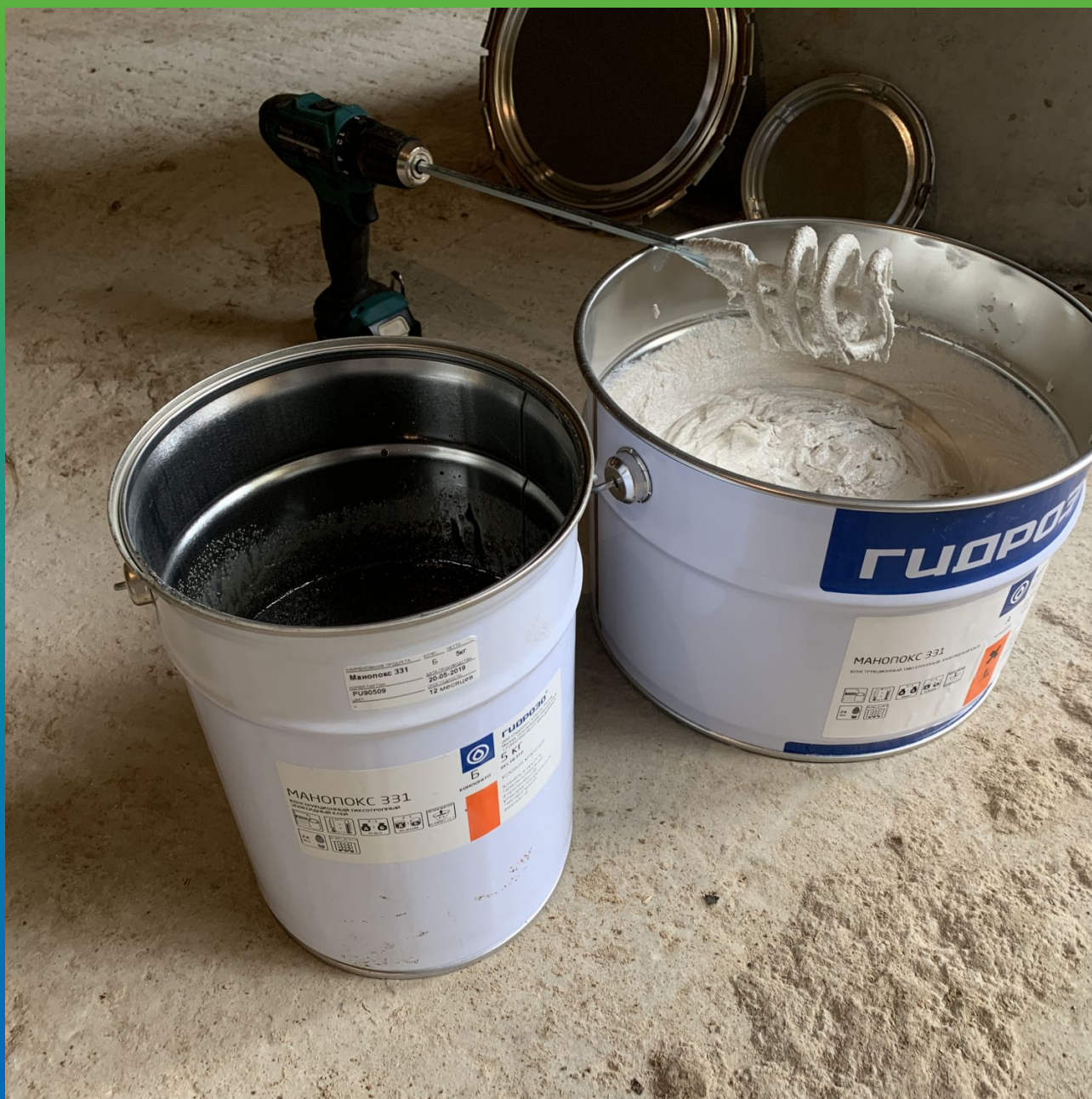
Перемешивание по отдельности компонентов Манопокс 331 перед смешиванием.
