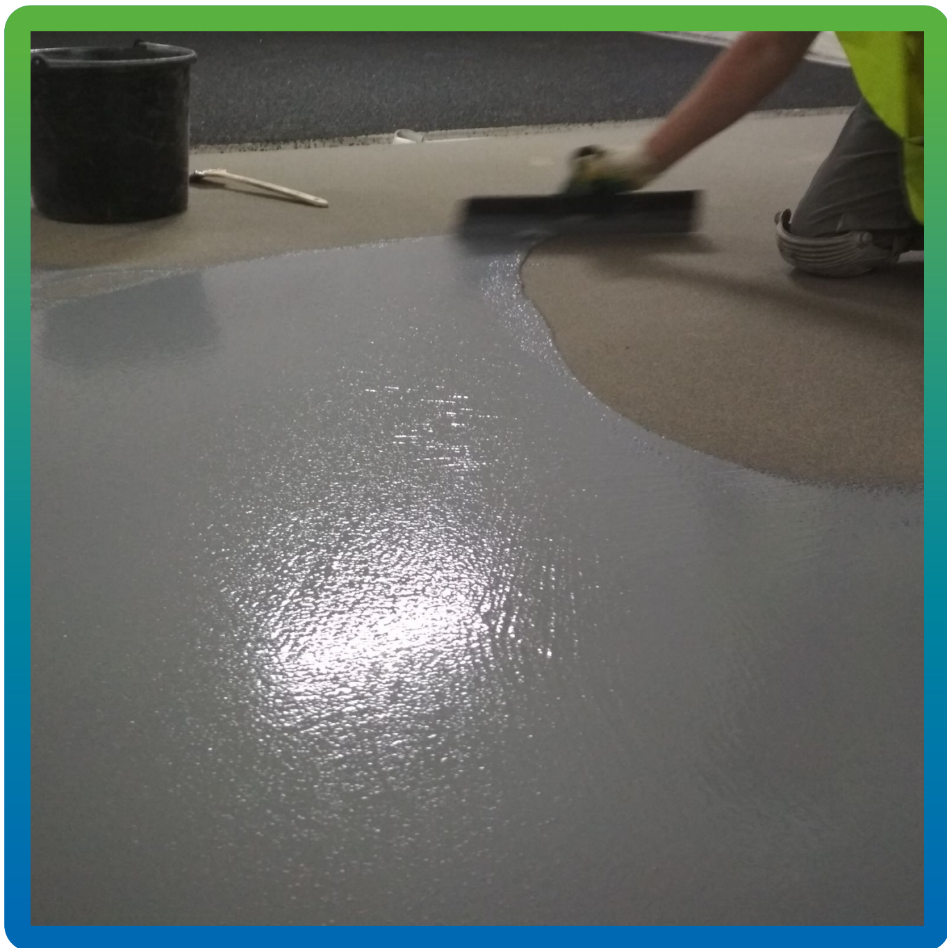
Нанесение финишного покрытия ДенсТоп ЭП 500
