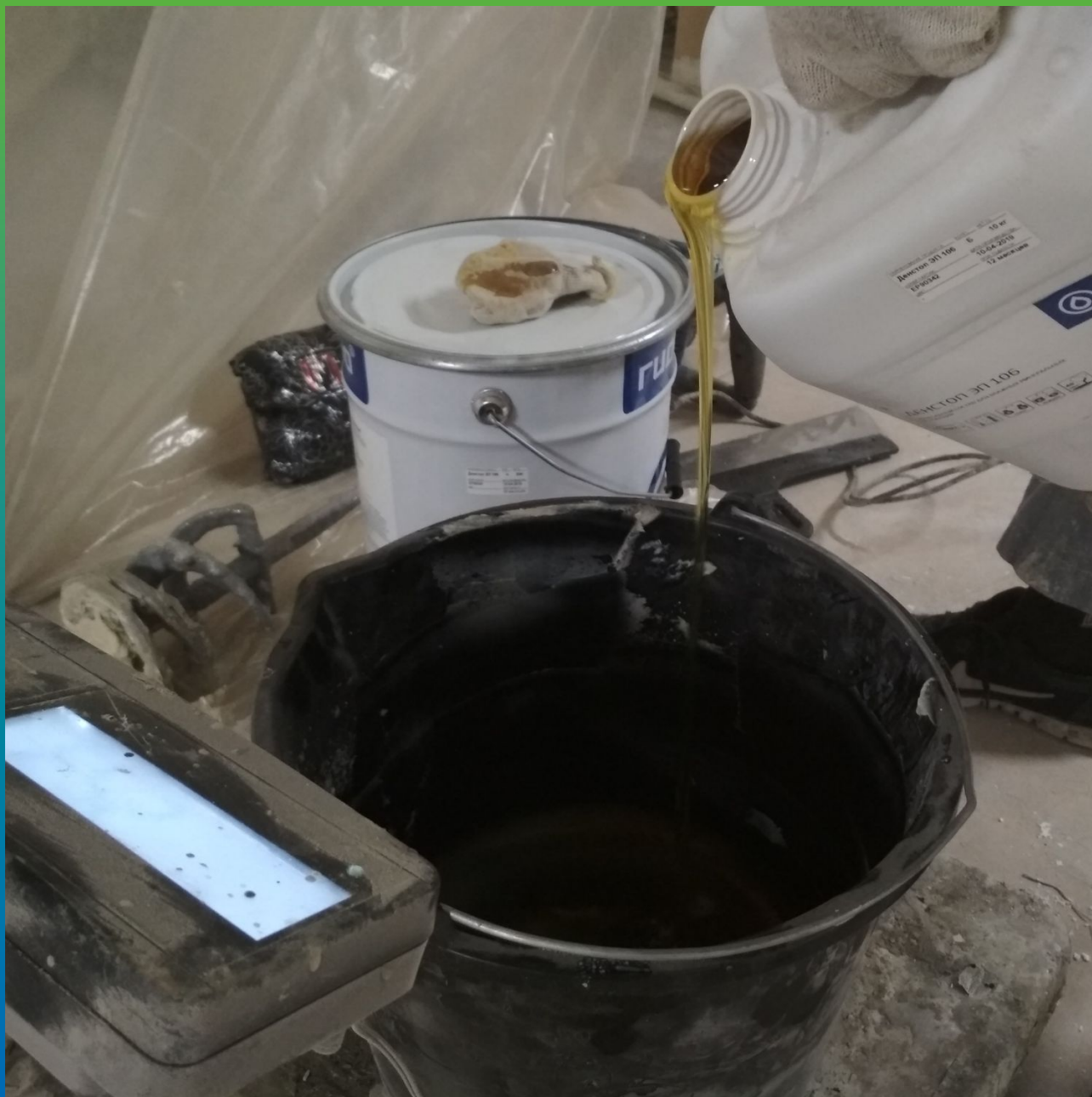
Приготовление грунтовки ДенсТоп ЭП 106
