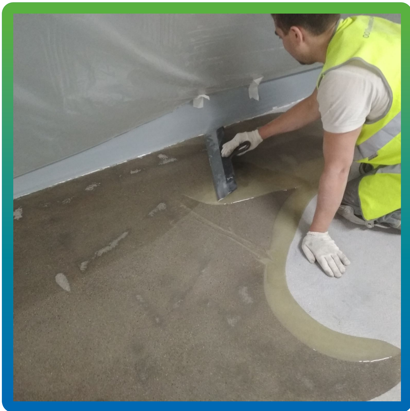
Нанесение грунтовочного состава ДенсТоп ЭП 106 на подготовленное основание
