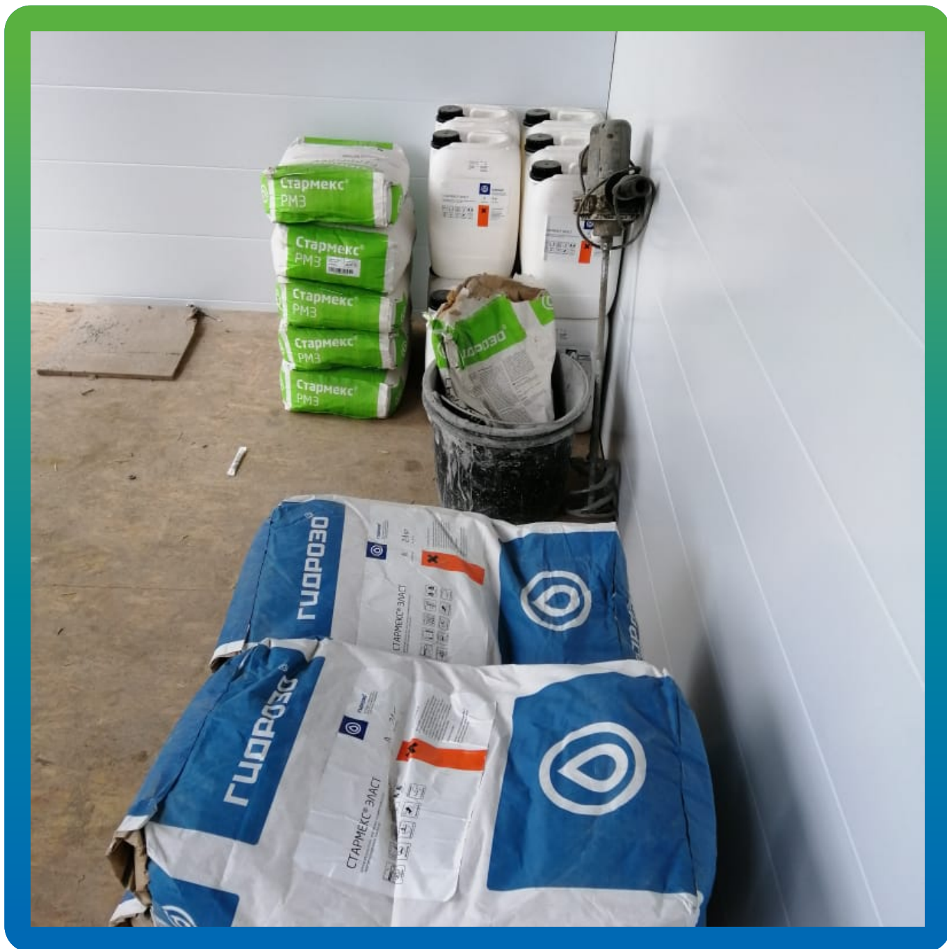
Материалы Гидрозо на объекте
