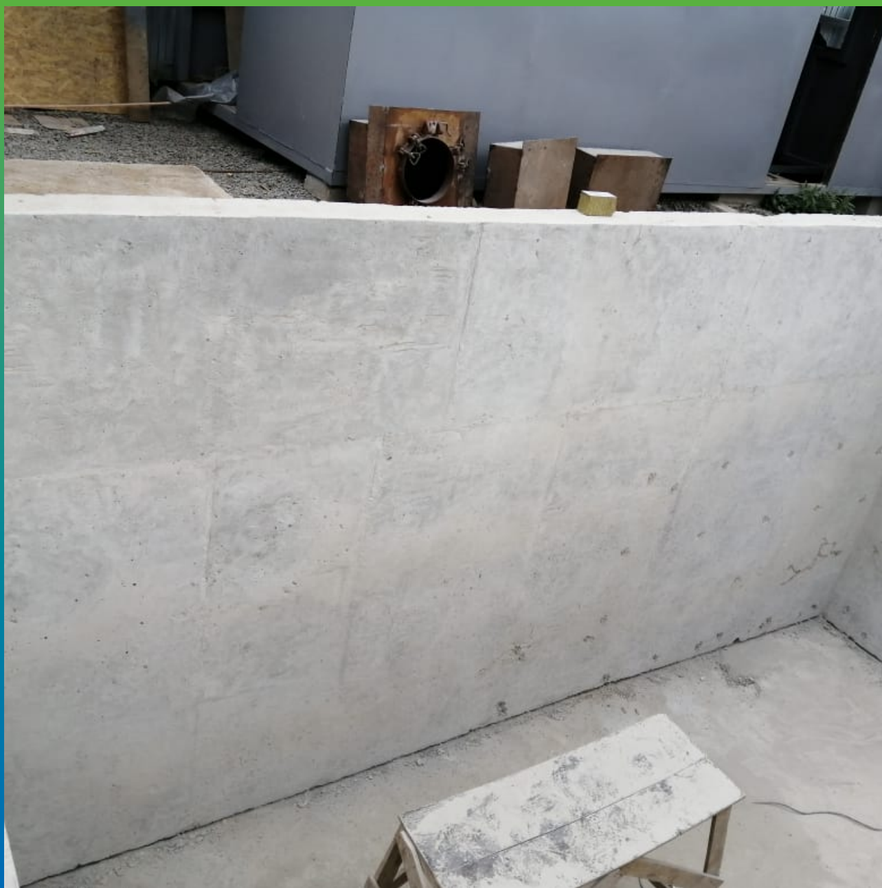
Расчеканка холодных швов и технологических отверстий
