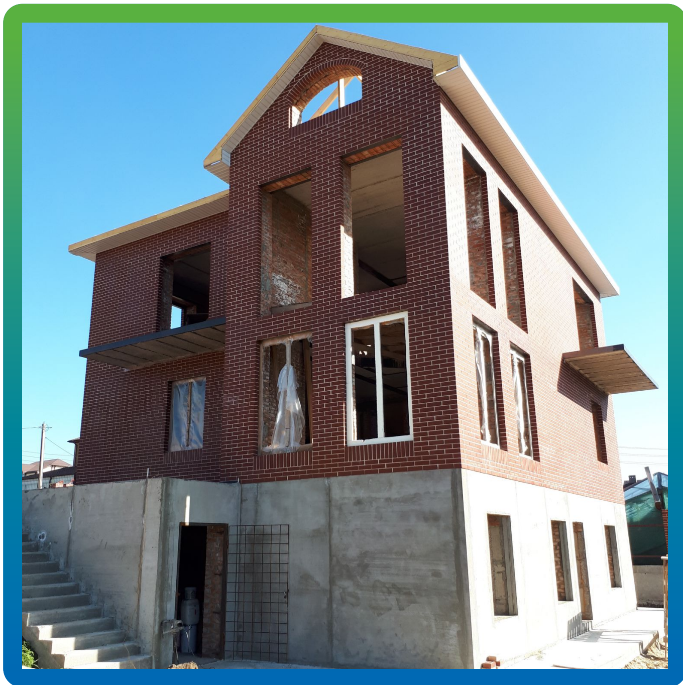
Вид после гидрофобизации кирпича составом Маногард 230
