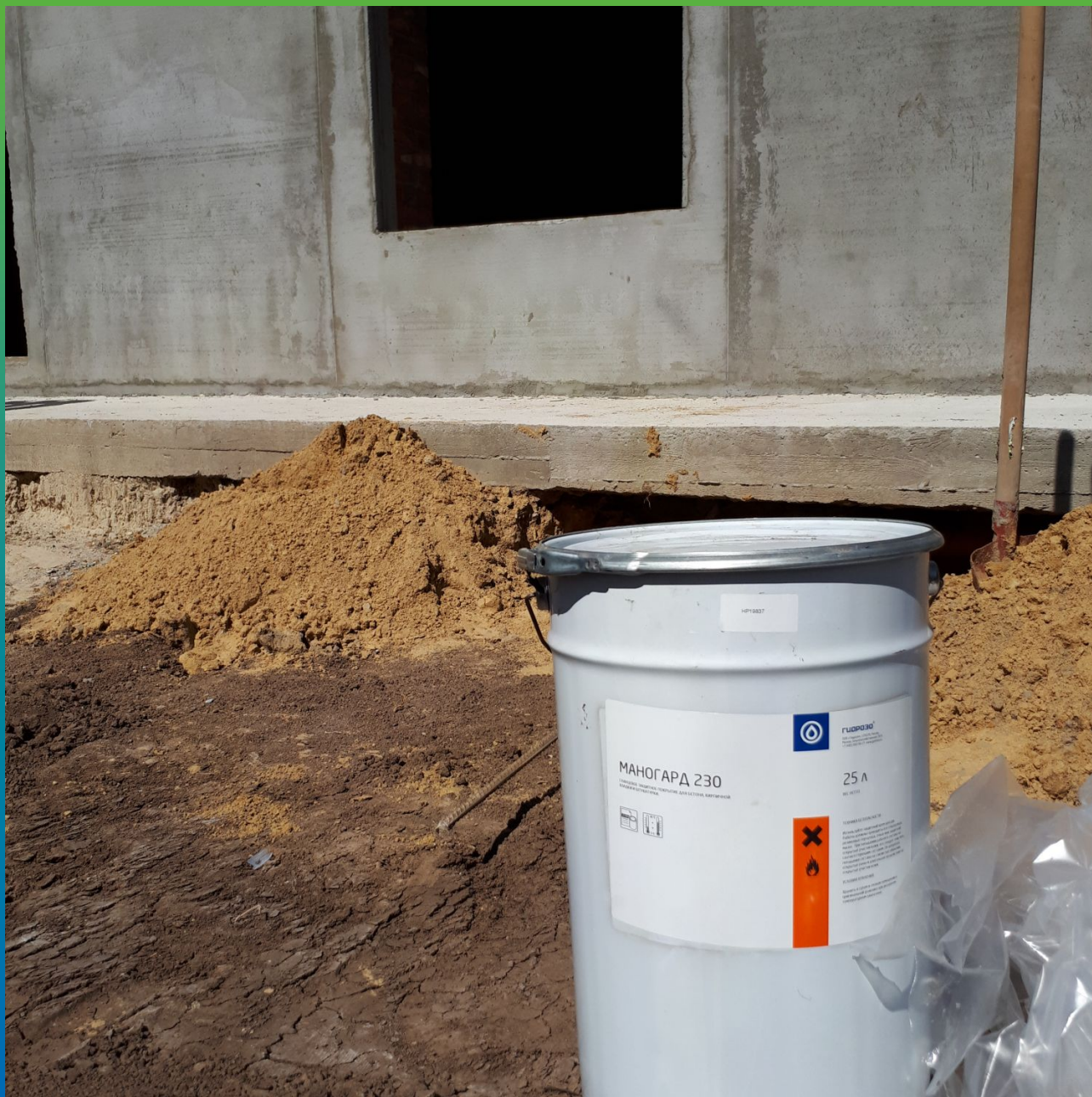
Материалы Гидрозо на объекте
