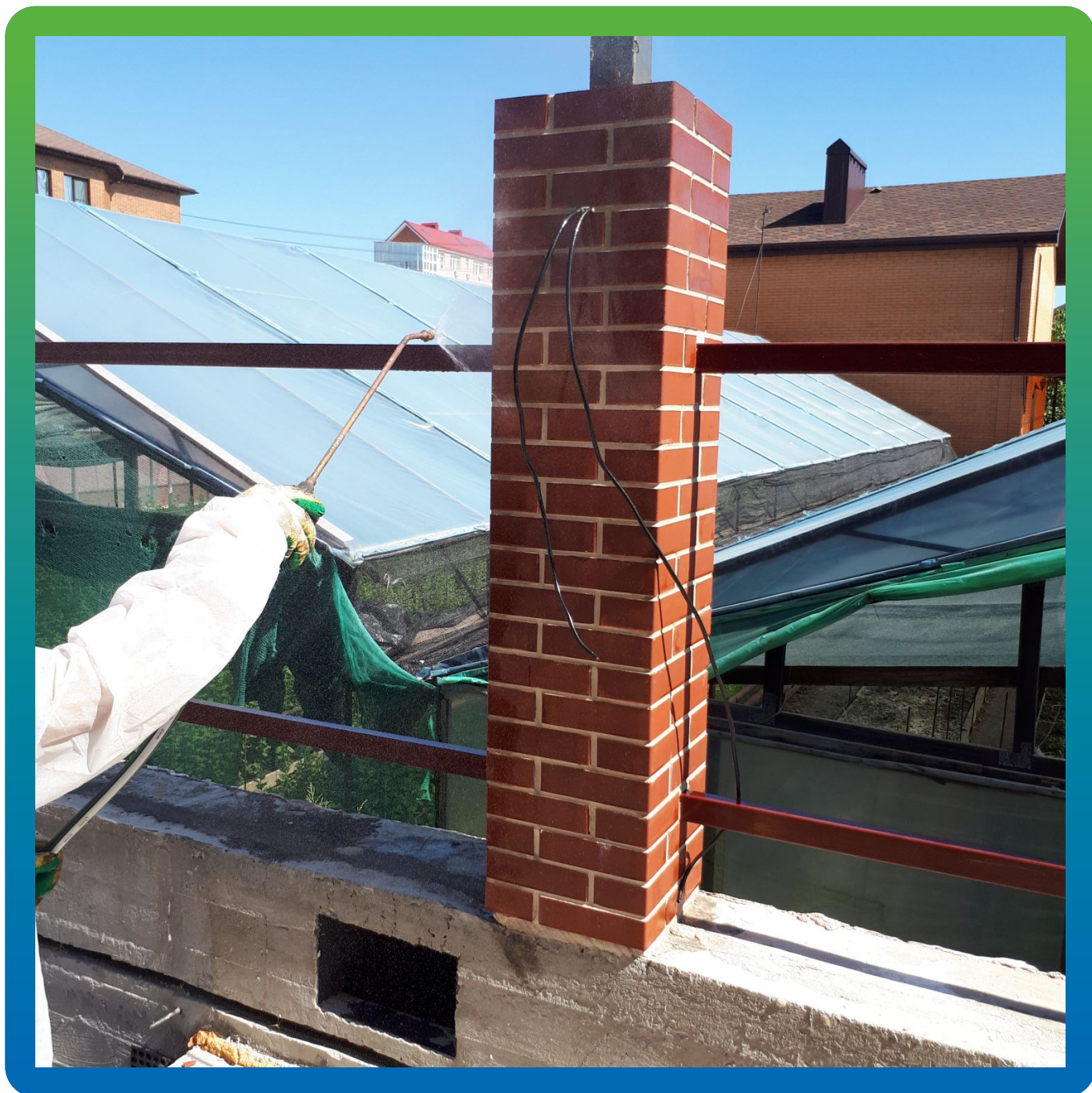
Процесс гидрофобизации кирпича
