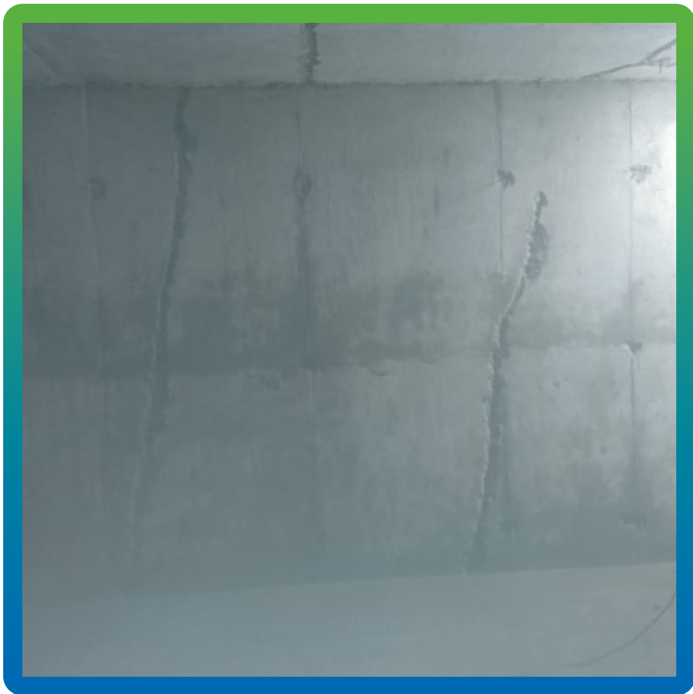
Расшивка трещин
