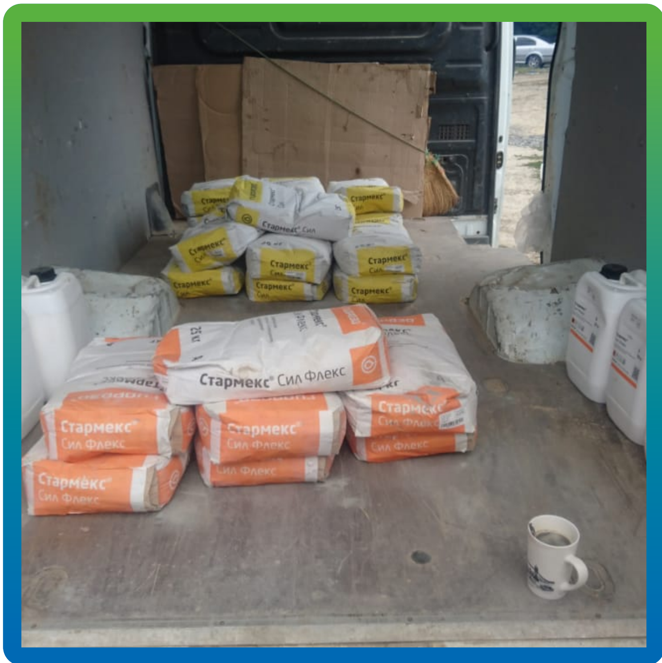
Материалы Гидрозо на объекте
