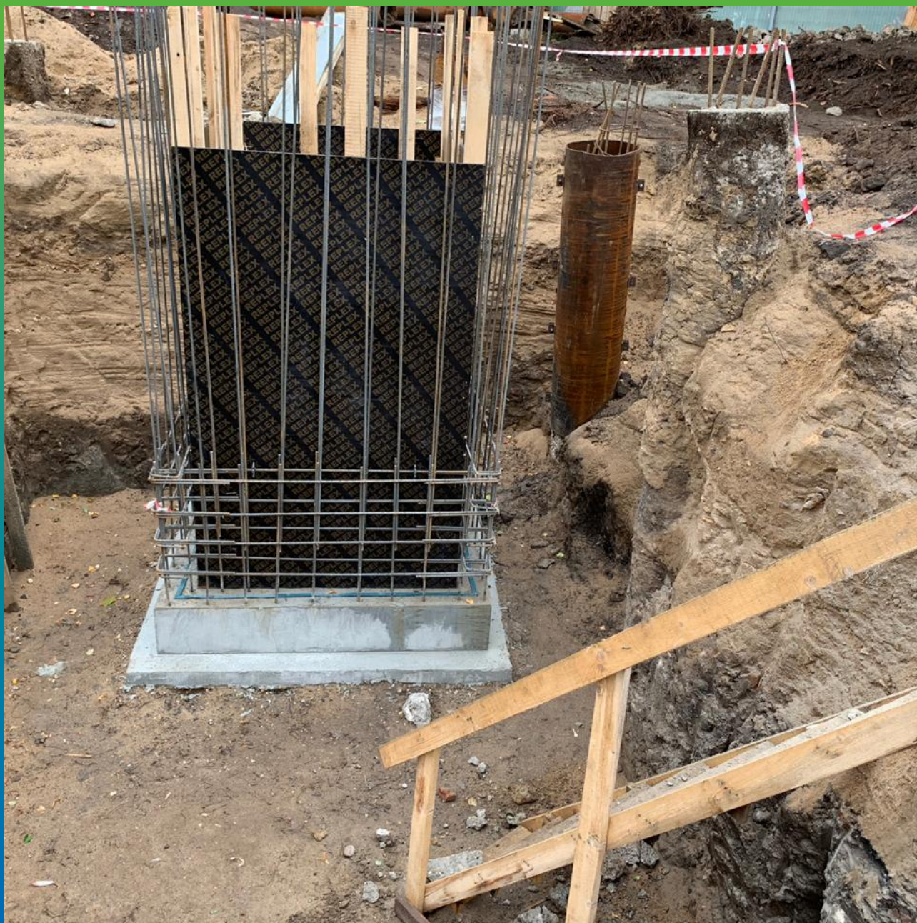
Укладка Манодил Свелл 2507 ад перед заливкой опалубки
