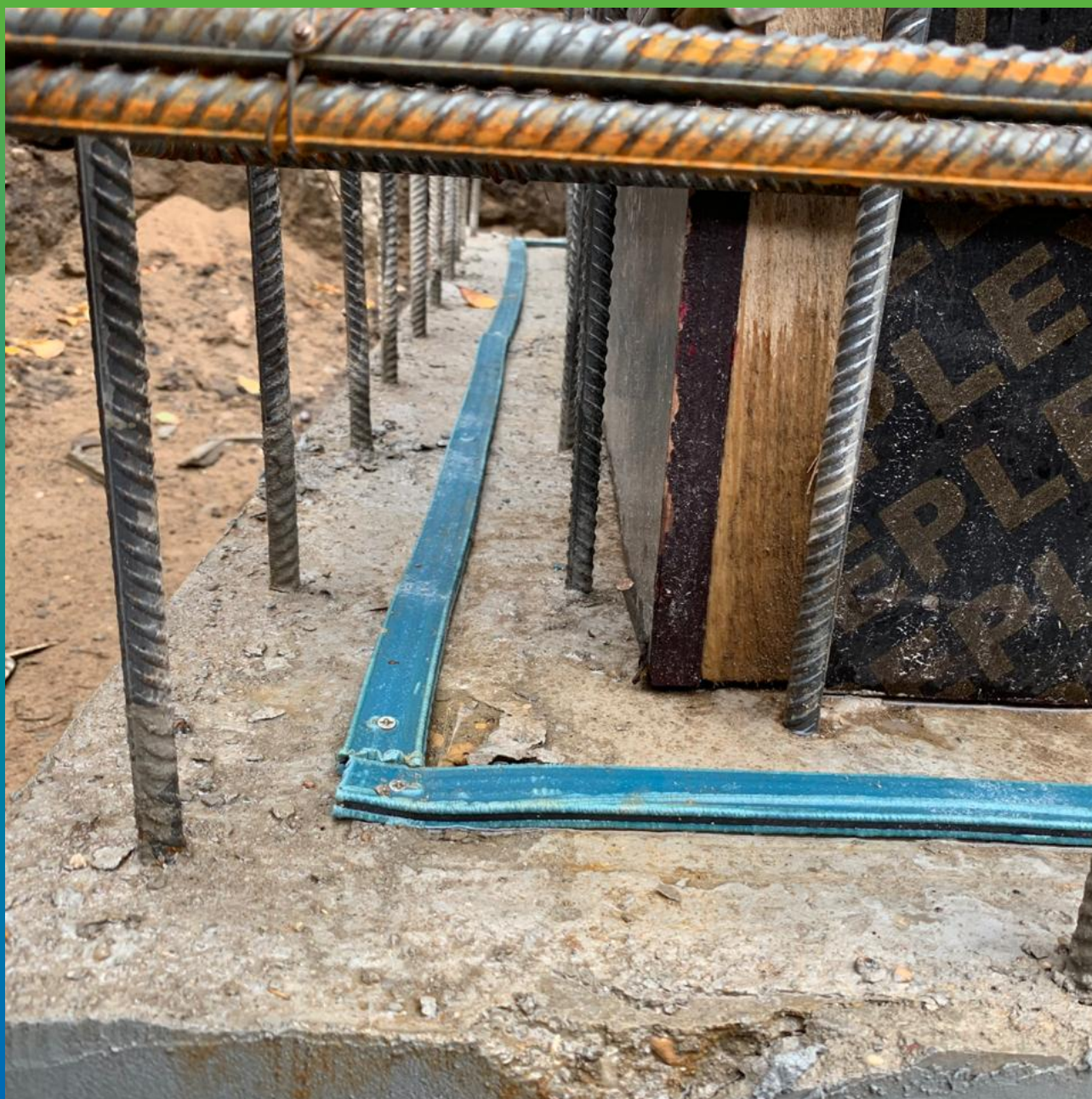
Монтаж Манодил Свелл 2507
