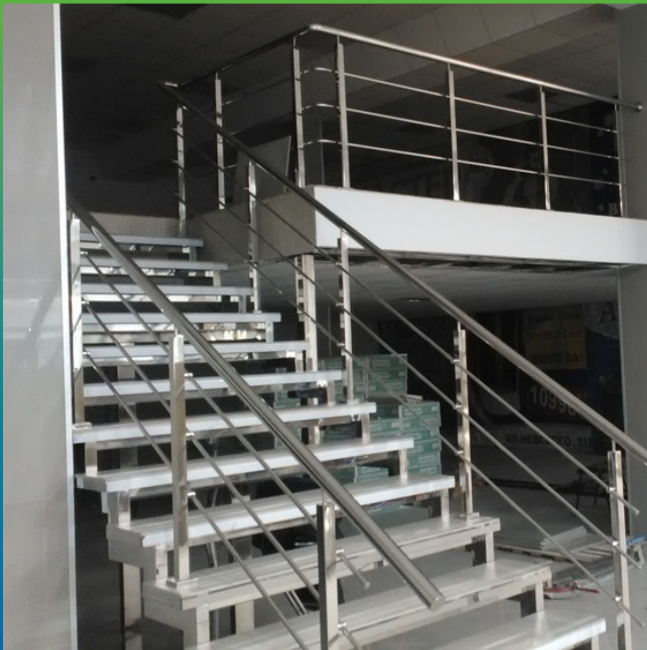
Лестница с гранитными ступенями, усиление несущей способности.
