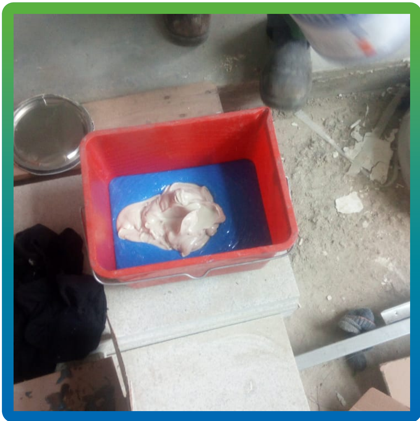
Замешивание клеевого состава Манопокс 183.
