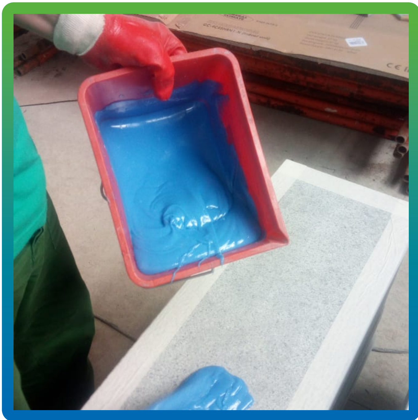
Нанесение клея на поверхность гранитной плиты.
