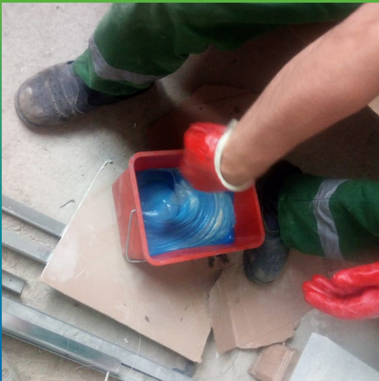
Замешивание клеевого состава Манопокс 183 в необходимом объеме.
