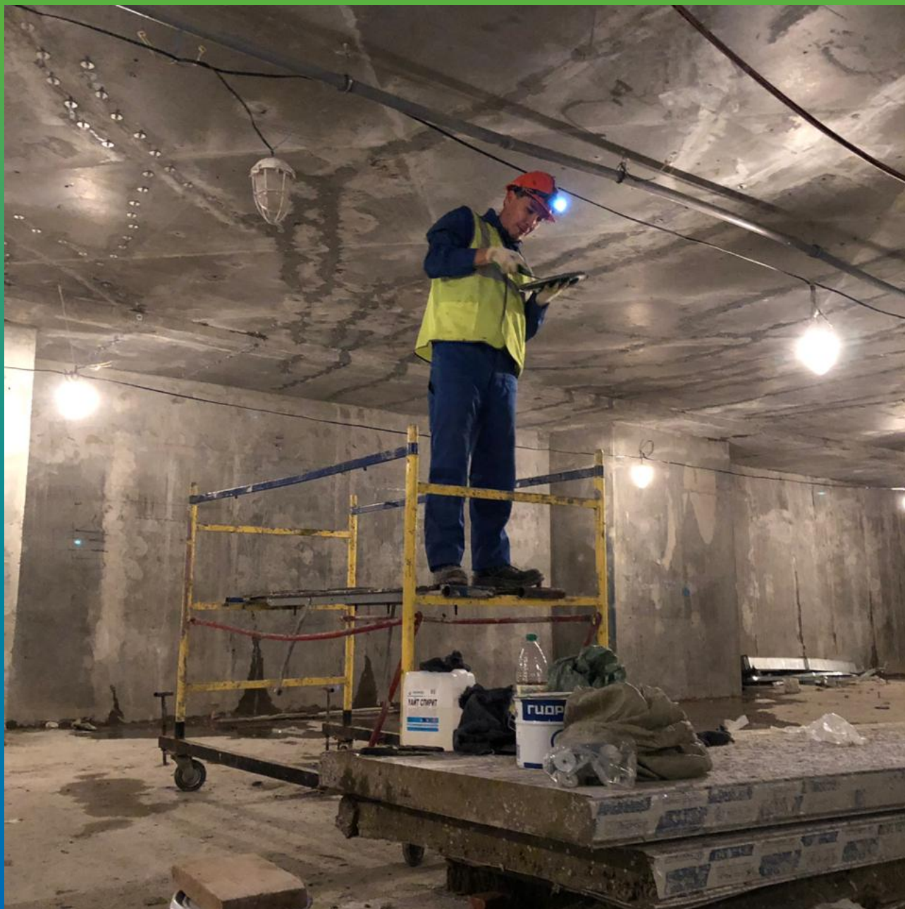
Обмазка пакеров и трещины составом Манопокс 331
