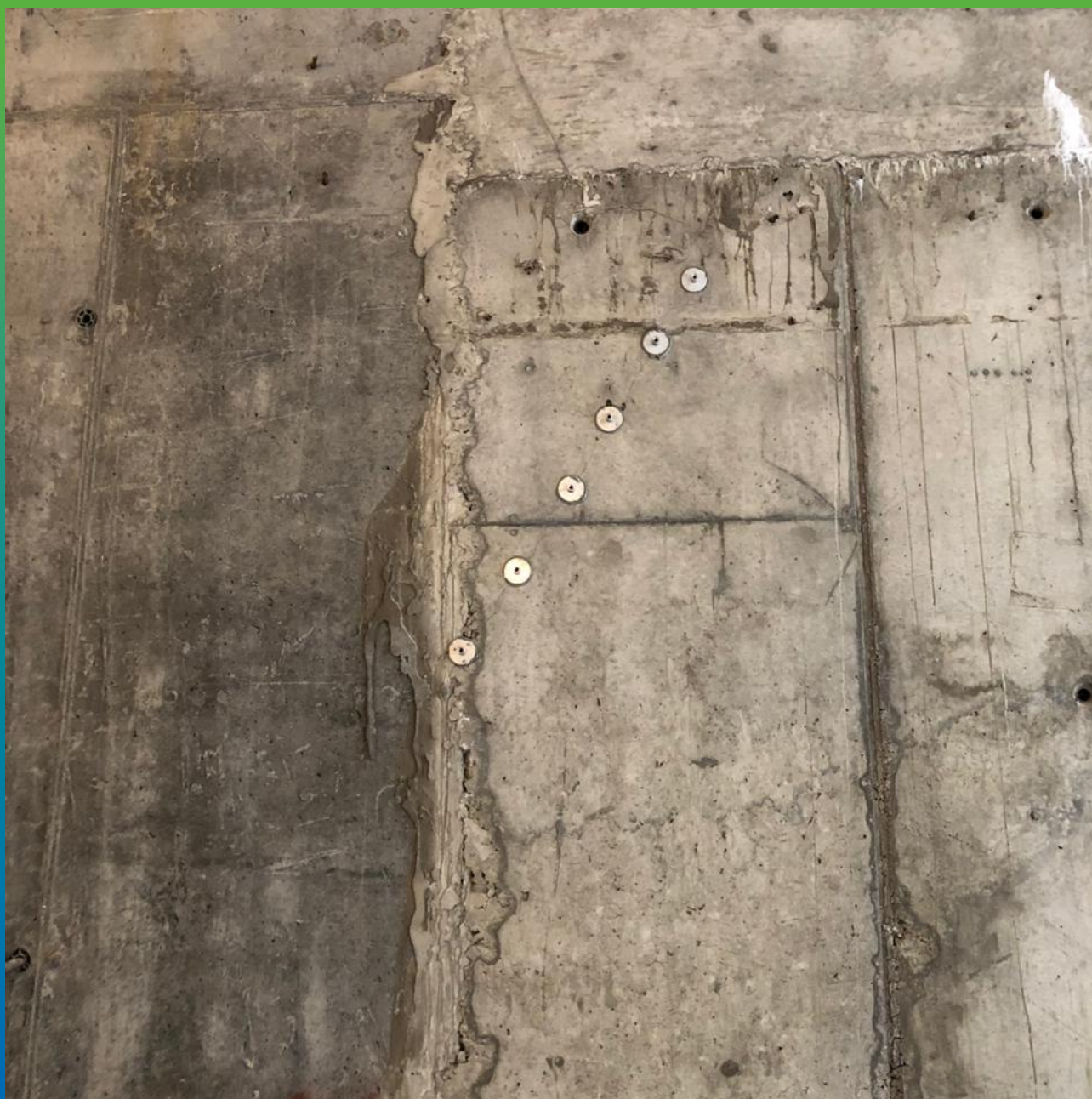
Адгезионные пакеры, монтированные на трещины
