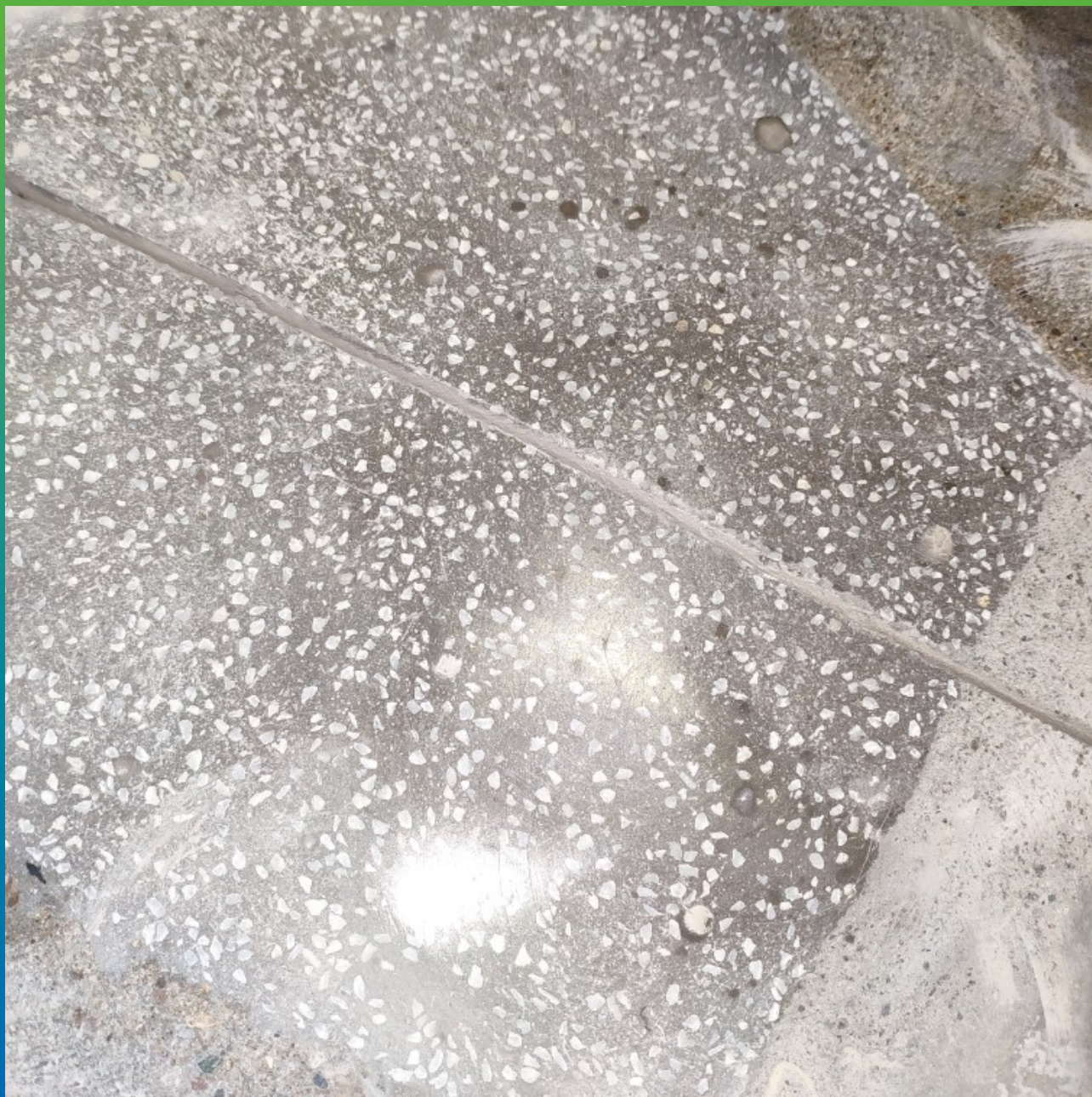
Отремонтированный и отполированный участок пола.
