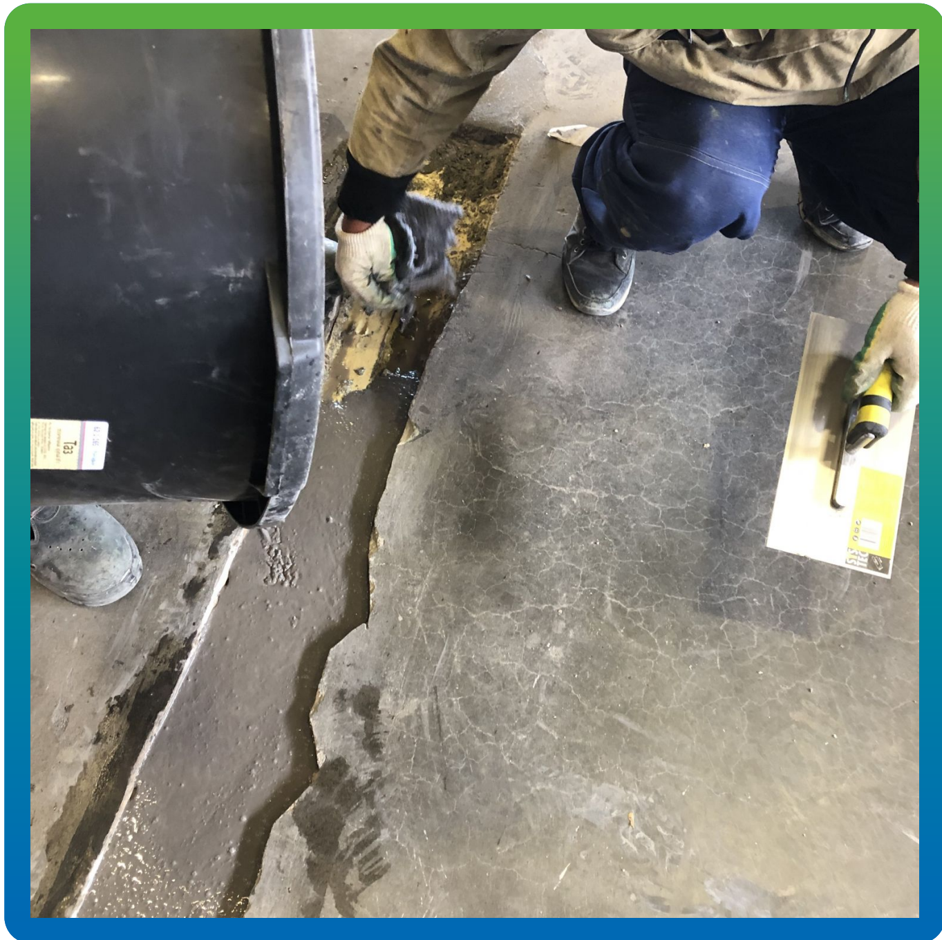
Укладка материала на заранее подготовленную поверхность.
