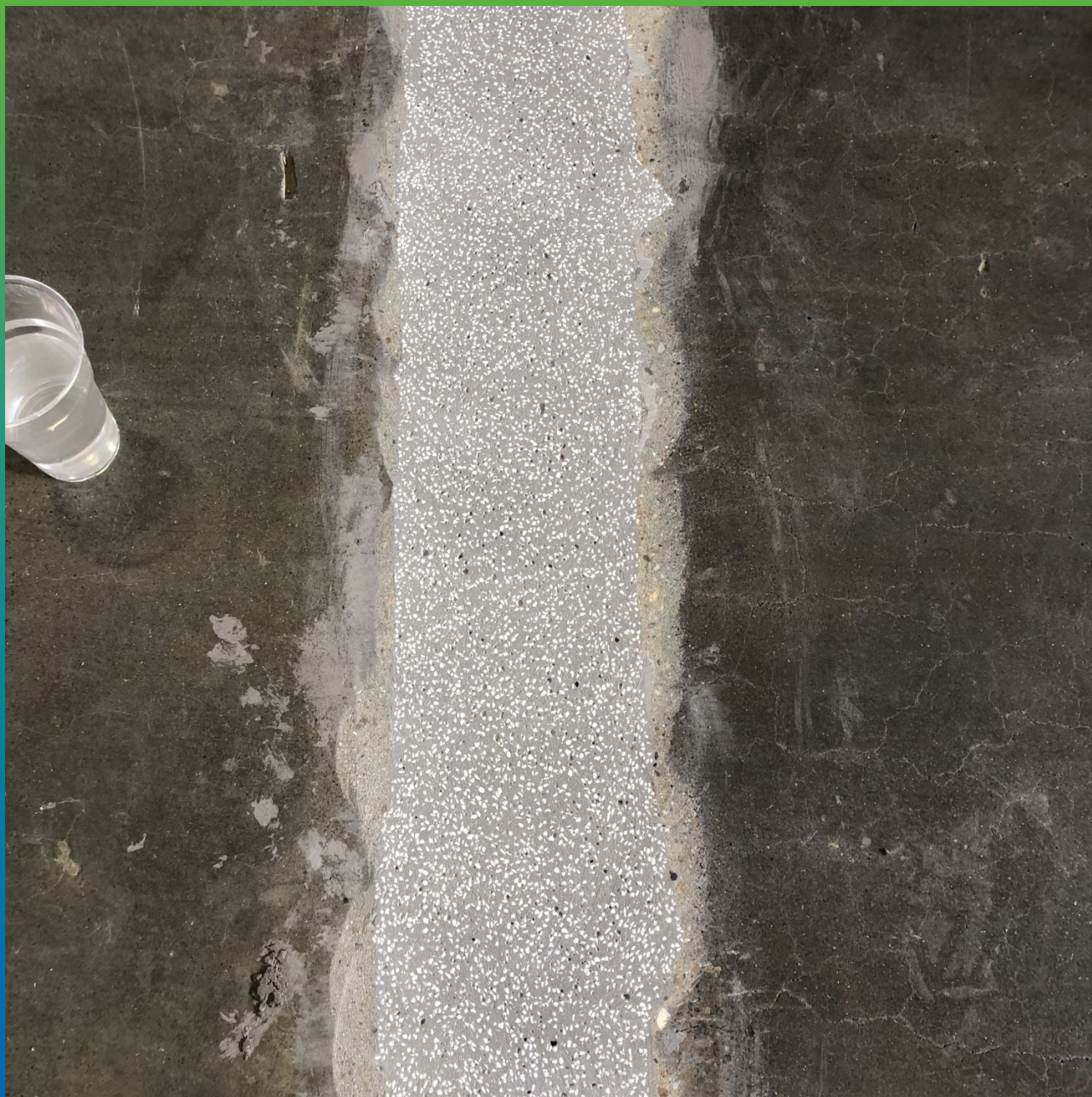
Шлифовка материала, набравшего первоначальную прочность.
