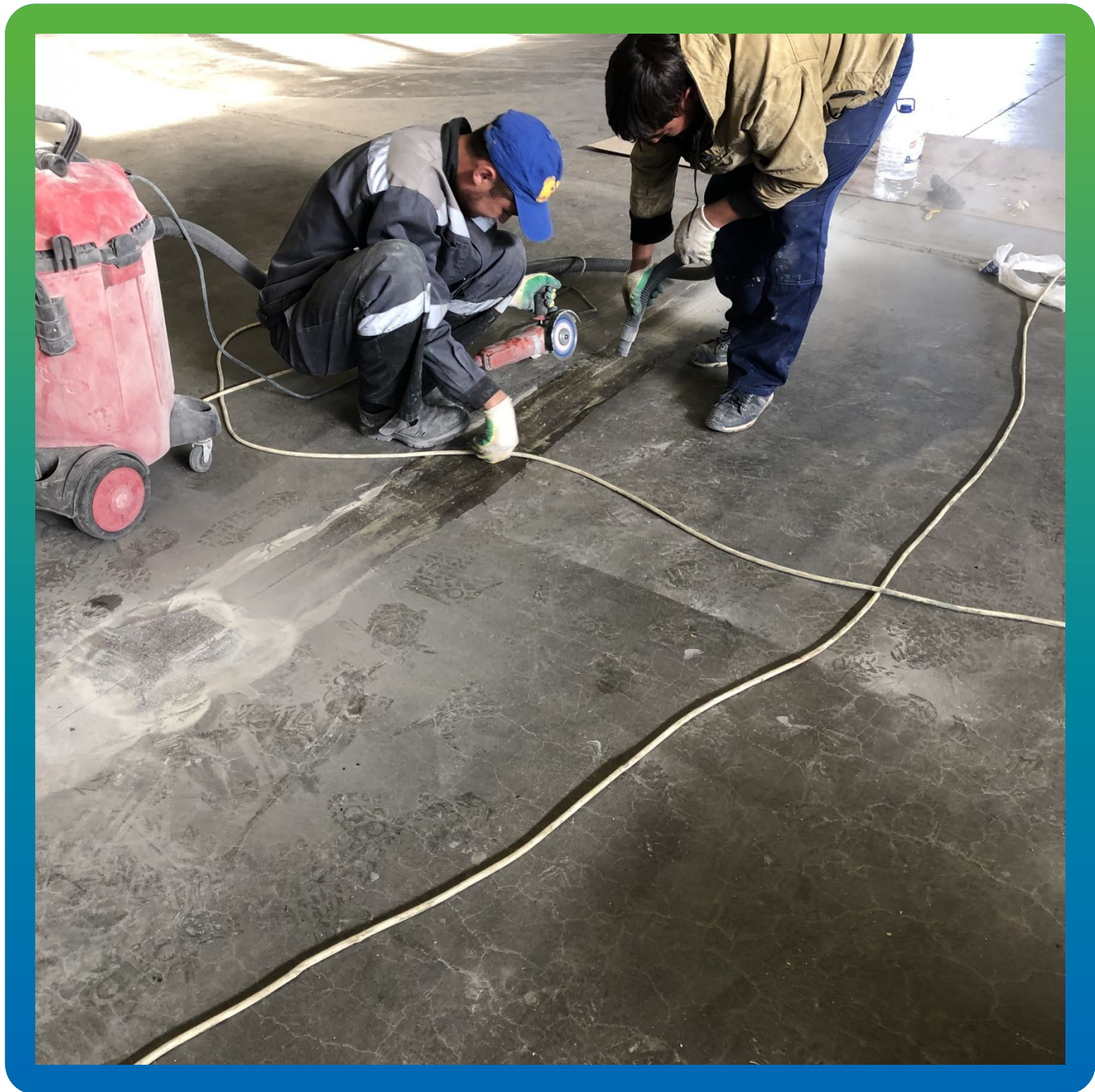
Нарезка компенсационных швов
