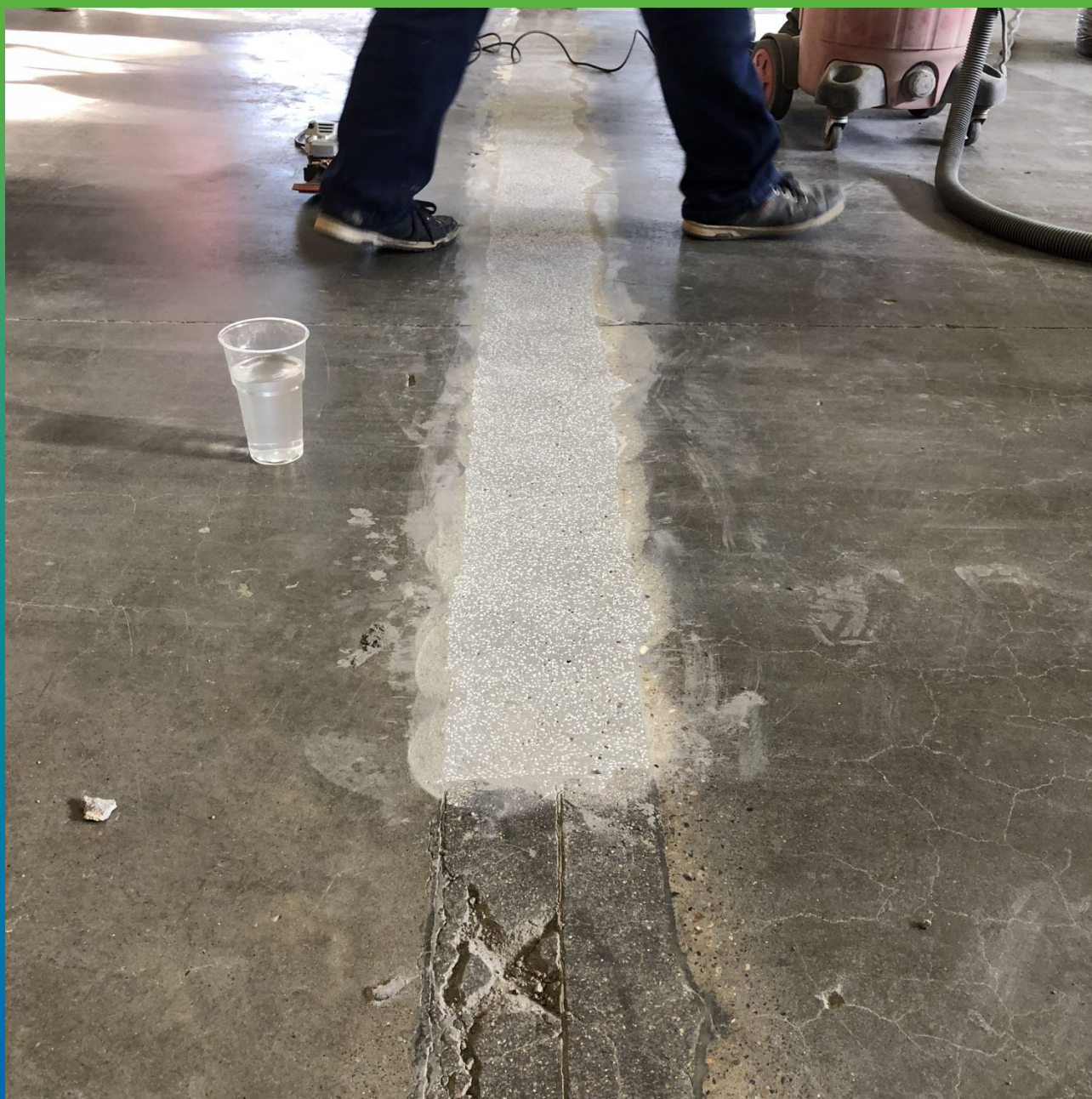
Шлифовка материала, набравшего первоначальную прочность.
