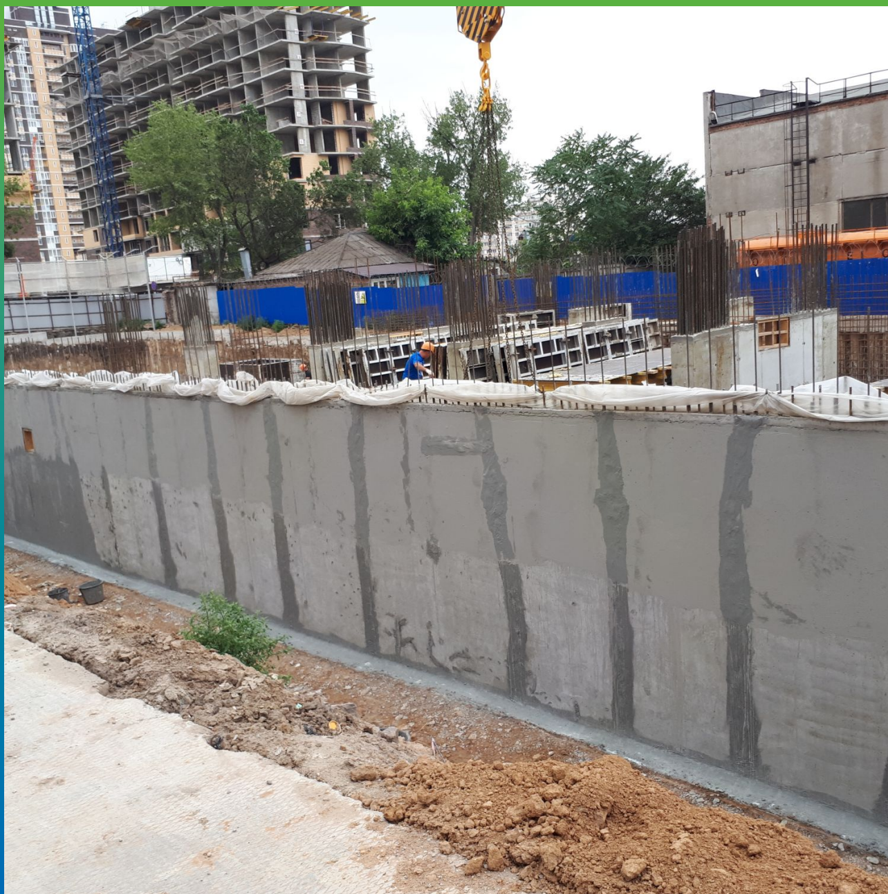
Покрытием стен первым слоем Стармекс Сил
