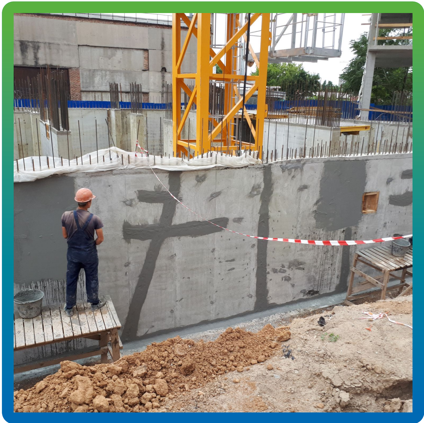
Покрытие вторым слоем Стармекс Сил
