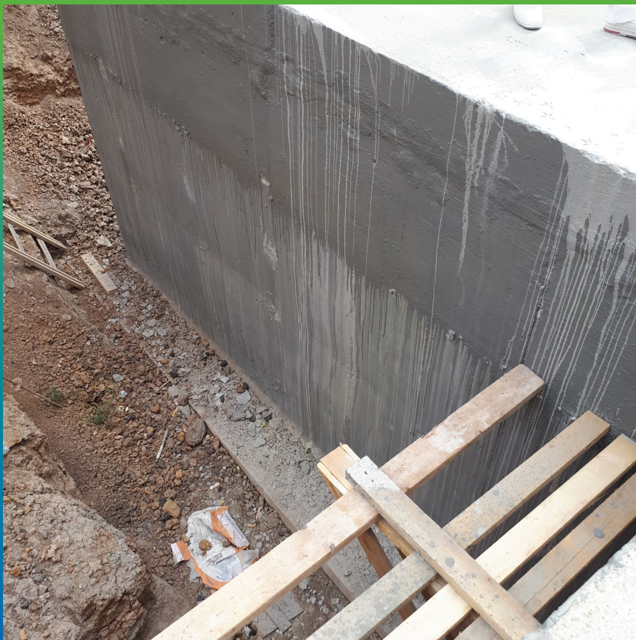
Стены парковки, покрытые Стармекс Сил Флекс
