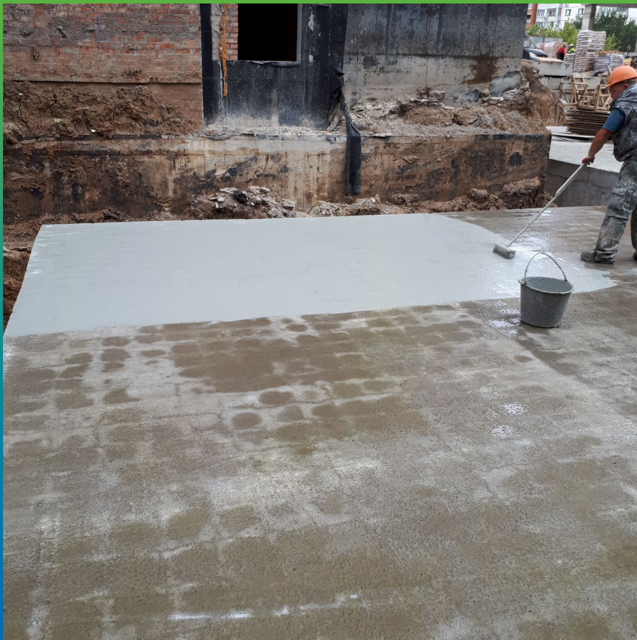
Растягивание Стармекс Сил по поверхности плиты
