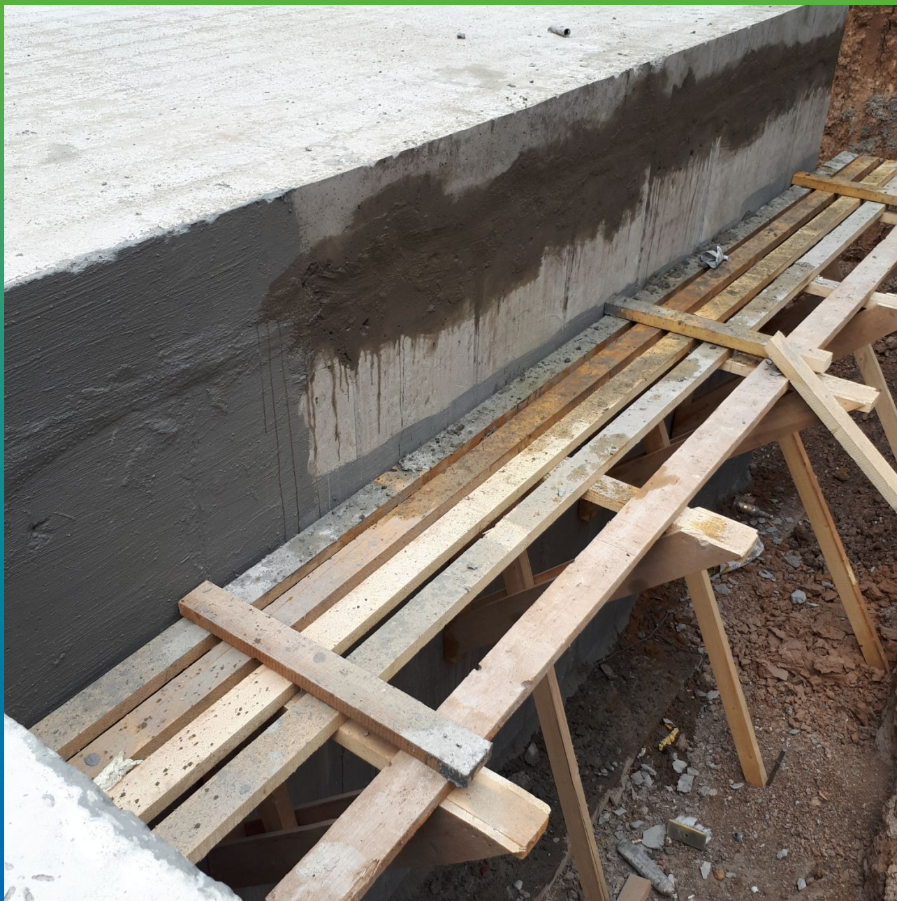
Зачеканенный рем. составом шов
