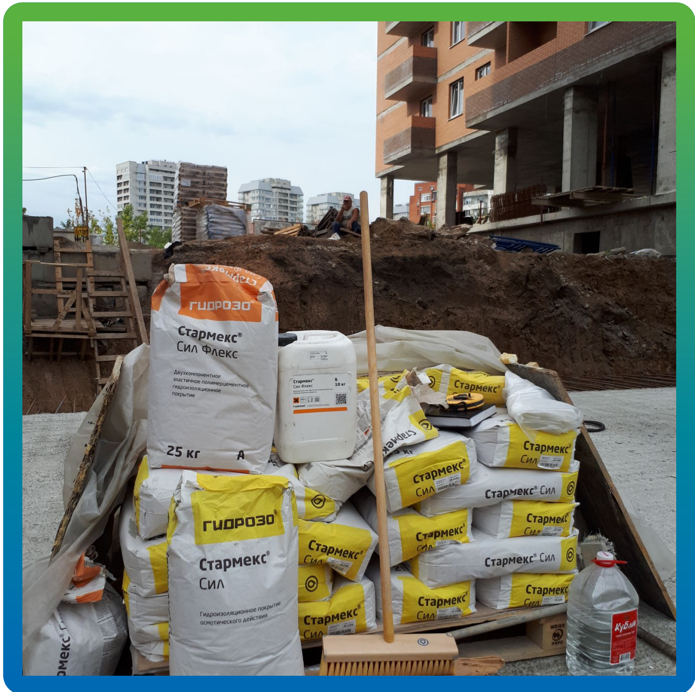
Материалы Гидрозо на объекте
