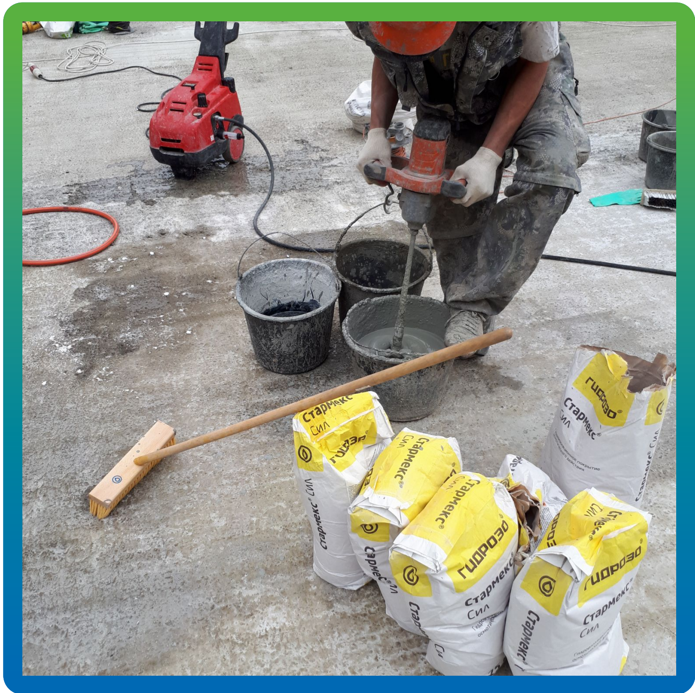
Приготовление гидроизоляционной смеси Стармекс Сил
