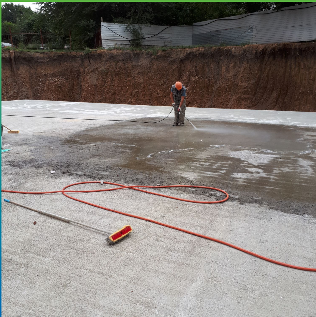
Замывка бетонной поверхности перед нанесением гидроизоляции
