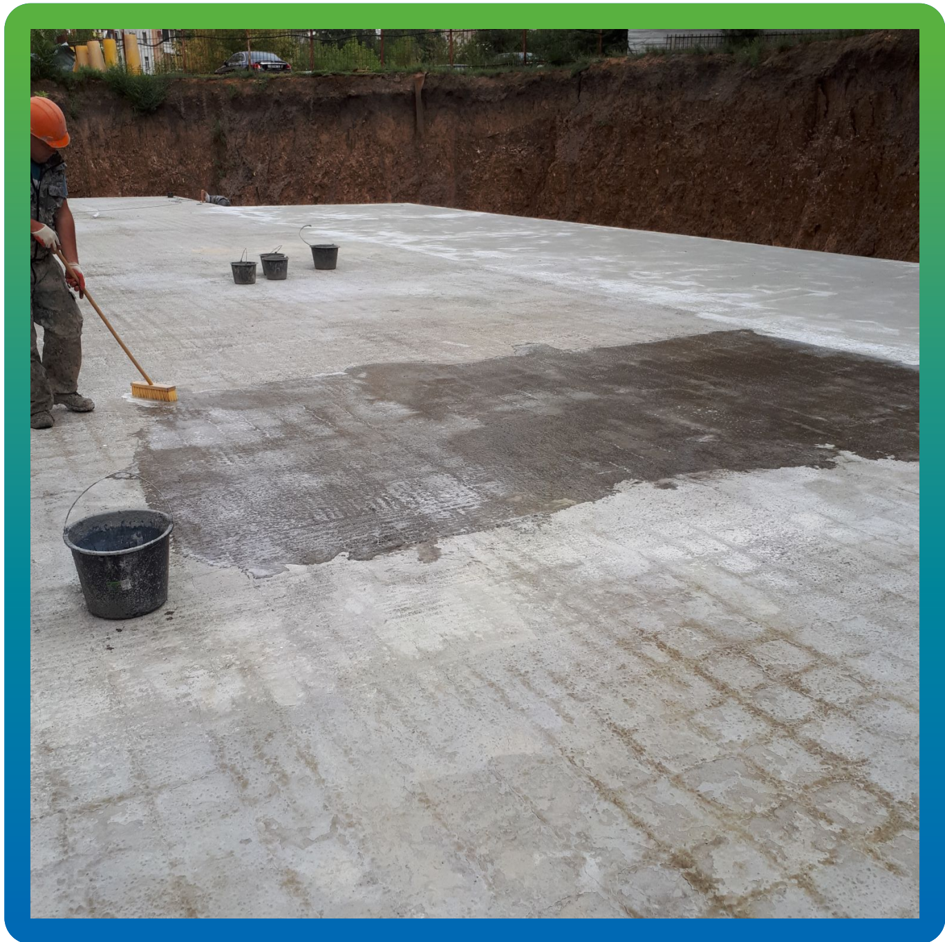
Удаление бетонного молочка методом хим. фрезерования
