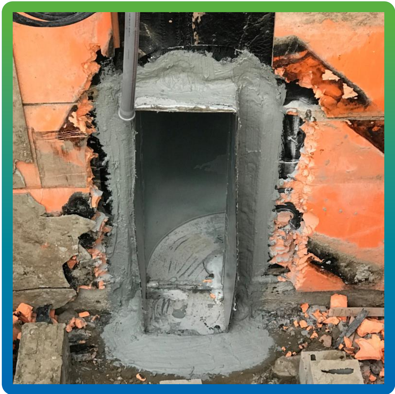
Нанесенная гидроизоляция Стармекс Сил Флекс
