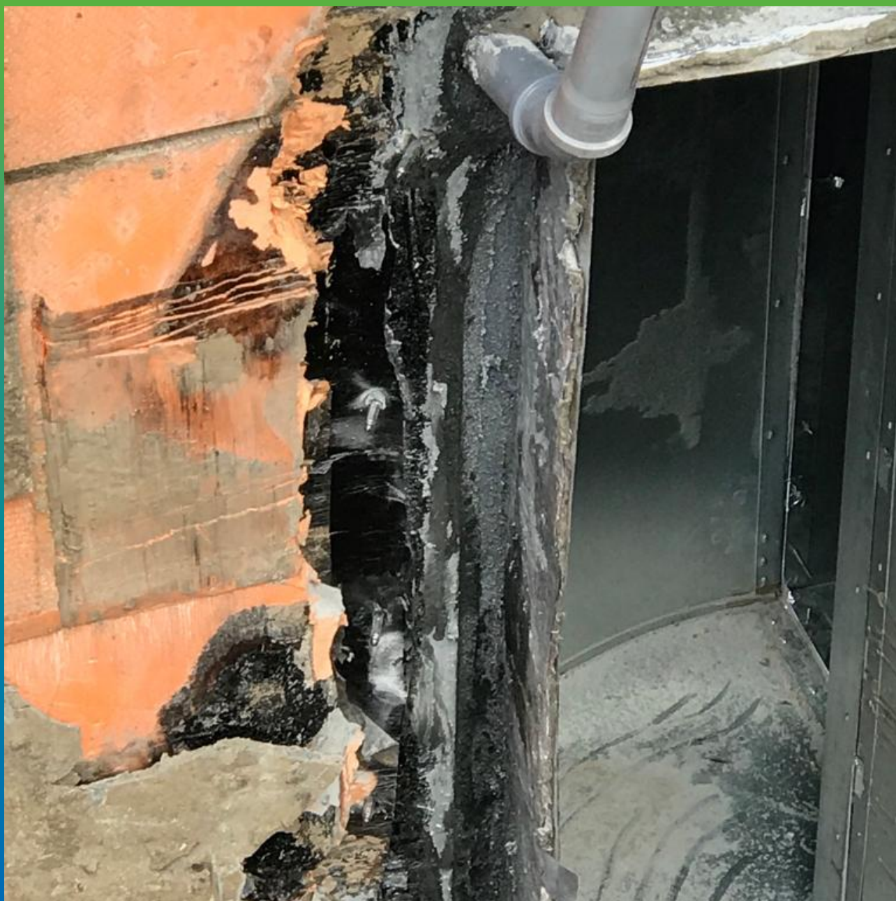
Подготовленная поверхность для нанесения гидроизоляции
