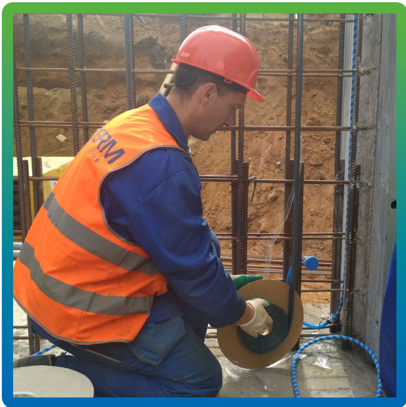
Монтаж профиля Манодил Свелл
