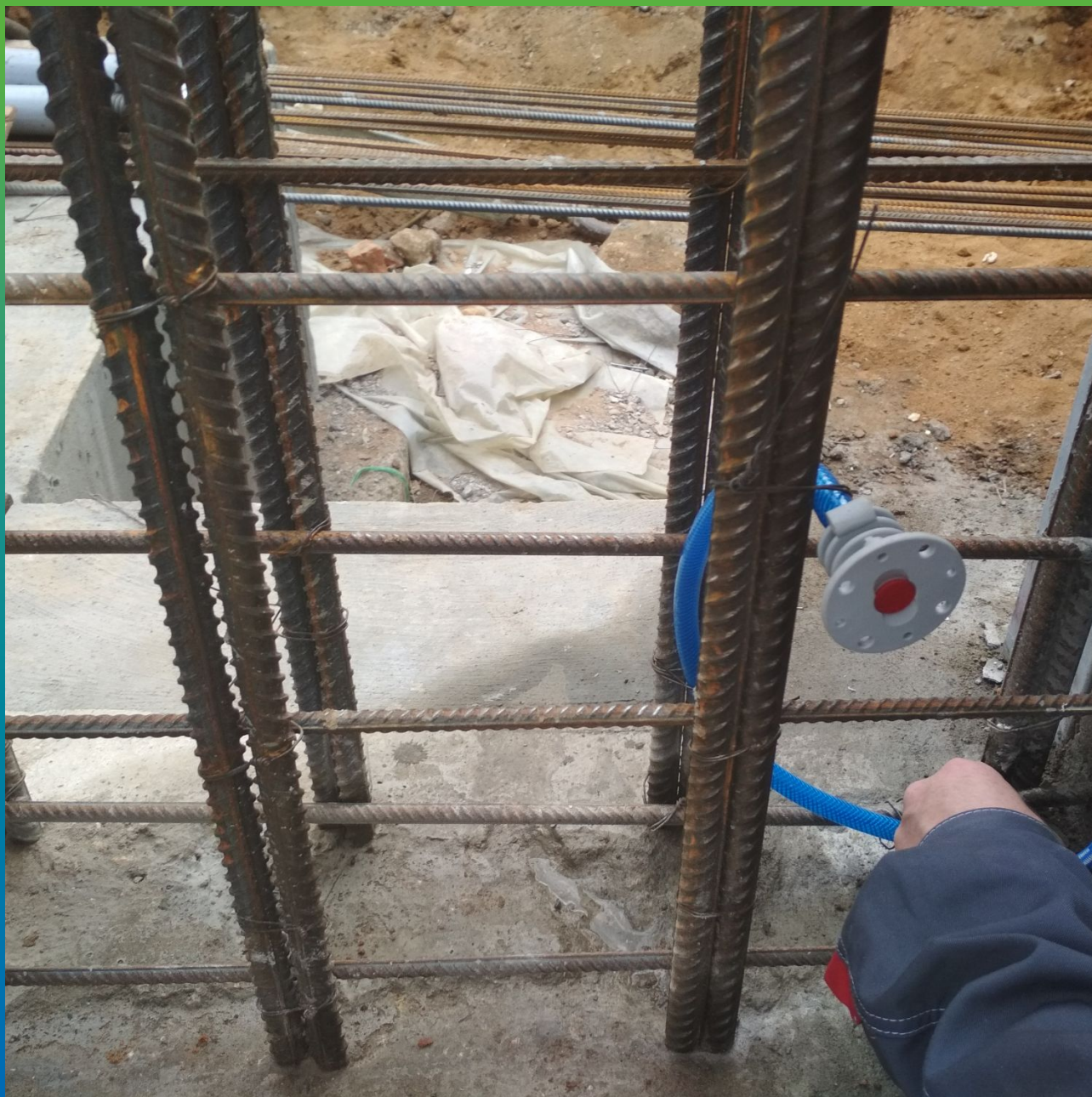
Монтаж системы Инжпайп
