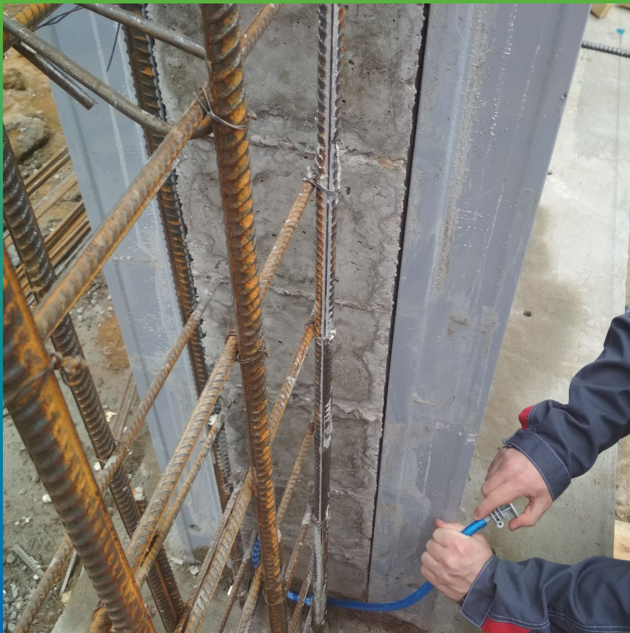
Монтаж системы Инжпайп
