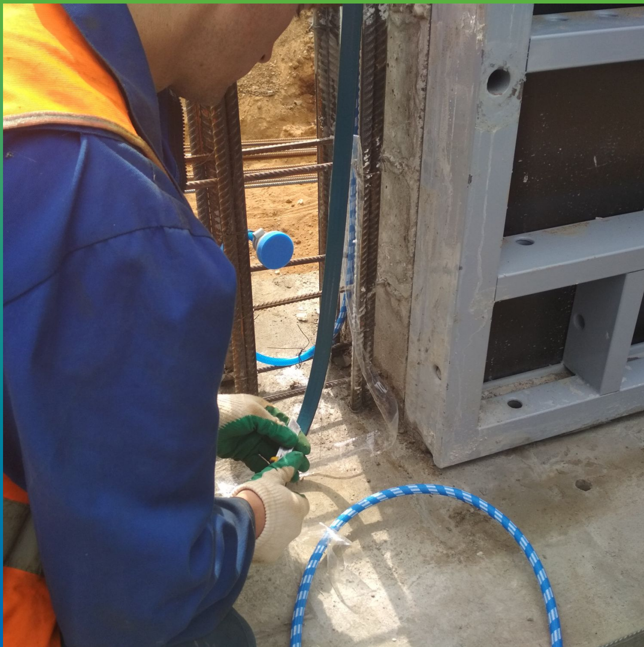
Монтаж профиля Манодил Свелл
