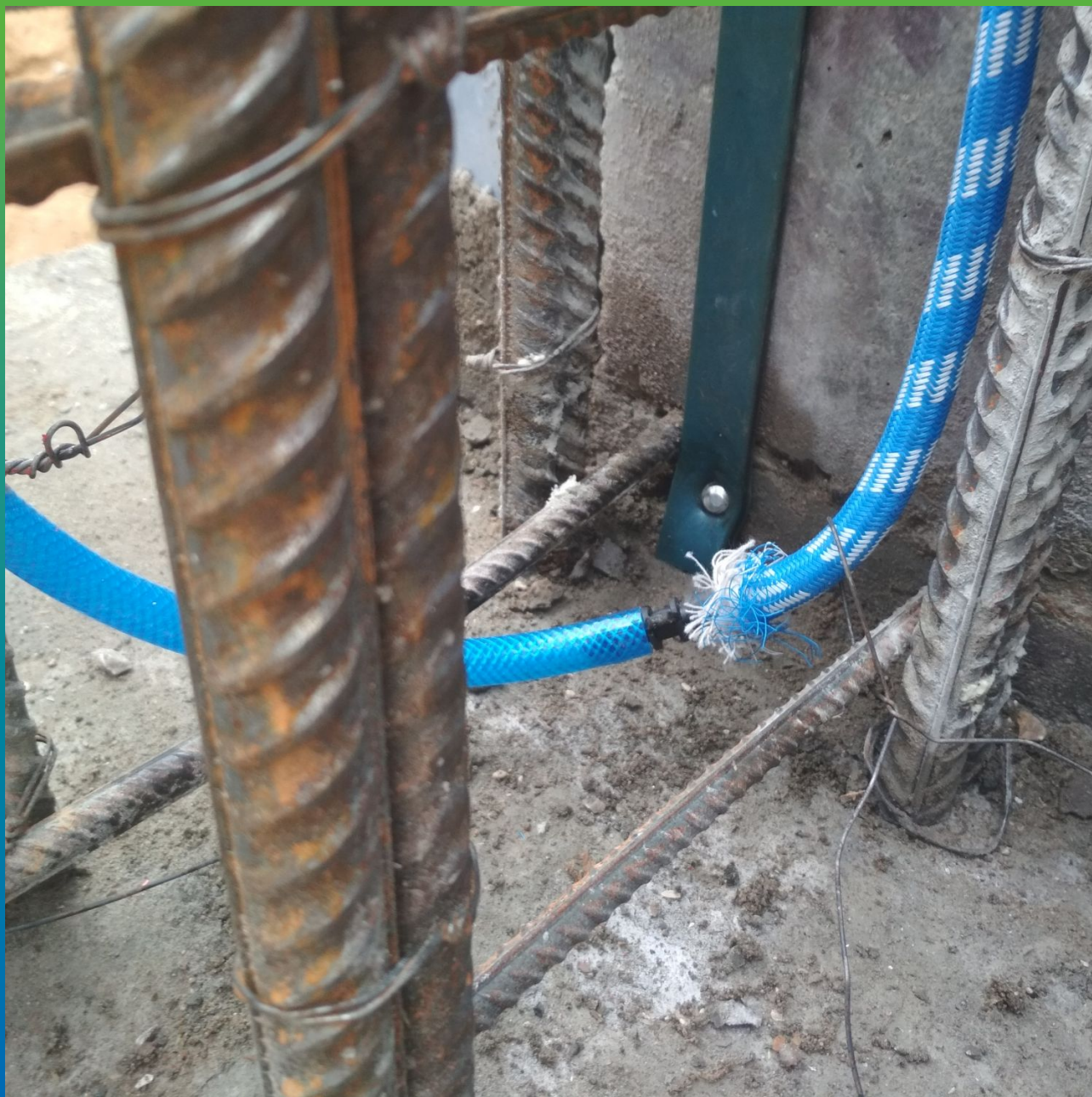
Монтаж системы Инжпайп
