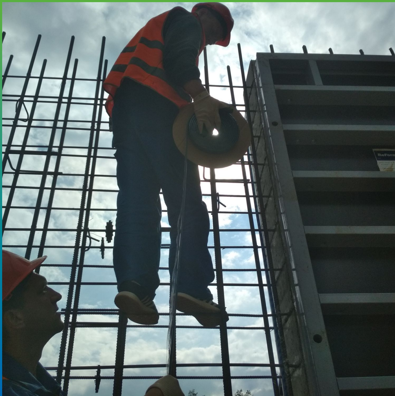
Монтаж профиля Манодил Свелл
