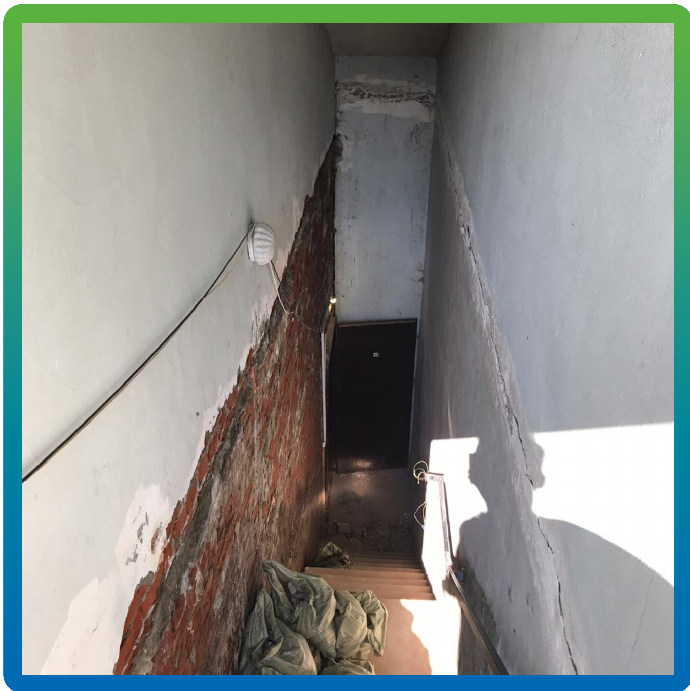
Подготовка основания для оштукатуривания ремонтным составом Стармекс РМЗ
