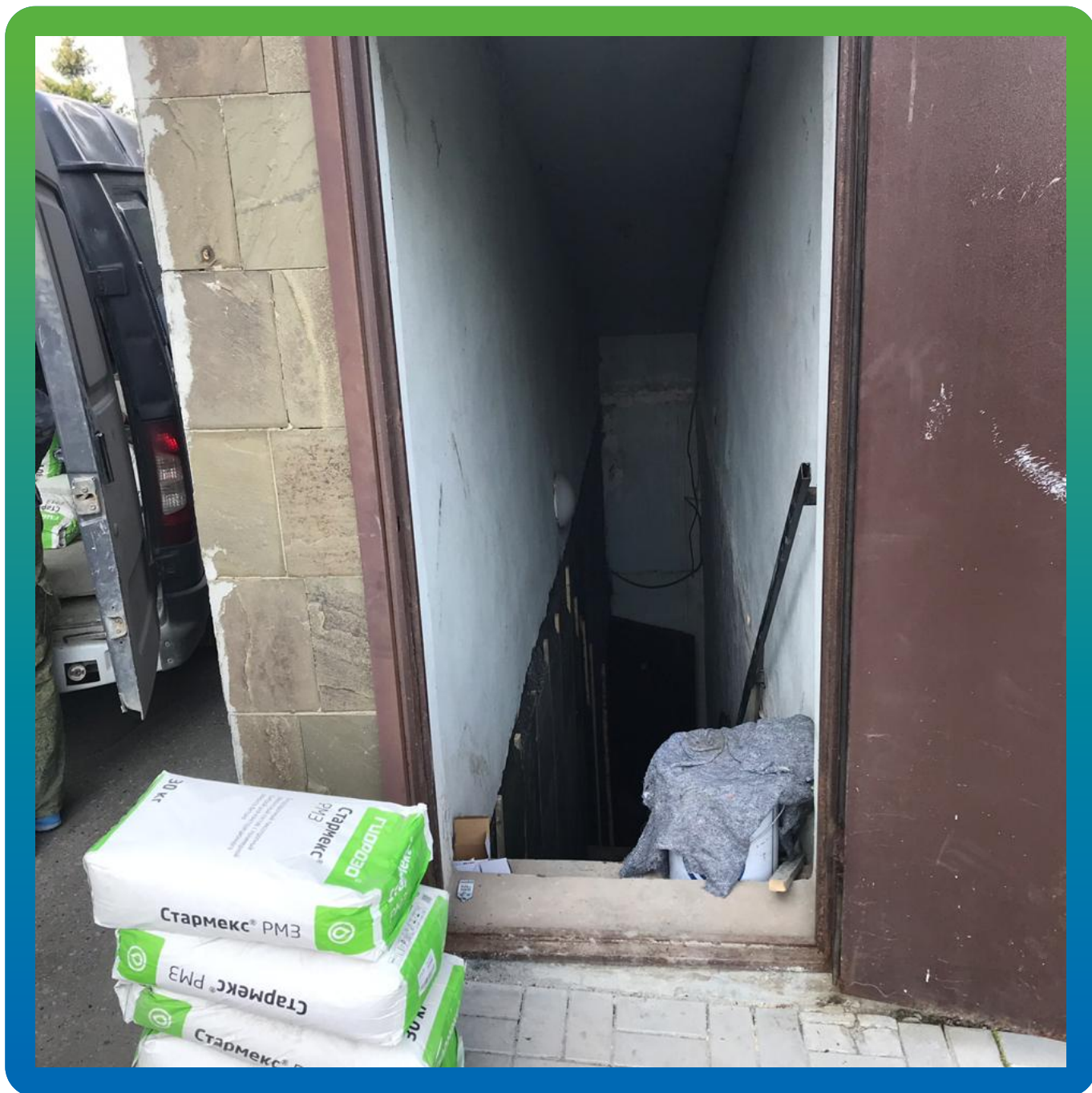
Оштукатуривание ремонтным составом Стармекс РМЗ
