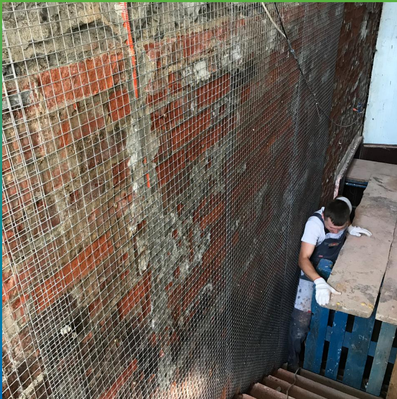
Монтаж штукатурной сетки перед нанесением ремонтного состава
