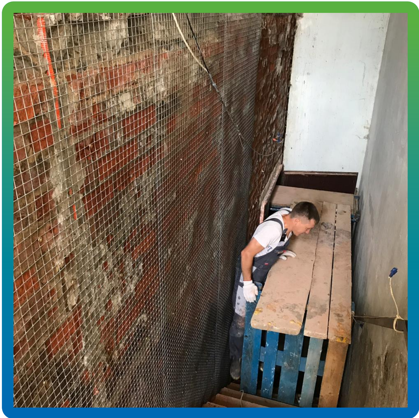
Монтаж штукатурной сетки перед нанесением ремонтного состава
