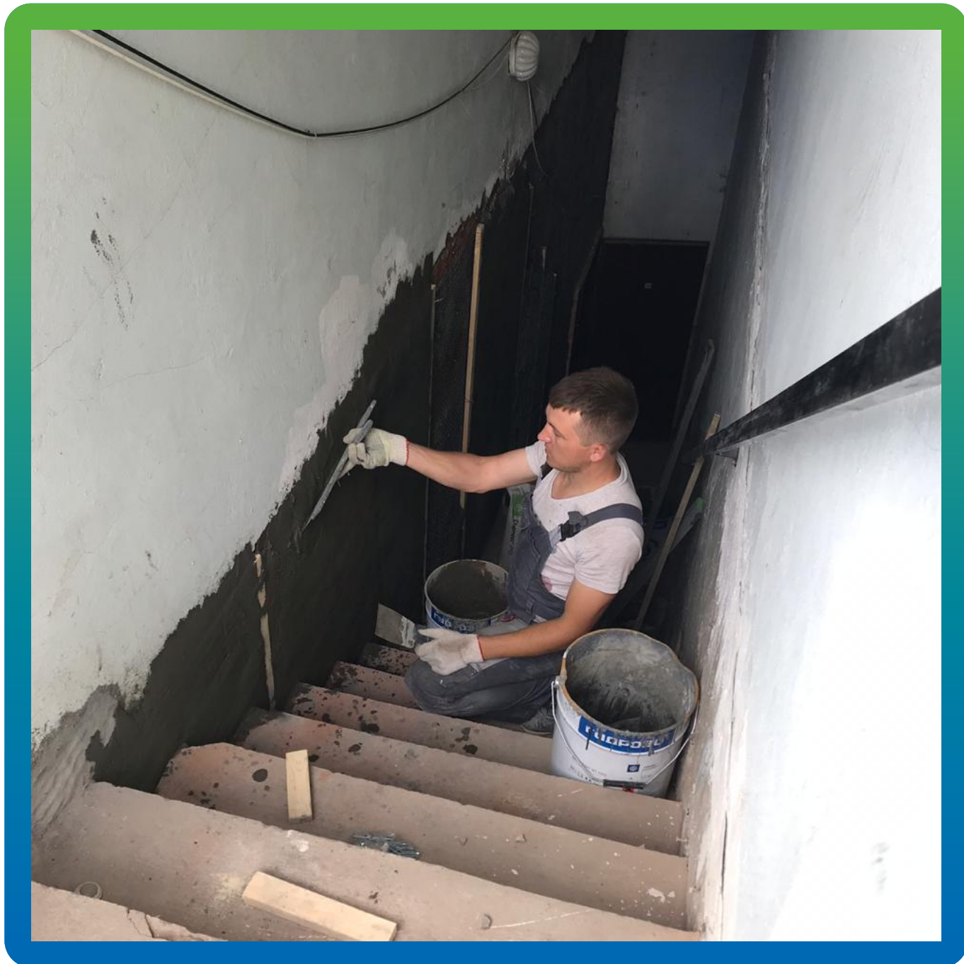
Оштукатуривание ремонтным составом Стармекс РМЗ
