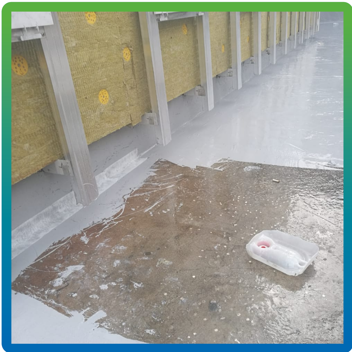
Гидроизоляция примыканий
