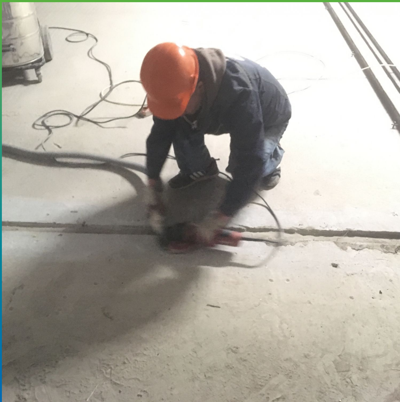
Подготовка поверхности шва - шлифовка
