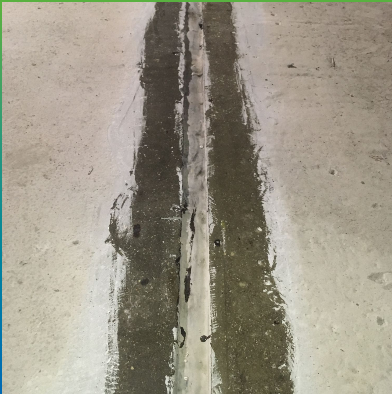
Вид нанесенного грунтовочного состава - Денстоп ЭП 106
