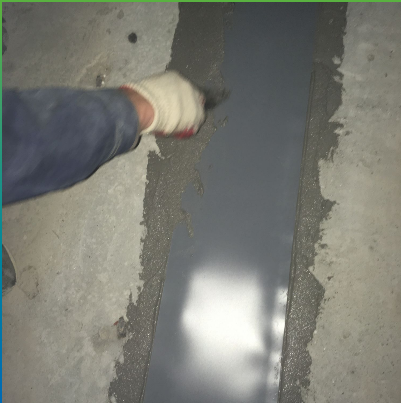
Монтаж ленты Манодил Про на Манопокс 331
