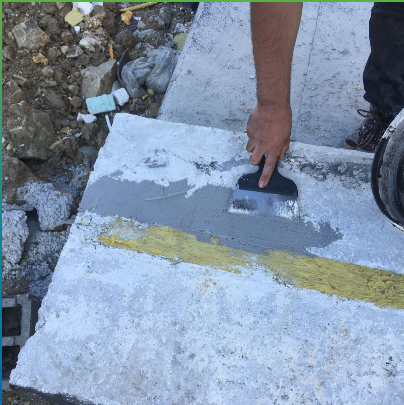
Нанесение Манопокс 331
