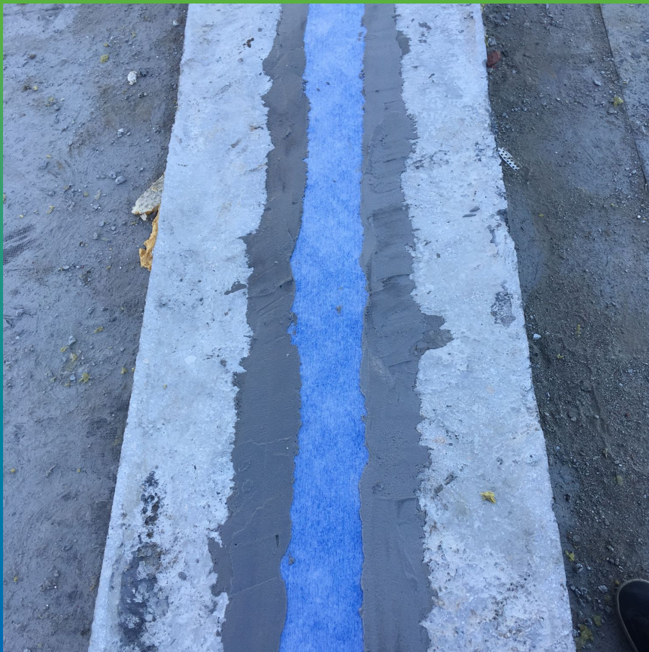
Вид смонтированной ленты Манодил Гео на Манопокс 331
