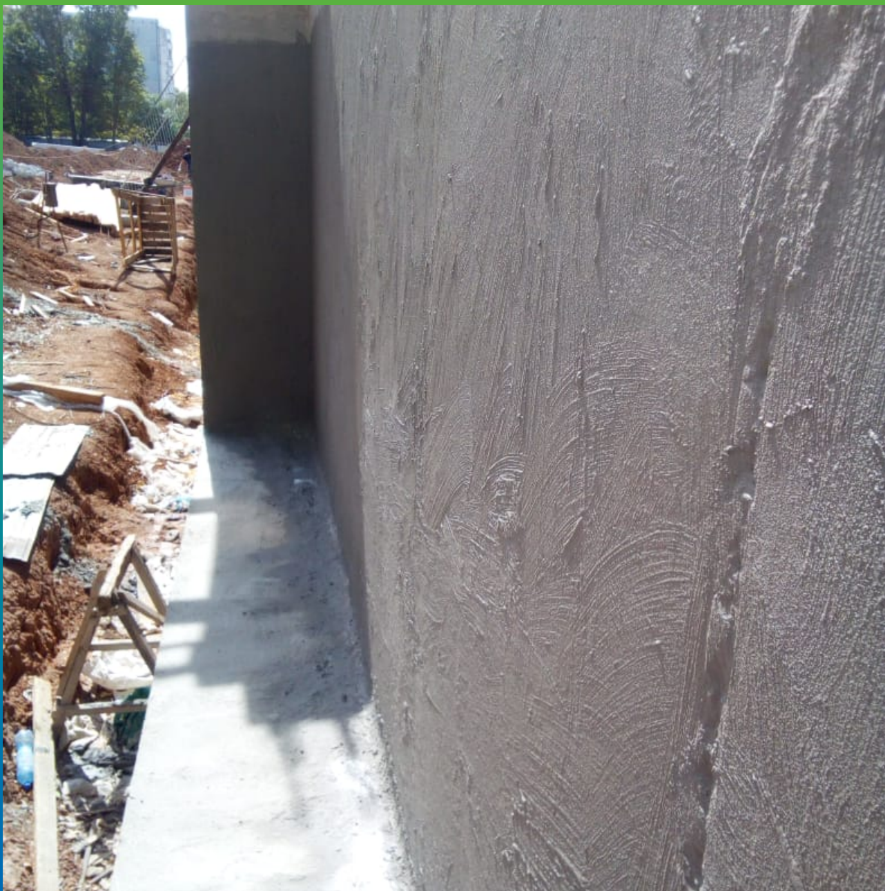
Выполненная гидроизоляция стены и примыкания составом Стармекс Сил Флекс
