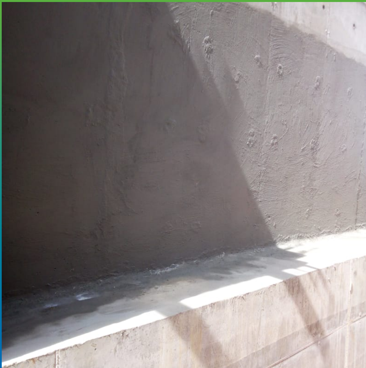
Стена, покрытая эластичной гидроизоляцией Стармекс Сил Флекс
