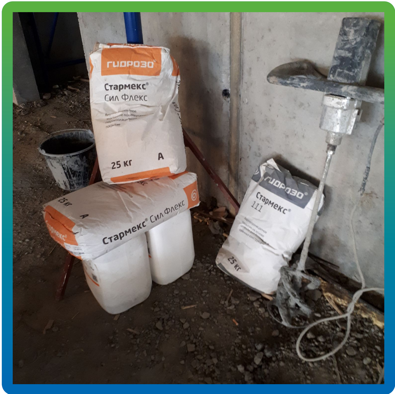
Материалы Гидрозо на объекте
