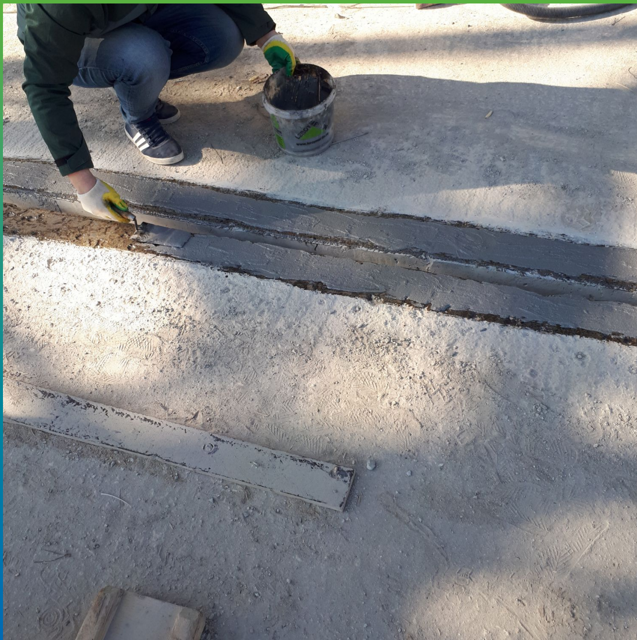
Нанесение клея Манопокс 331 перед приклейкой ленты Манодил Про
