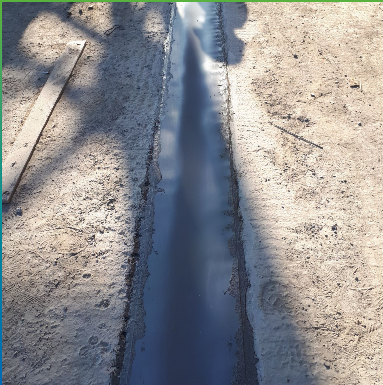
Выполненный деф. шов
