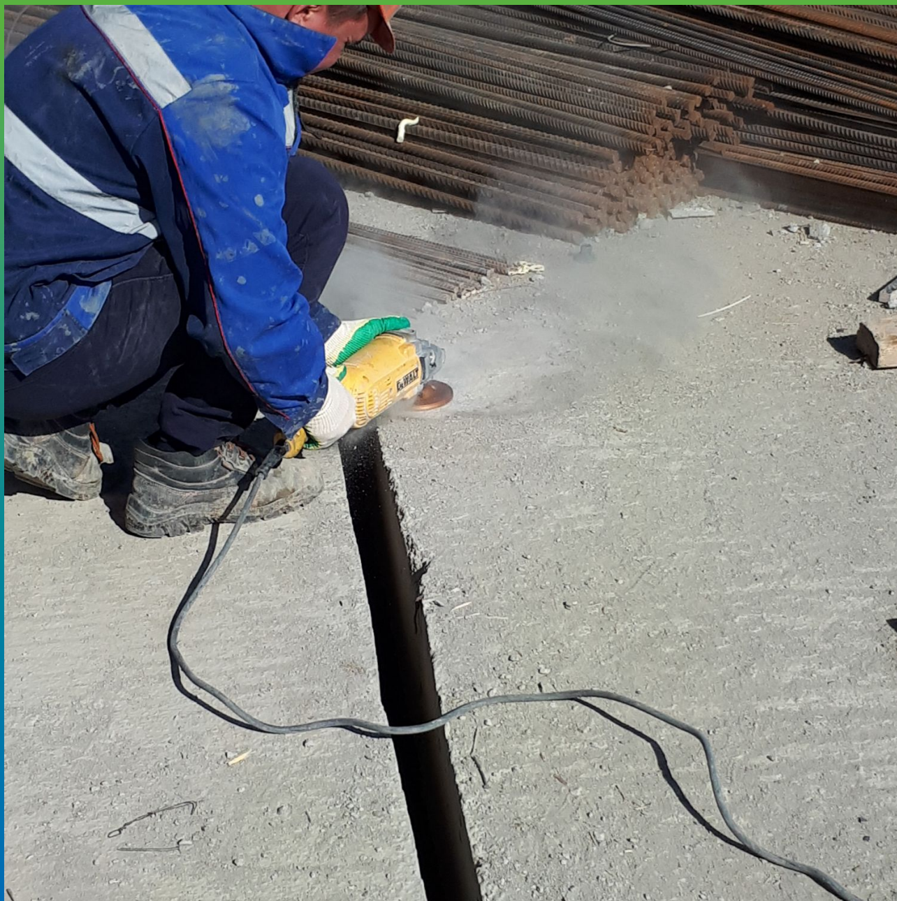
Шлифовка бетона перед нанесением ленты
