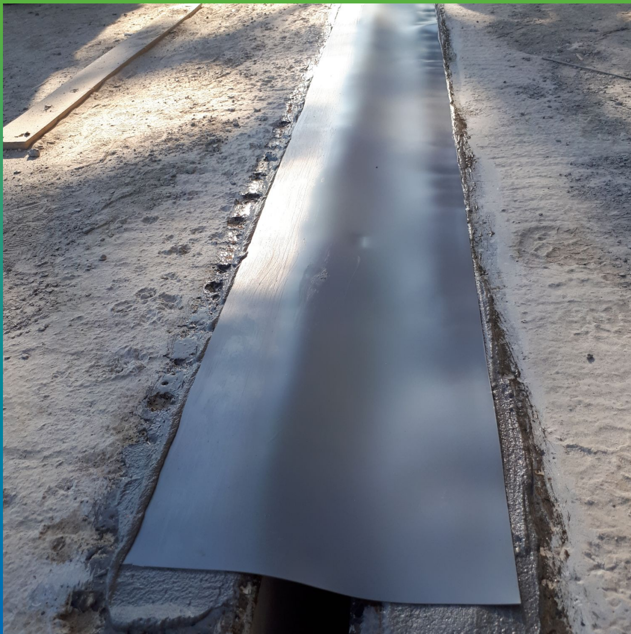
Нанесение ленты Манодил Про на деф. шве по клею Манопокс 331
