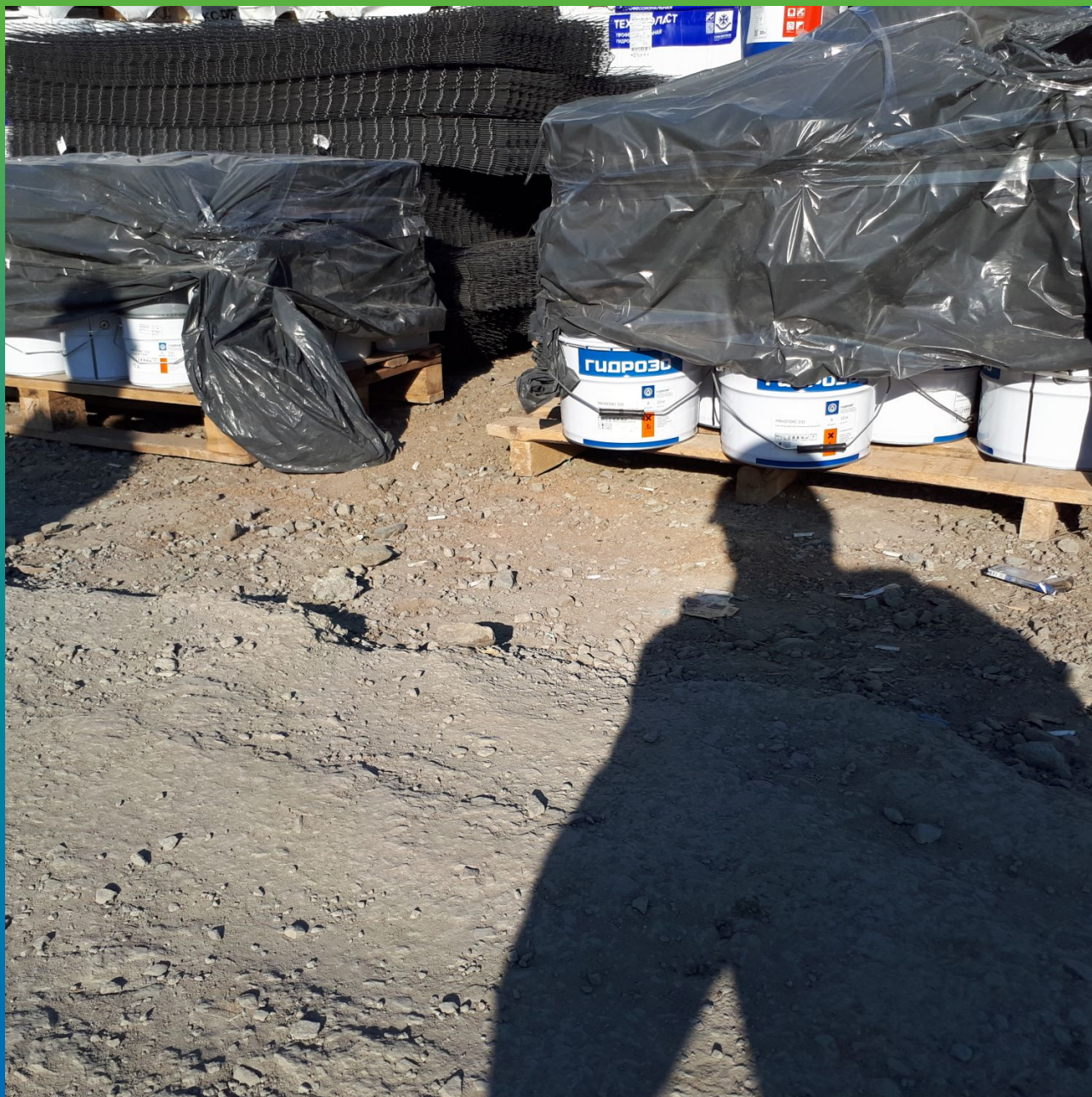
Материалы Гидрозо на объекте
