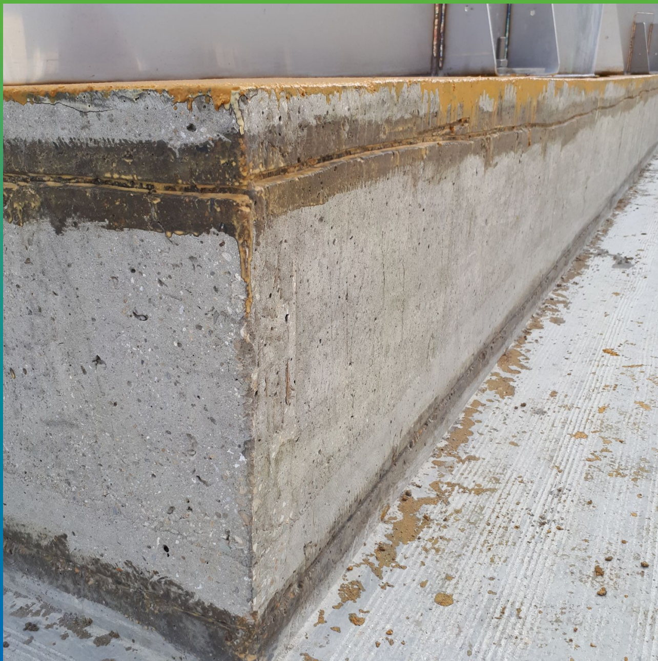
Выполненные и грунтованные анкерные пропилы
