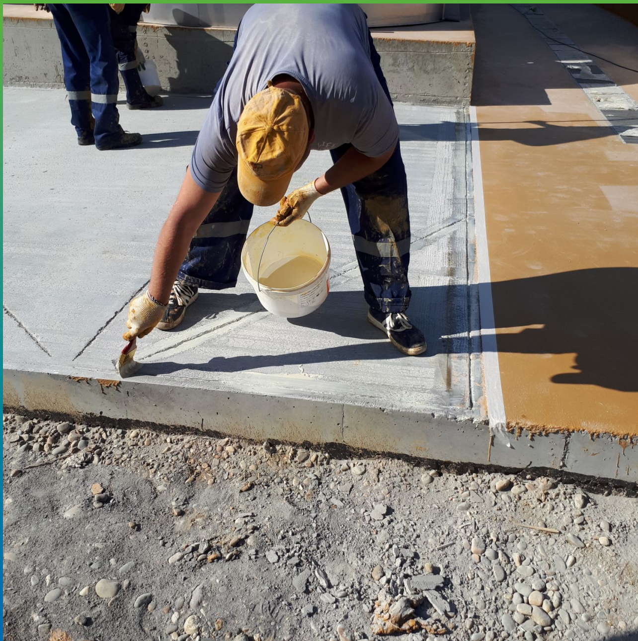
Грунтование штроб составом ДенсТоп ПМ 600
