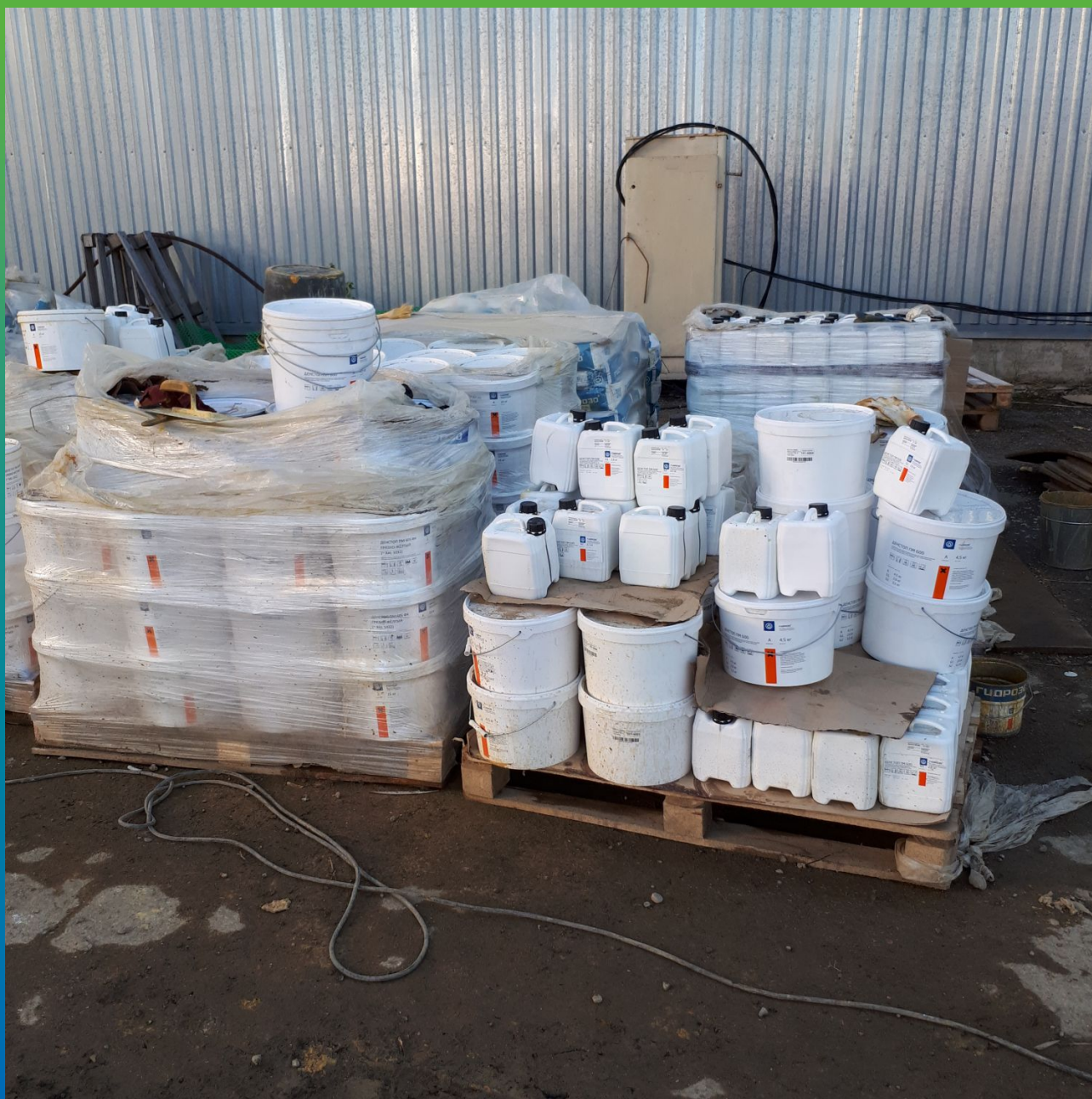
Материалы Гидрозо на объекте
