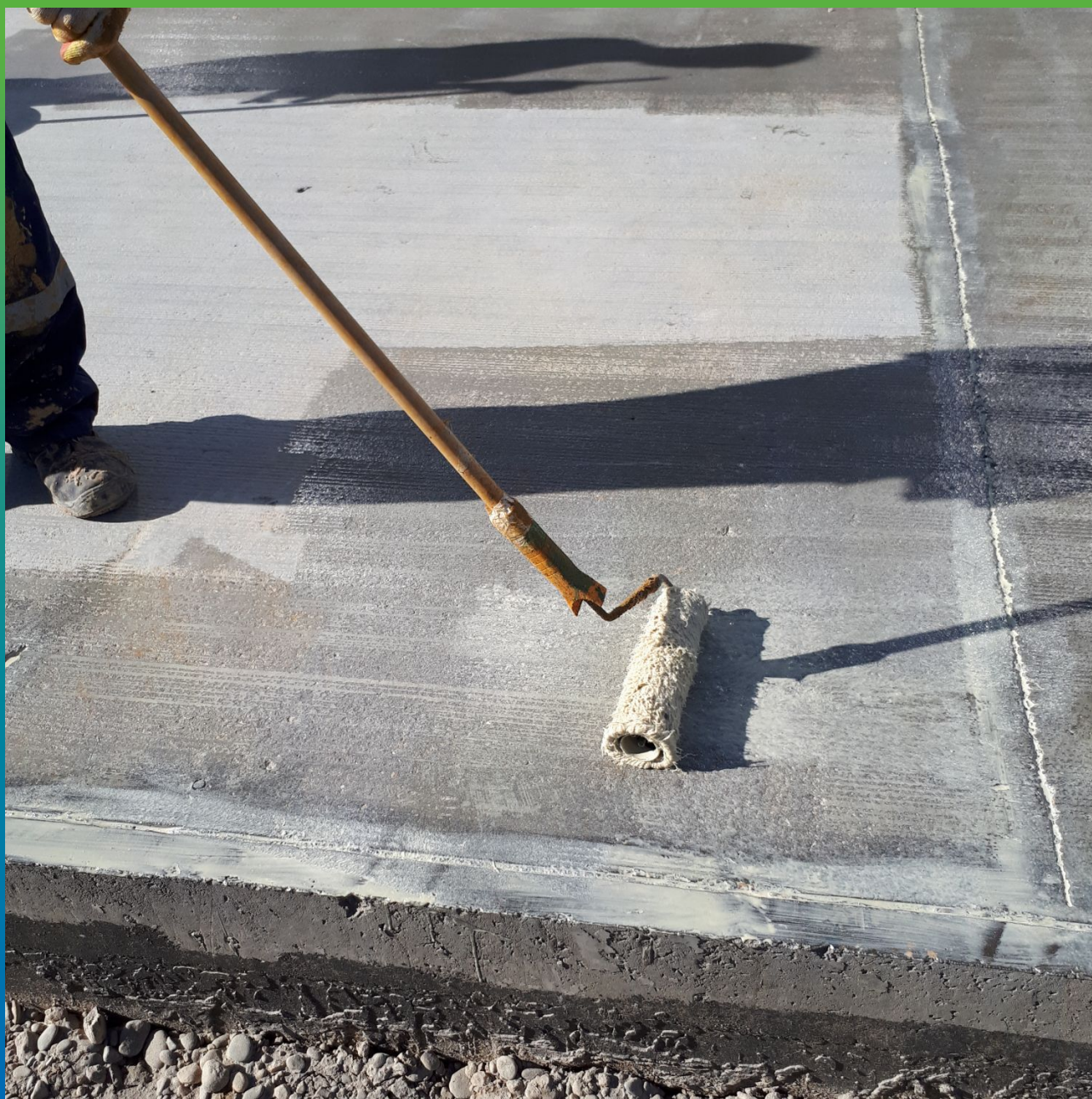
Грунтование горизонтальной поверхности ДенТоп ПМ 600
