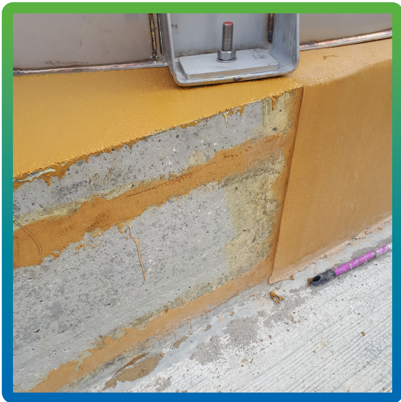
Заполнение анкерных штроб на вертикальной поверхности составом ДенсТоп ПМ 605 ФК
