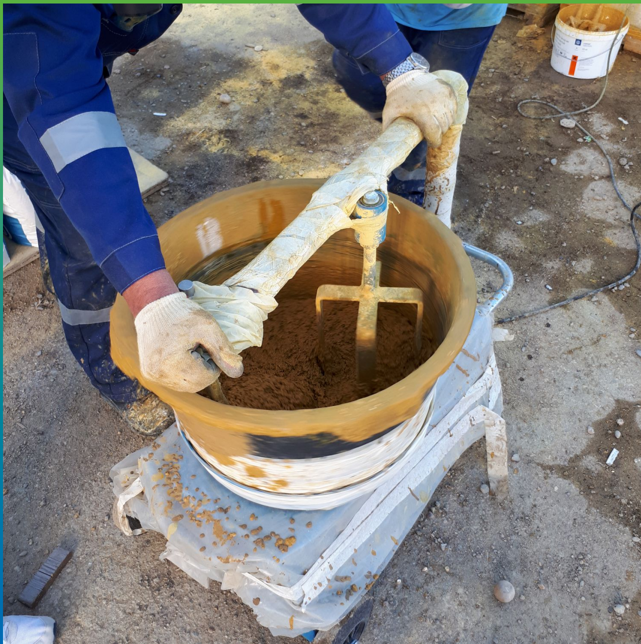
Приготовление состава ДенТоп ПМ 605 Тровел при помощи Refina
