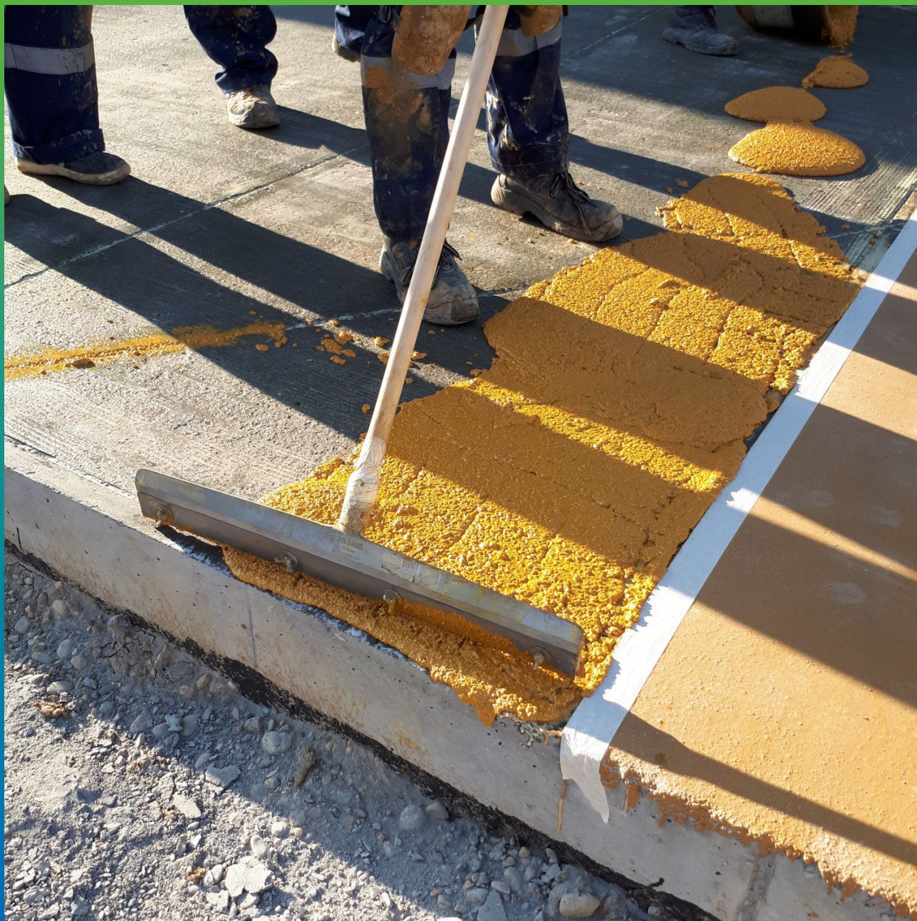
Растягивание ракелью материала ДенТоп ПМ 605 Тровел
