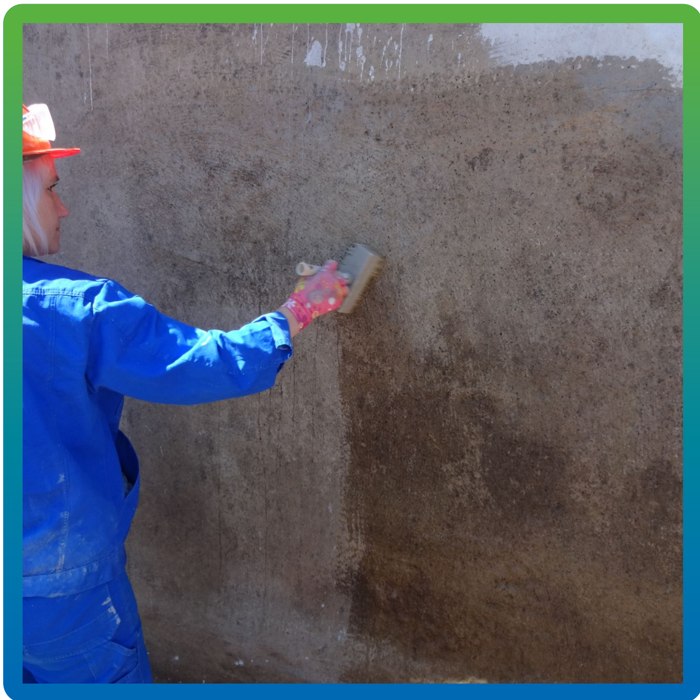
Увлажнение поверхности перед нанесением Стармекс Сил Флекс
