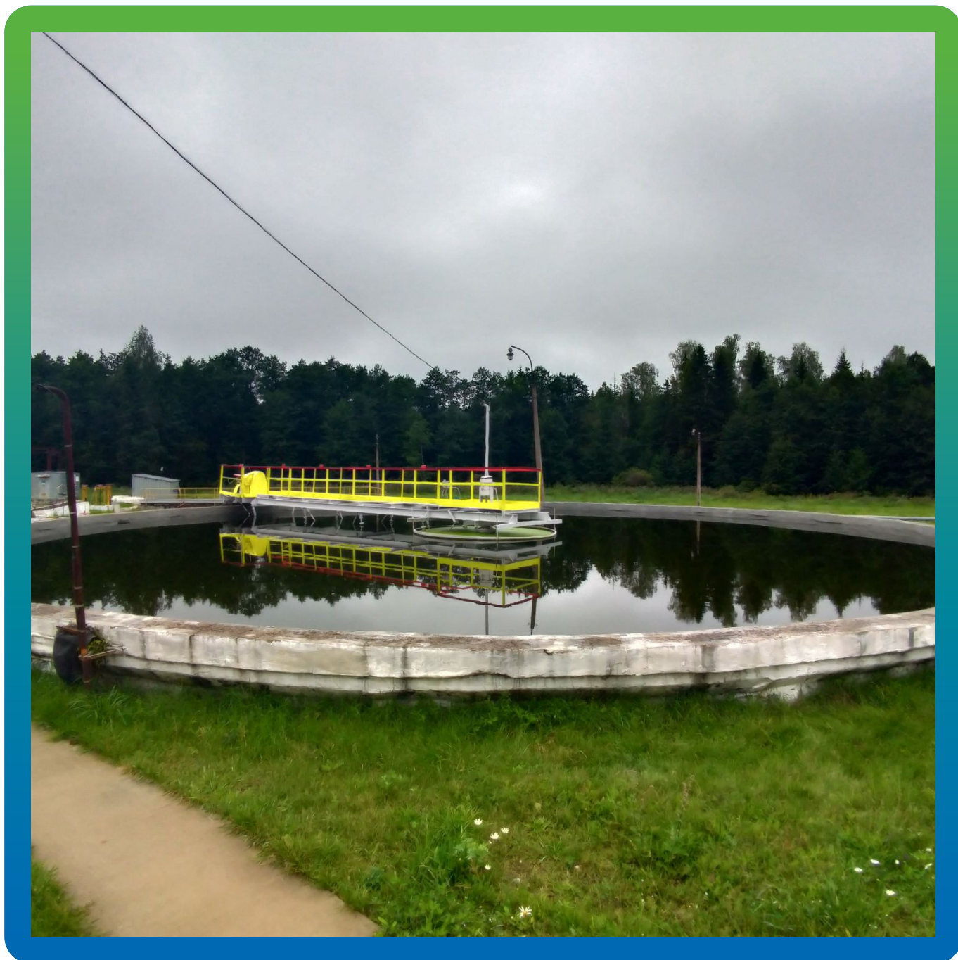
Вид объекта после ввода в эксплуатацию
