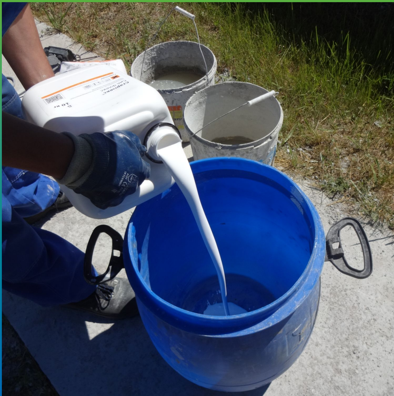
Затворение сухой и жидкой части Стармекс Сил Флекс
