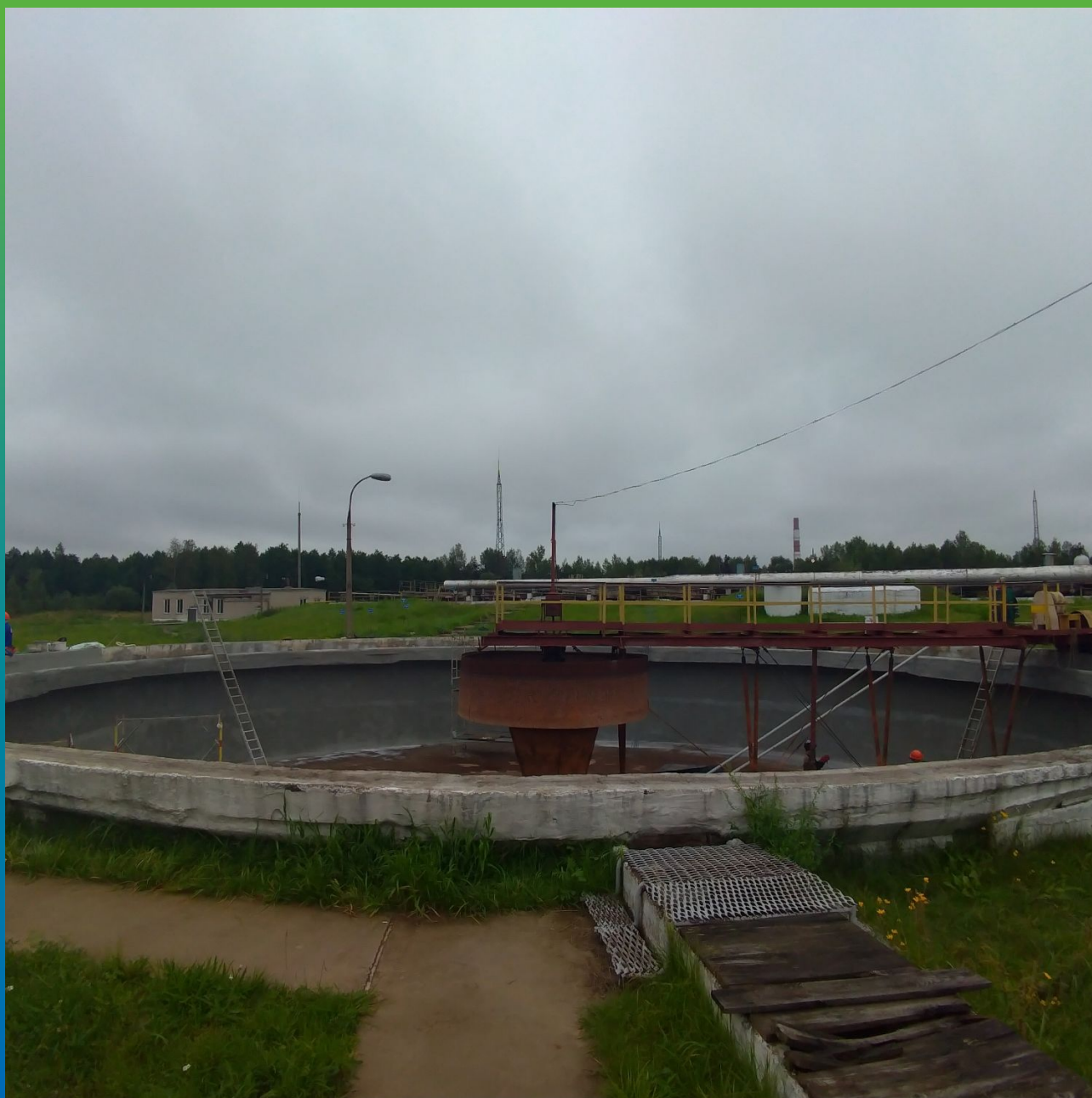
Вид объекта после проведения работ по гидроизоляции
