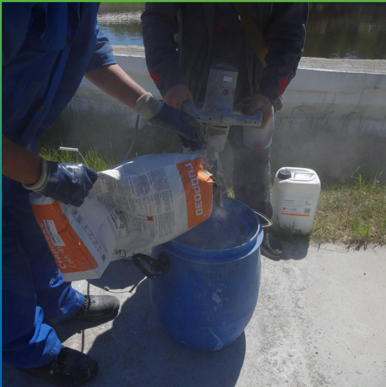
Перемешивание А+Б компонентов Стармекс Сил Флекс
