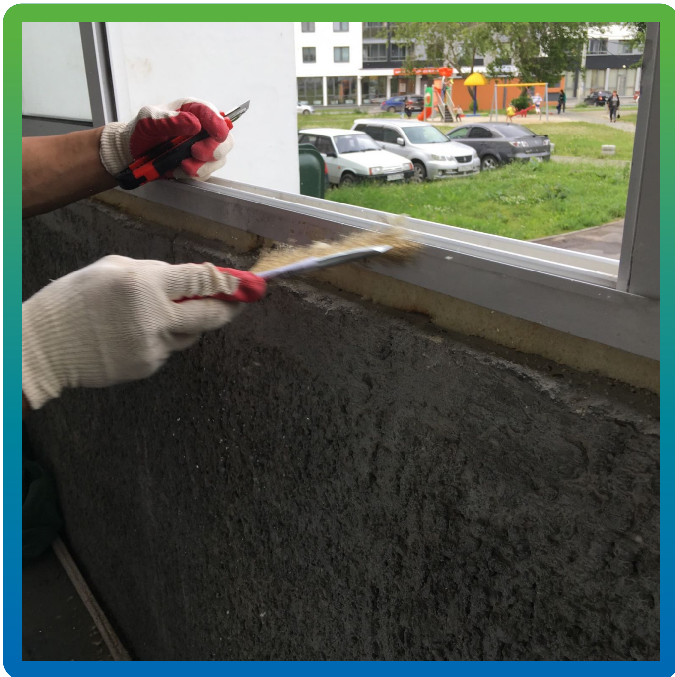
Очистка проема от монтажной пены на требуемую глубину
