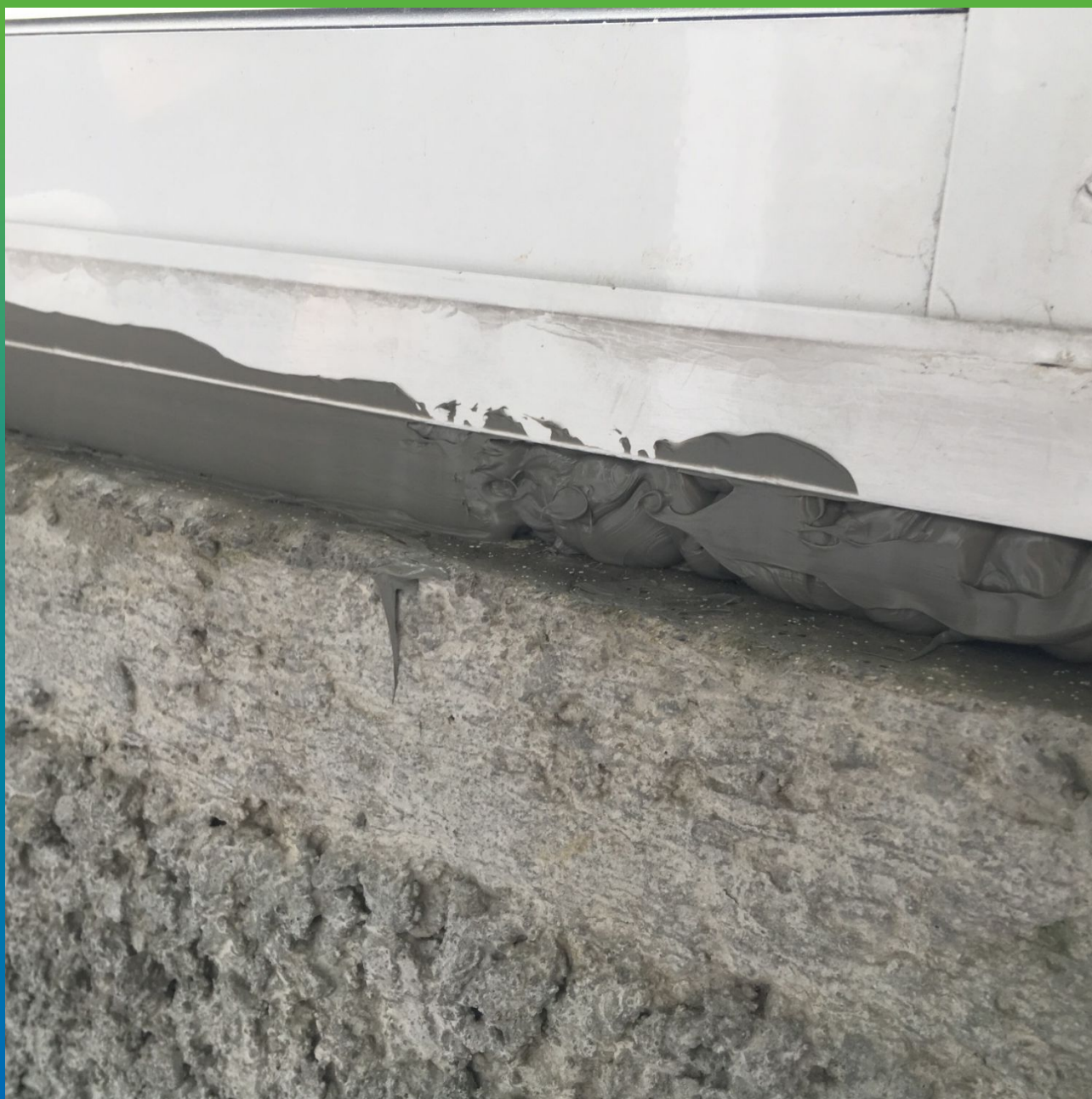
Процесс заглаживания герметика Витрафин Бонд X серый
