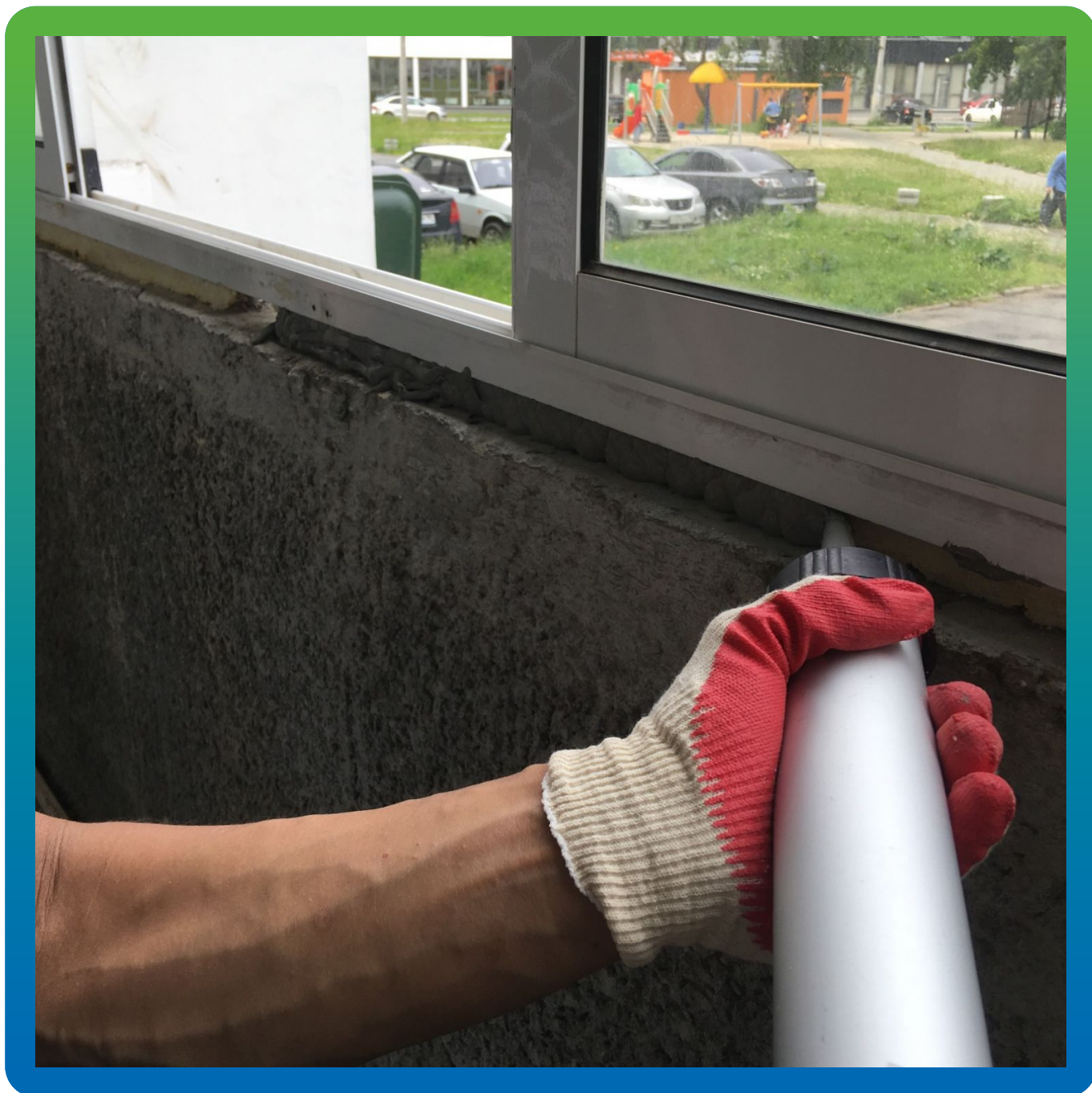
Нанесение герметика с помощью пистолета
