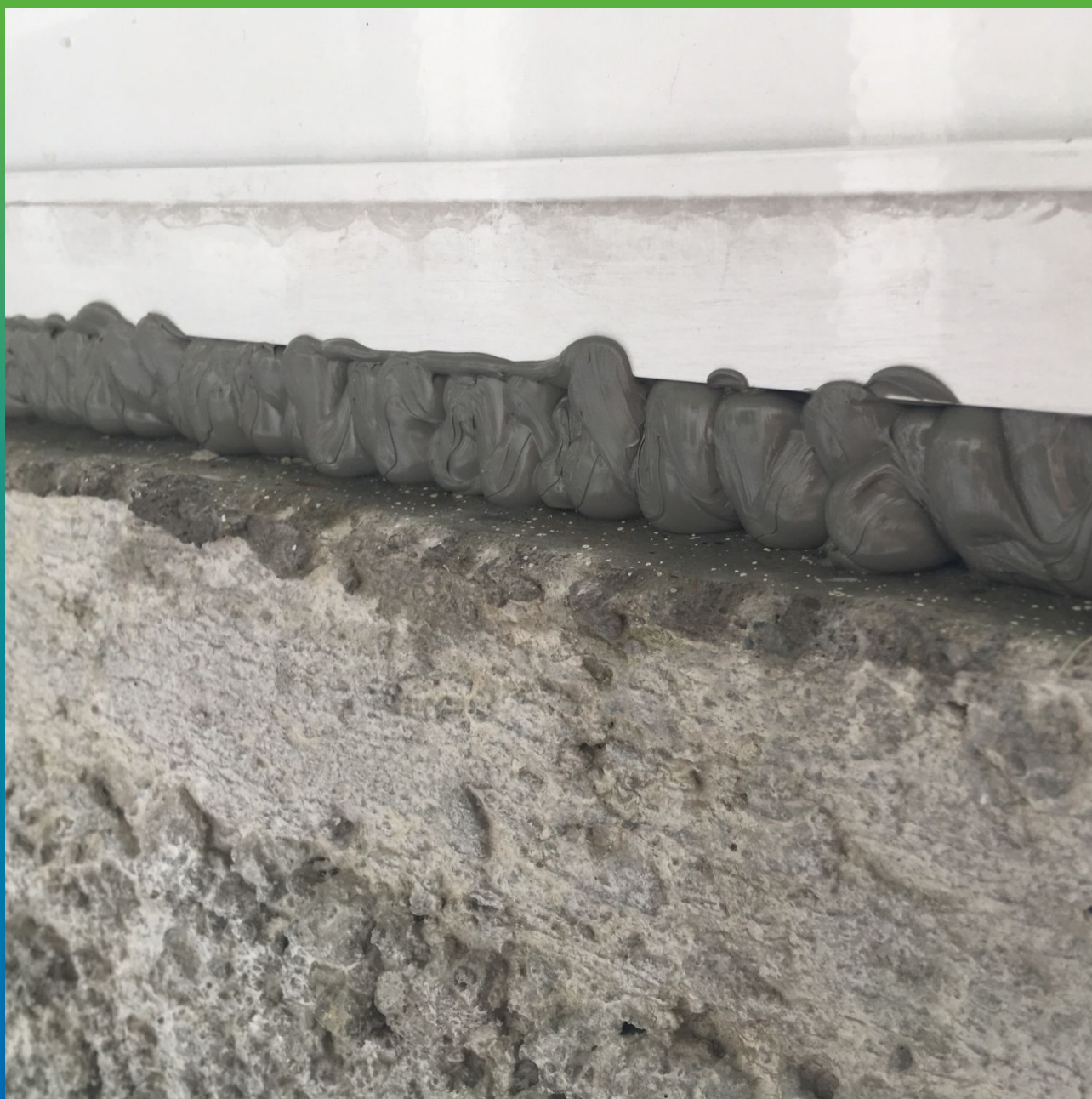
Участок с нанесенным герметиком Витрафин Бонд Х серый
