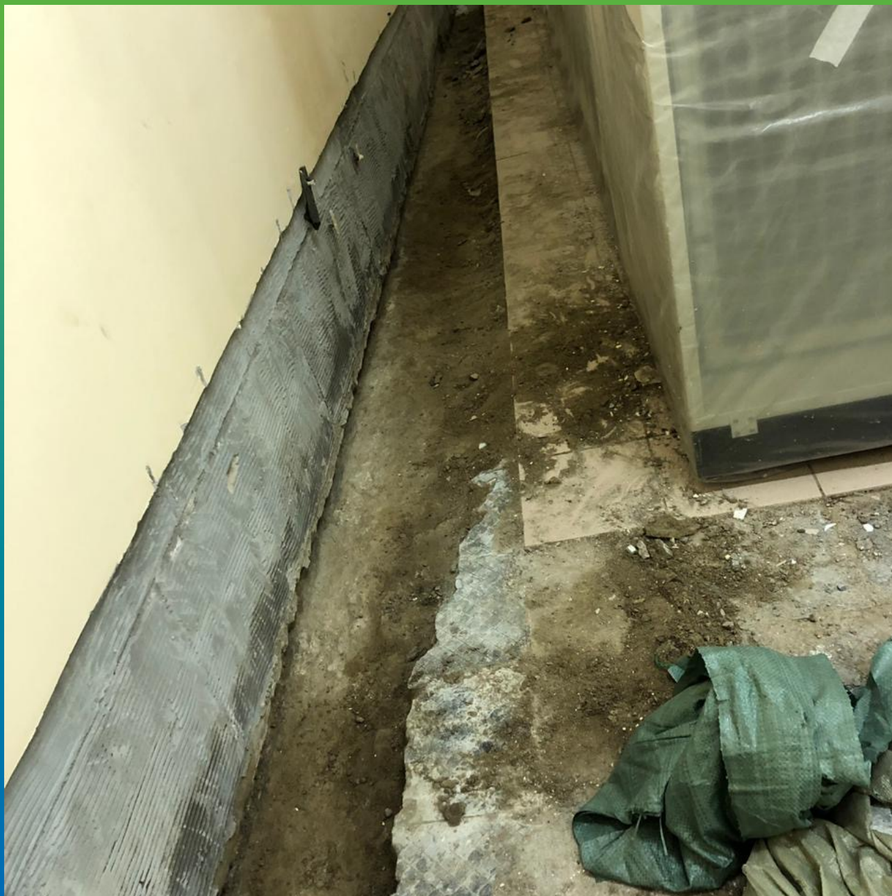
Очистка шва для последующих работ
