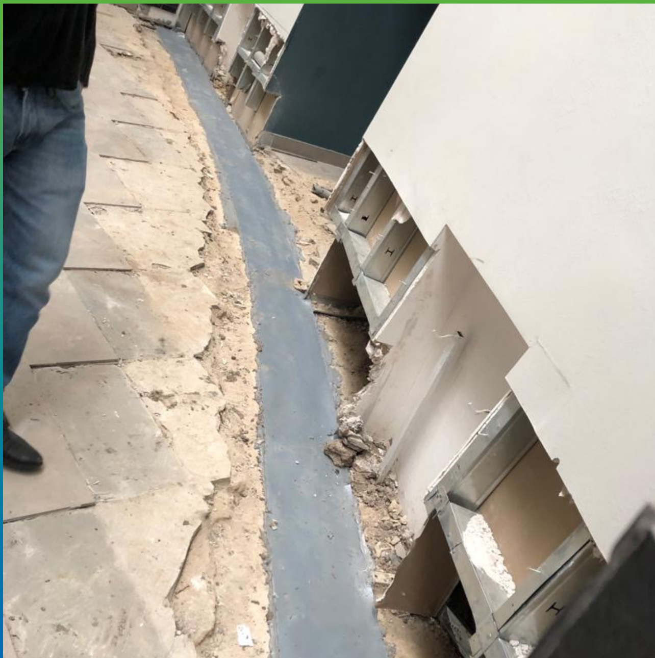
Финишный вид отремонтированного и загидроизолированного шва.
