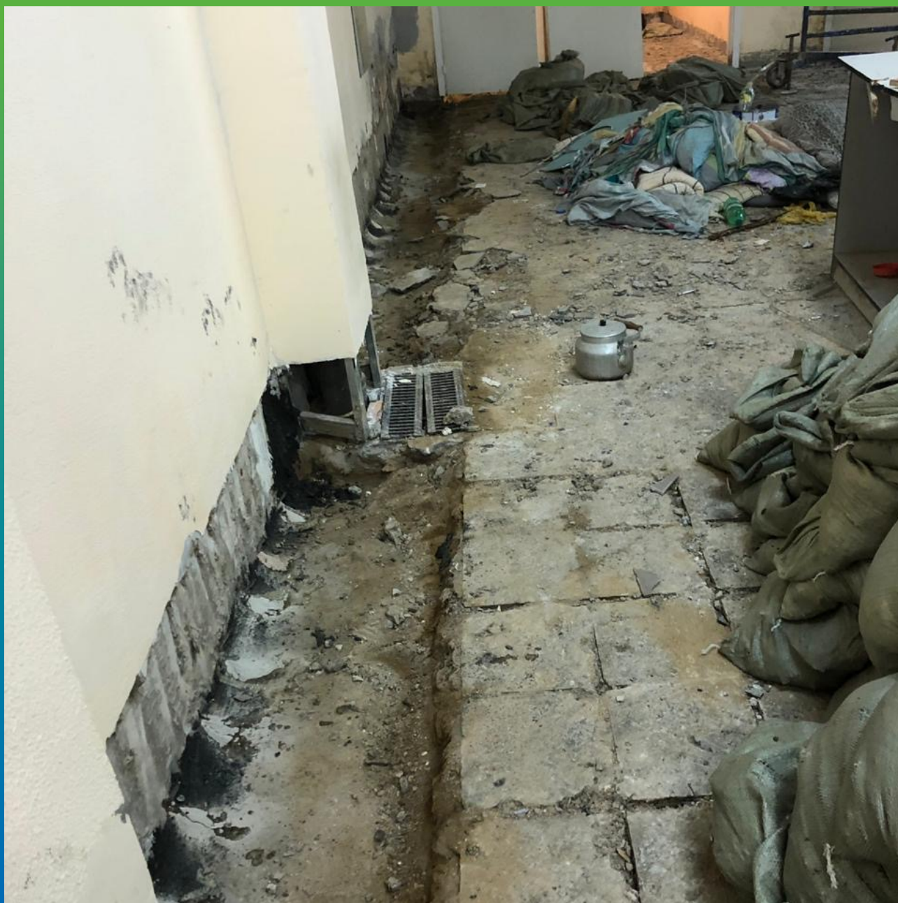
Подготовленный шов к гидроизоляции
