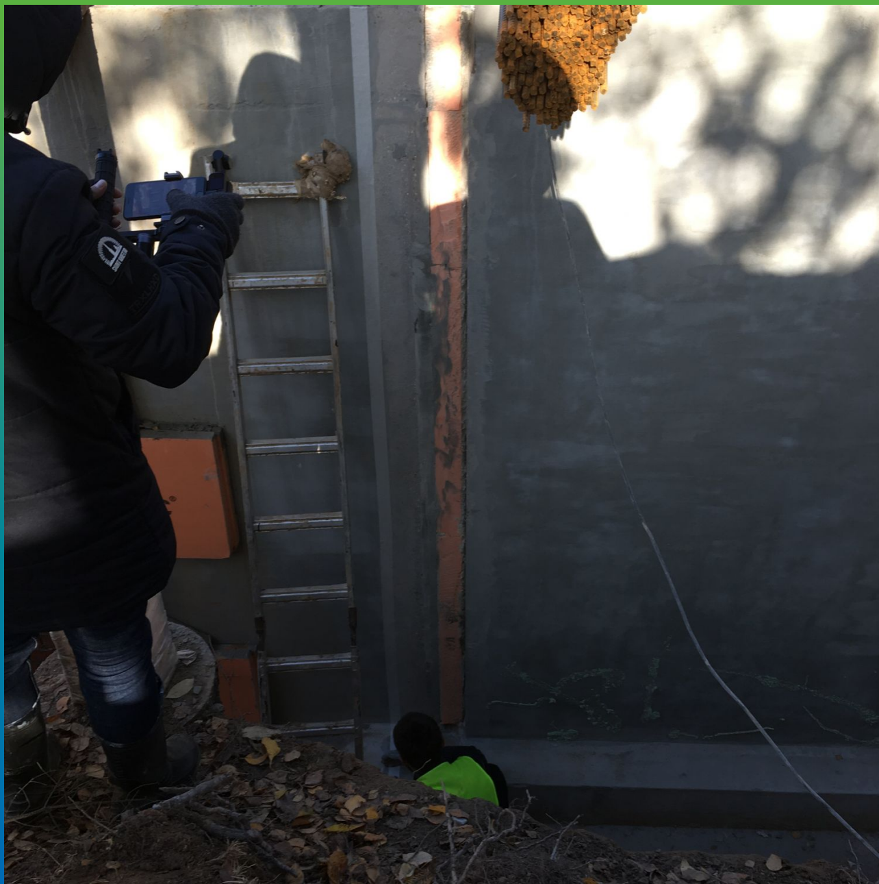
Оклейка малярной ленты для сбора излишек клея
