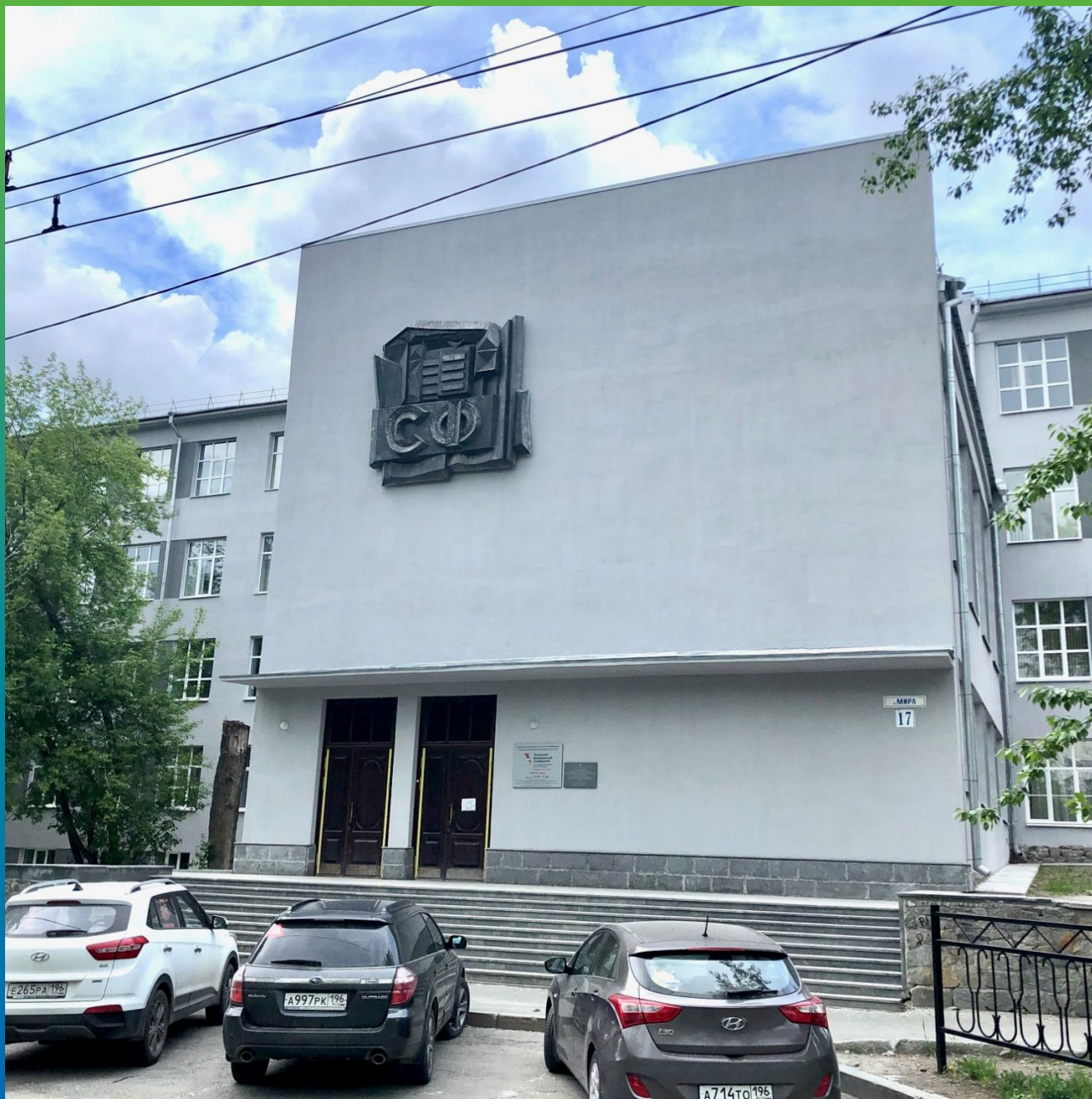
Вид здания после ремонта
