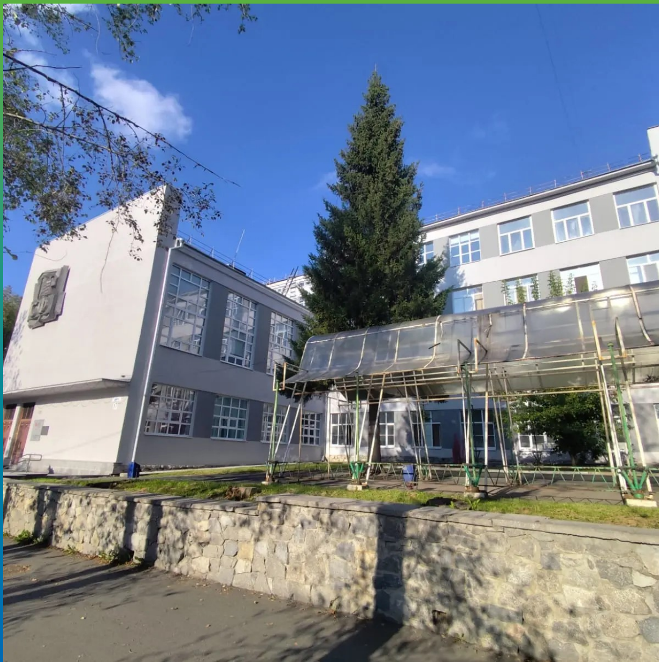
Внешний вид объекта после 5 лет эксплуатации
