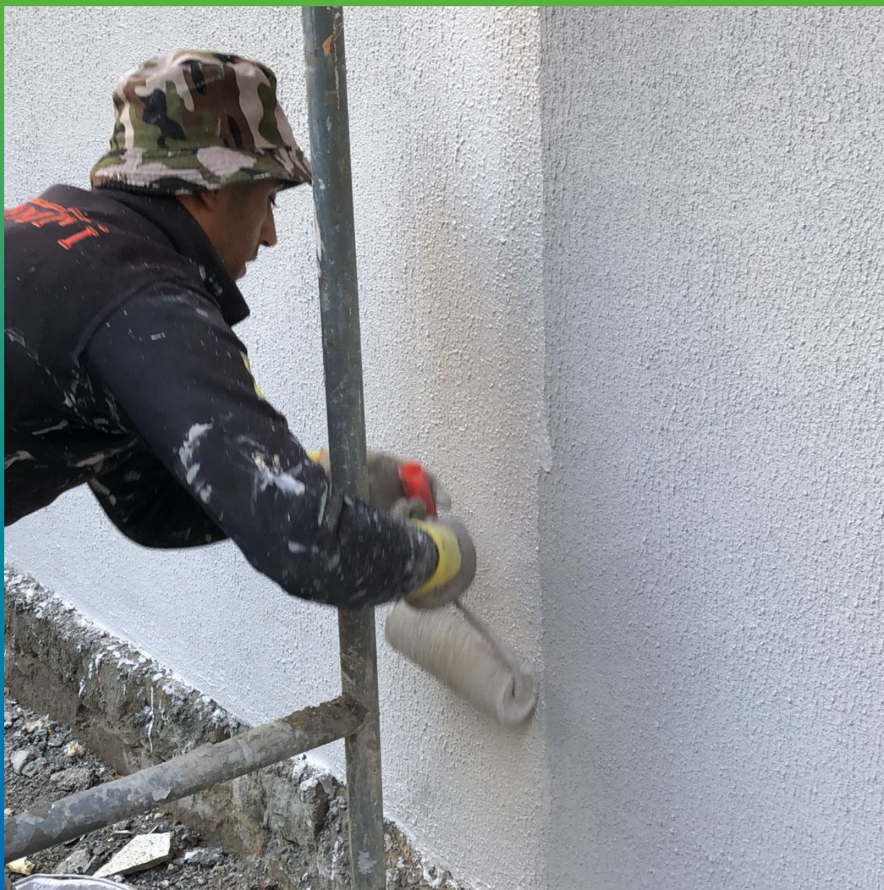
Нанесение финишного Денстоп АК 223 Силко
