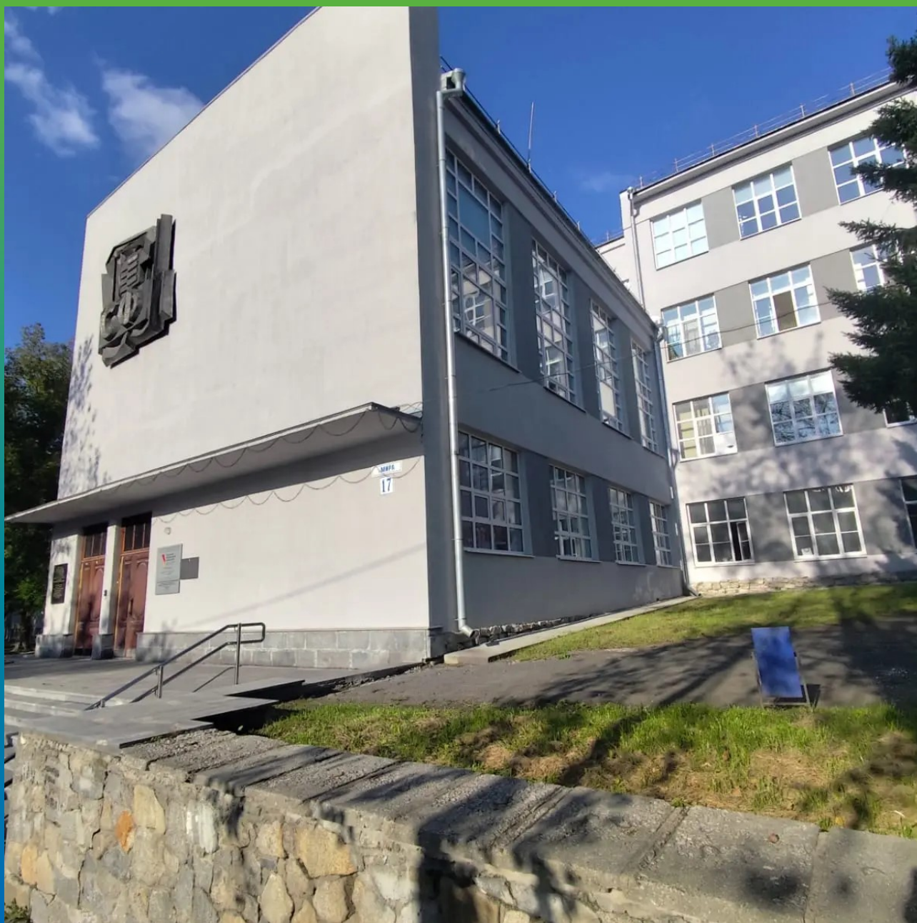
Внешний вид объекта после 5 лет эксплуатации
