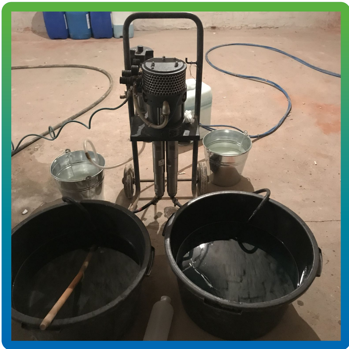
Подготовка насоса к инъектированию
