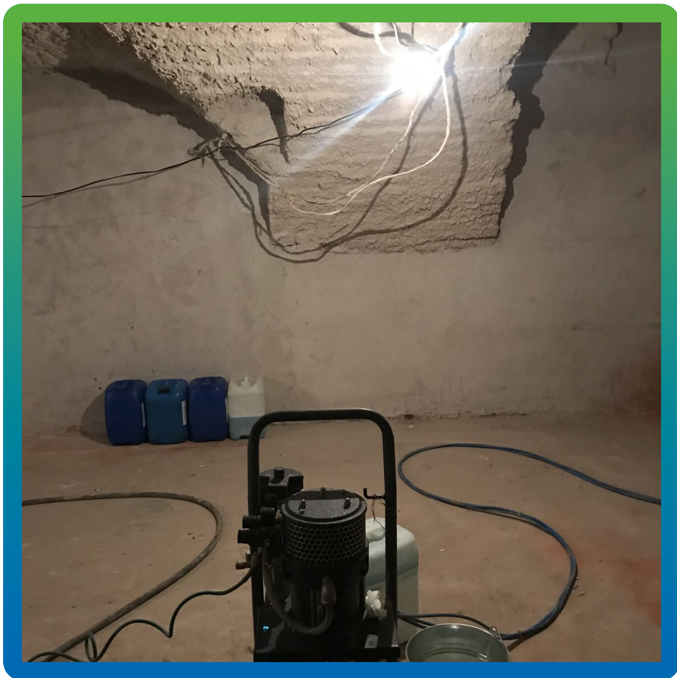
Вид стены после инъектирования
