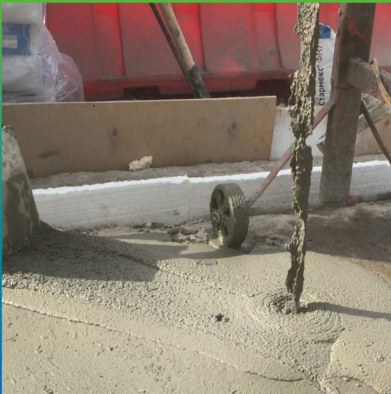
Заливка Стармекс ФМ7
