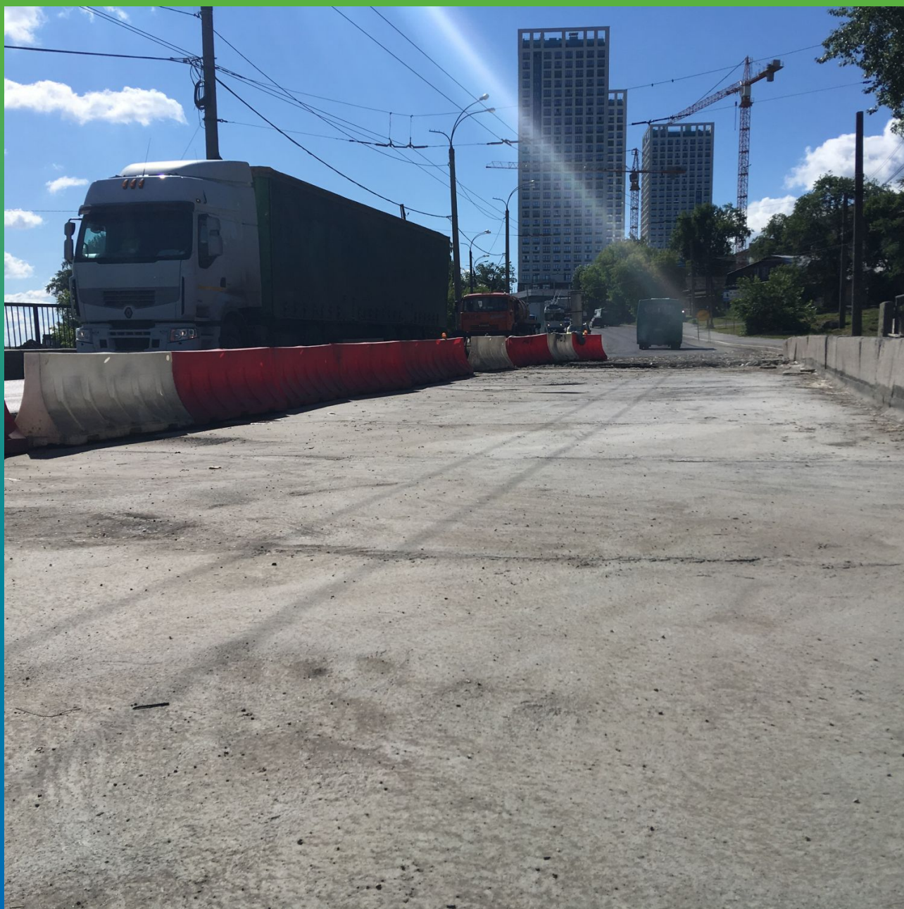
Вид защитного слоя гидроизоляции, выполненного из Стармекс ФМ7
