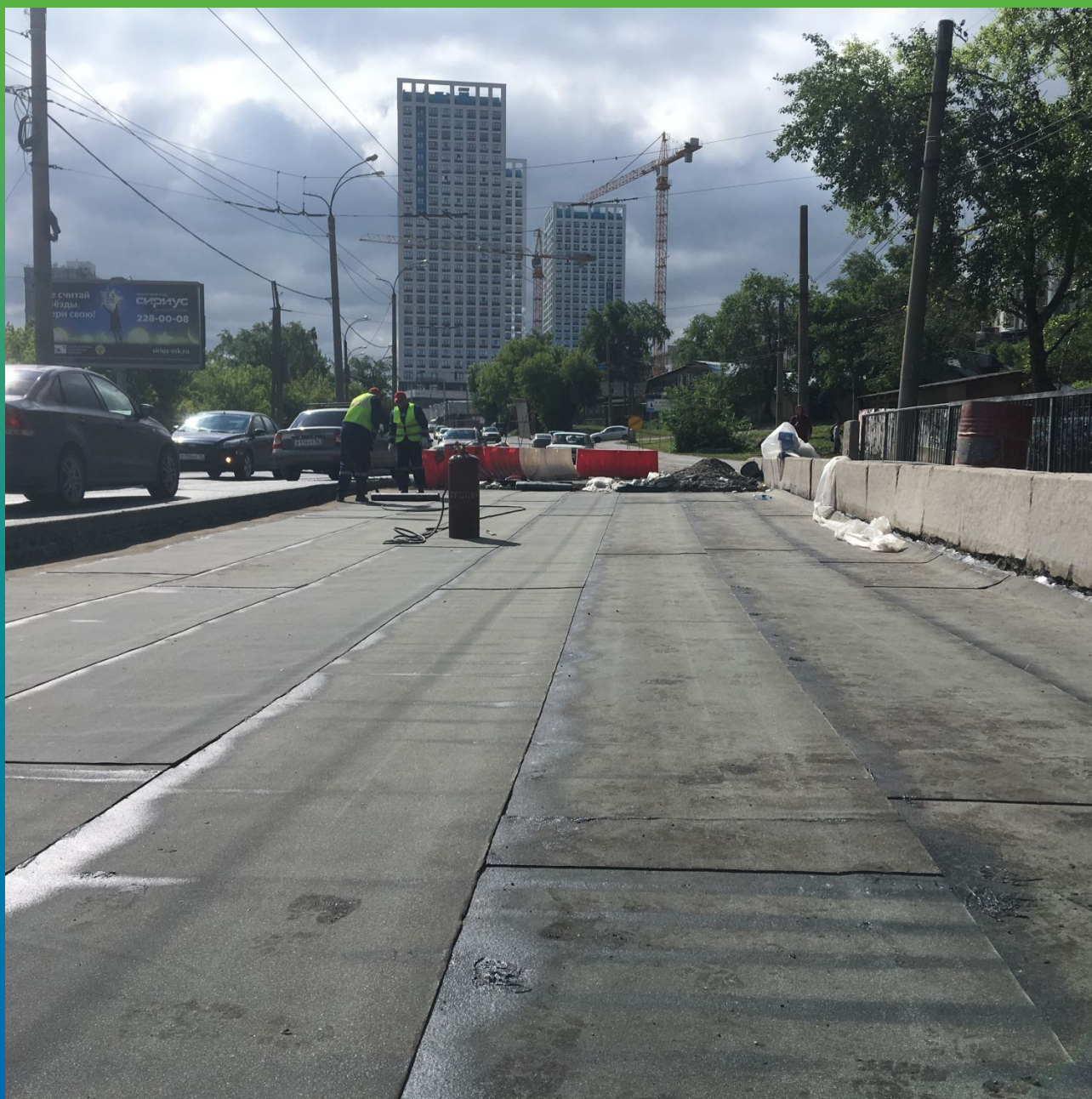
Монтаж гидроизоляции по выравнивающему слою из Стармекс ФМ7
