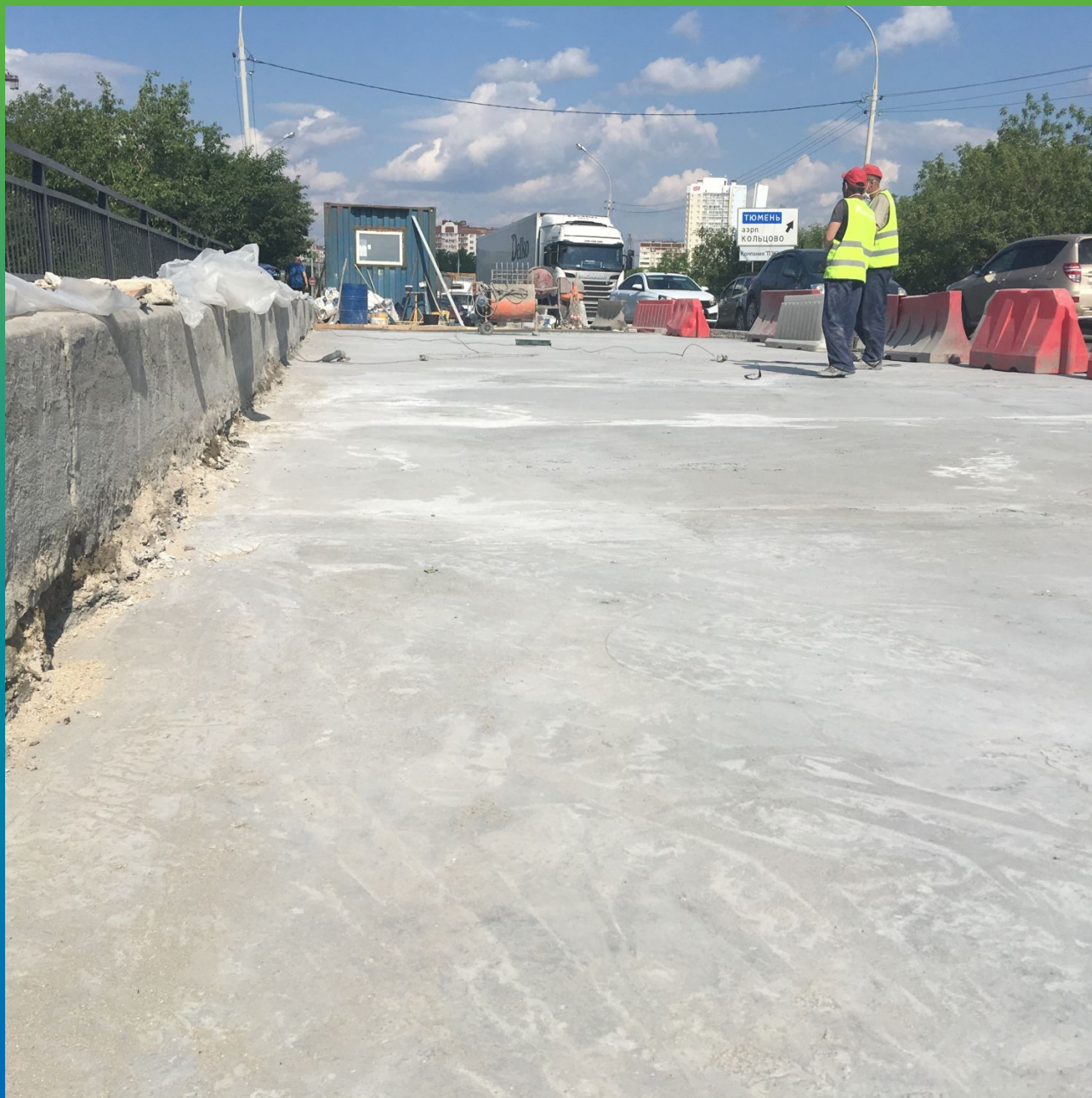
Финальный вид отремонтированного основания с помощью Стармекс ФМ7
