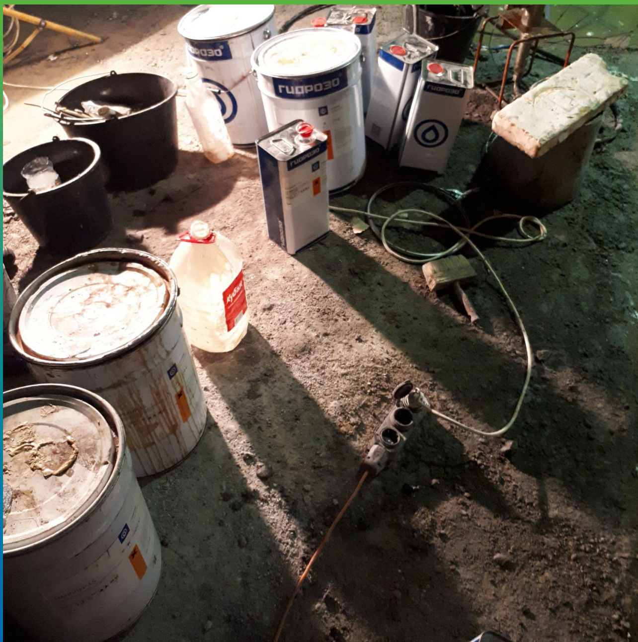
Материалы Гидрозо на объекте
