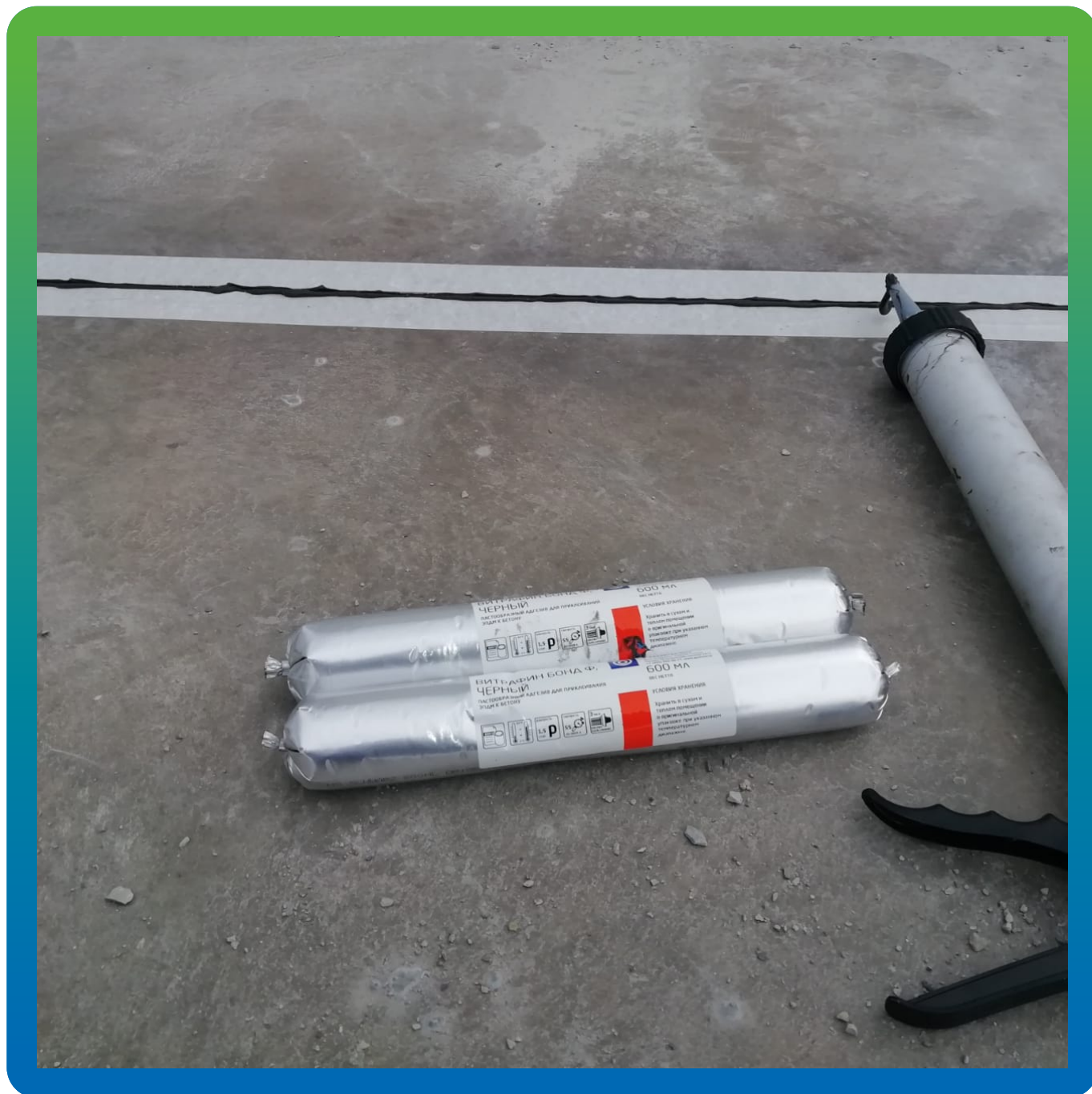
Герметизация усадочных швов герметиком Витрафин Бонд Ф
