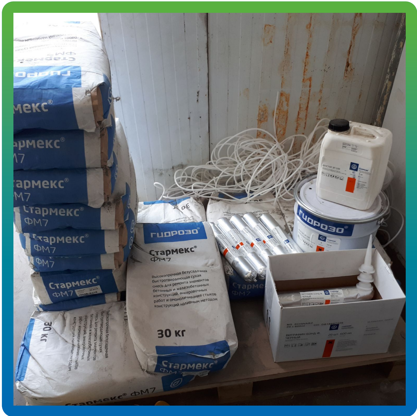
Материалы Гидрозо на объекте
