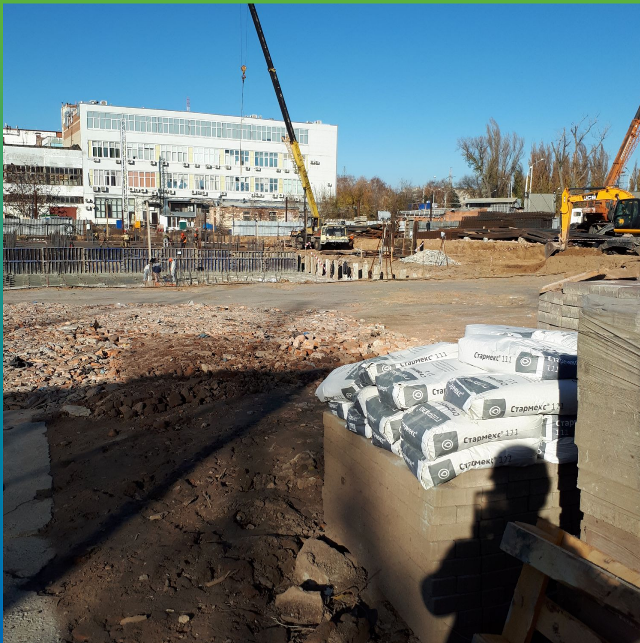
Материалы Гидрозо на объекте
