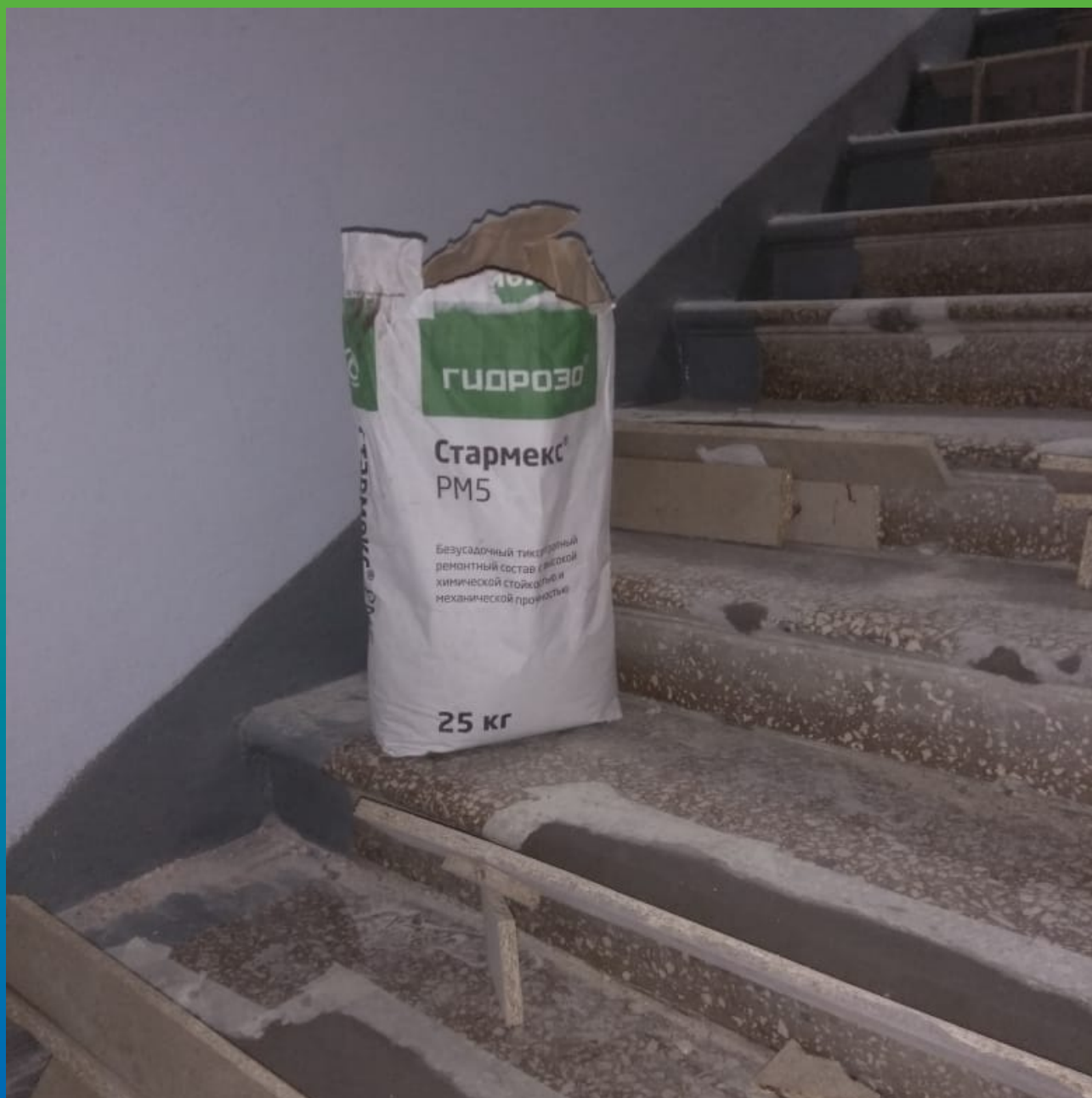
Восстановление ступенек составом Стармекс PM5 с добавлением мраморной крошки
