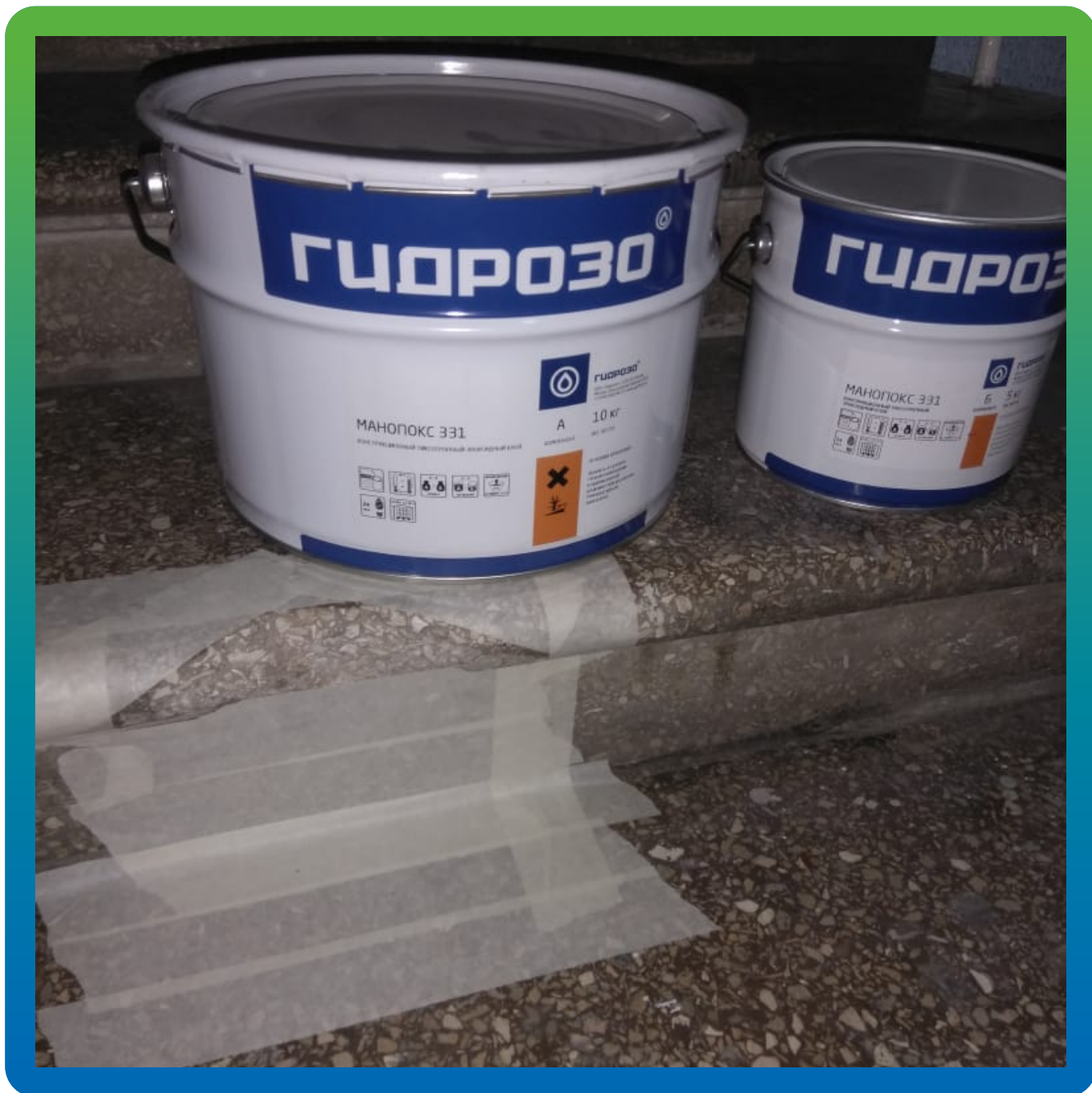
Материалы Гидрозо на объекте
