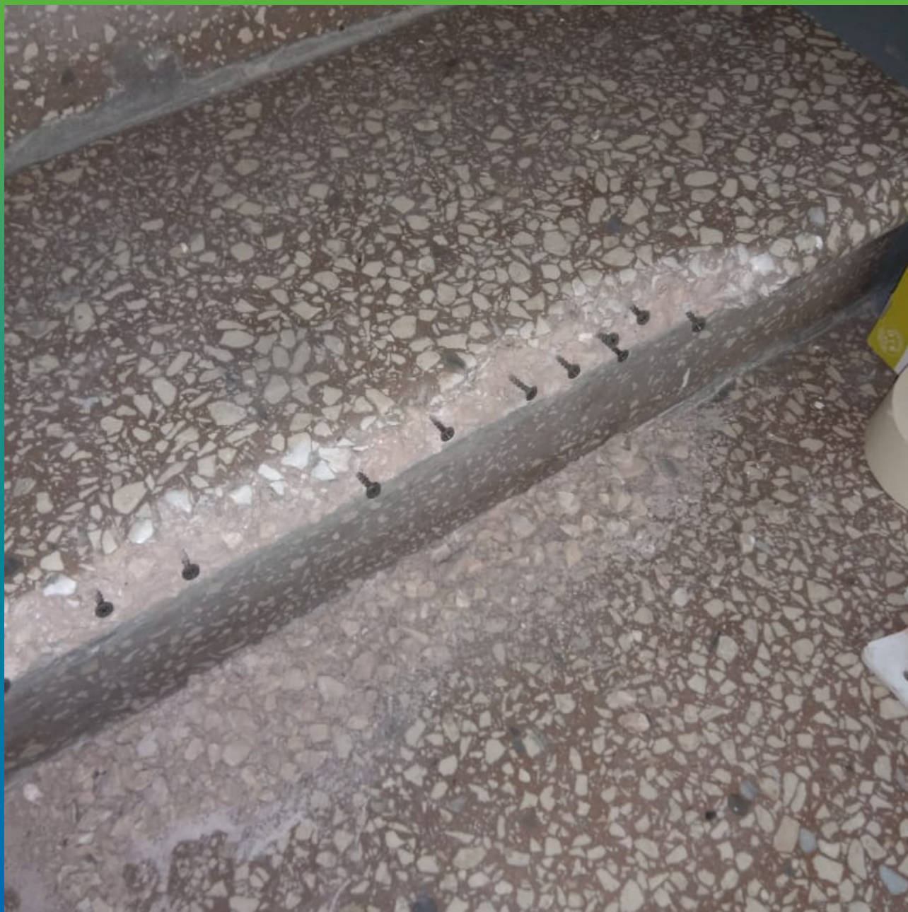
Армирование саморезами перед ремонтными работами
