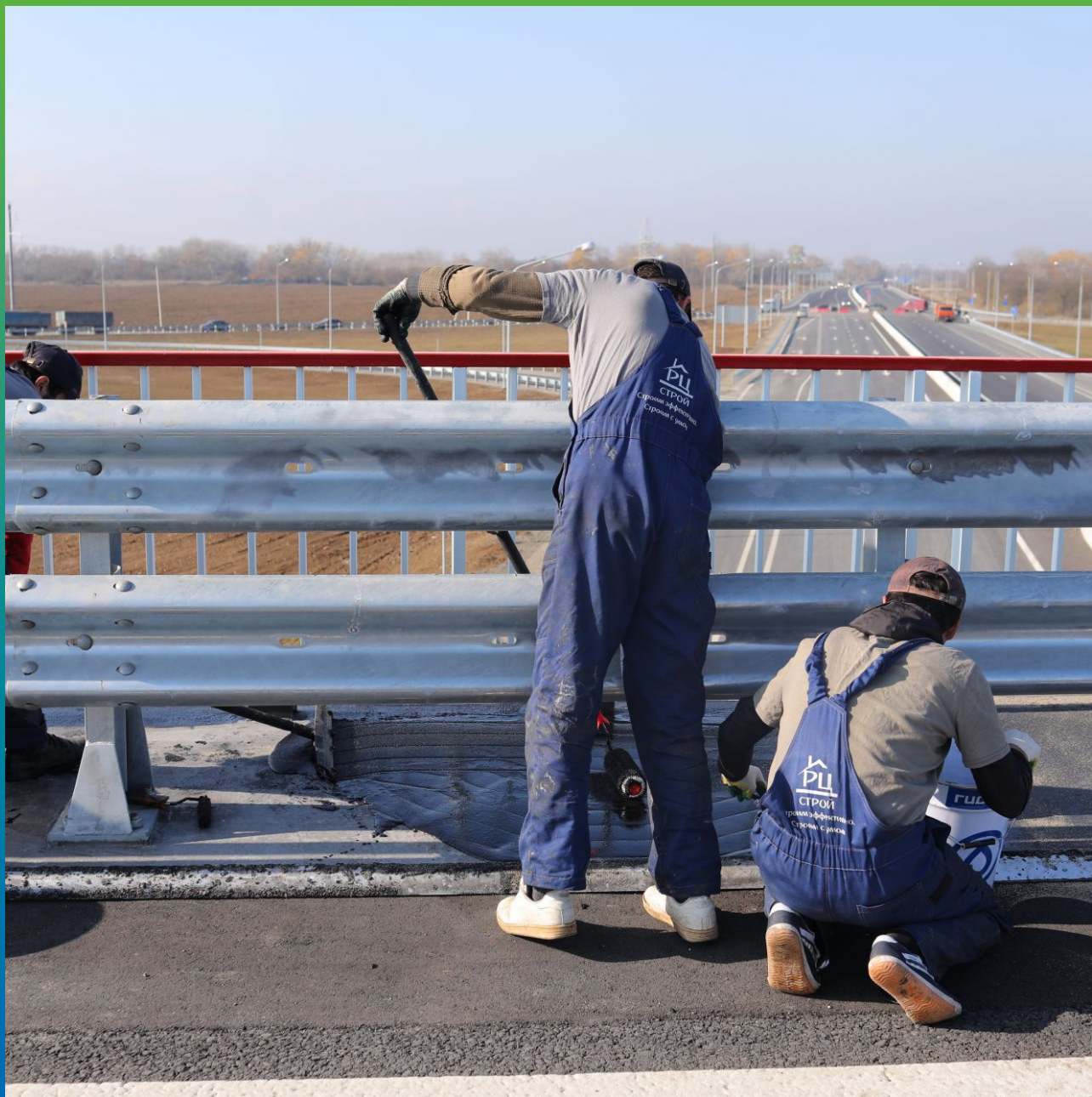
Нанесение основы системы материала ДенТоп ЭП 710 Мاستик.
