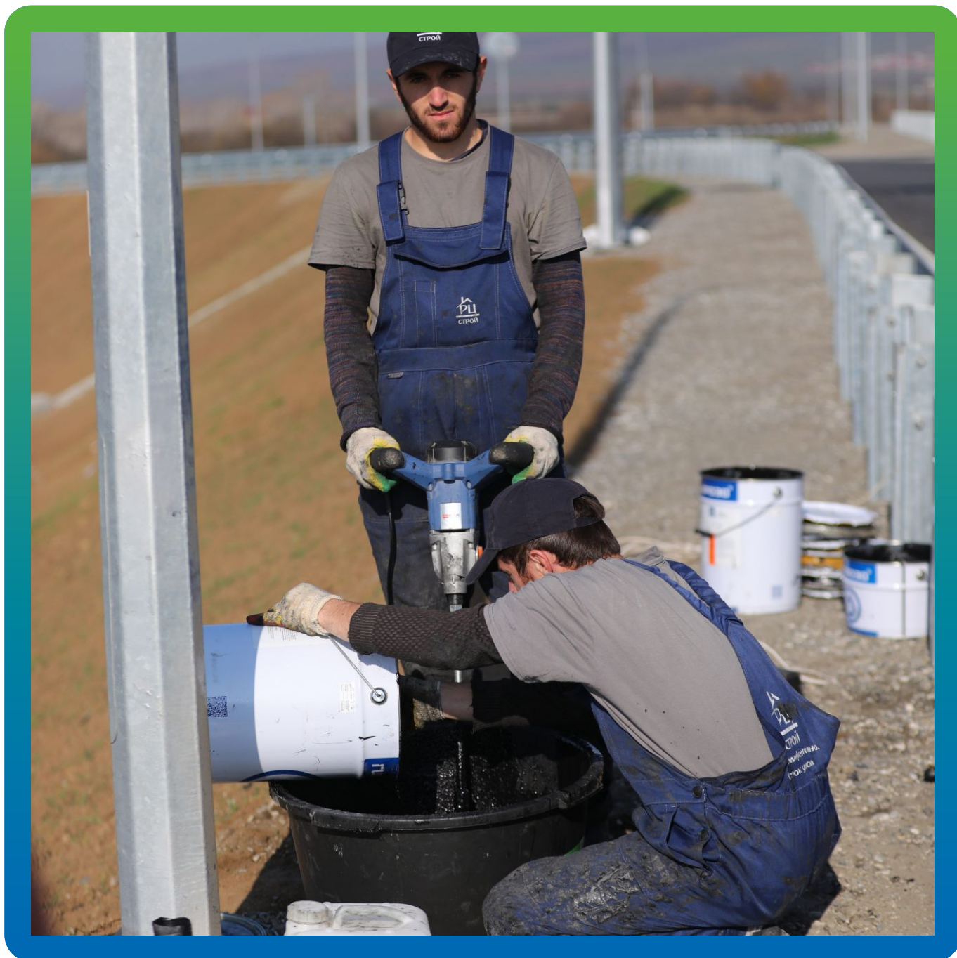
Замешивание состава ДенсТоп ЭП 710 Мастик с ДенсТоп Филлер 004.
